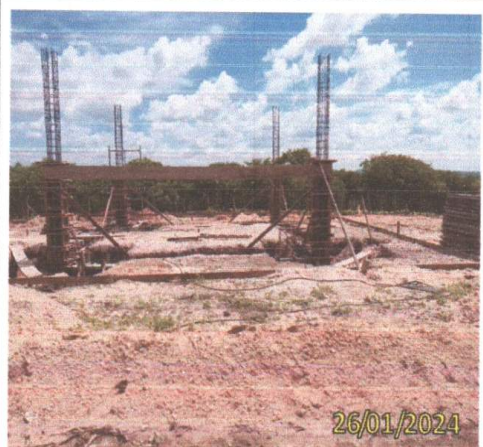
FOTO 1.20 – VISTA FRONTAL DO TRAVAMENTO DOS PILARES.
