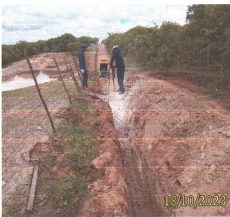
FOTO 3.5 – VISTA FRONTAL DA ESCAVAÇÃO.
