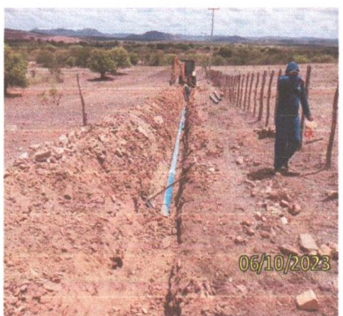
FOTO 2.6 – FOTO 1.4 – VISTA DO ATERRO.
