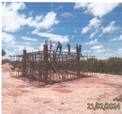
FOTO 1.23 – VISTA EM PERSPECTIVA DAS FERRAGENS DAS VIGAS.
