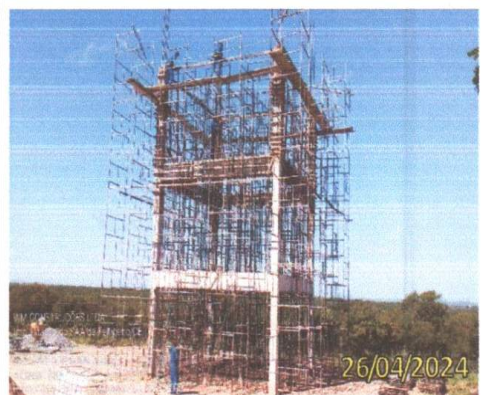
FOTO 1.35 – VISTA FRONTAL DA CONCRETAGEM DOS PILARES.
