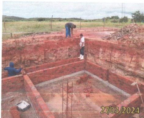
FOTO 4.23 – VISTA EM PERSPECTIVA DO ASSENTAMENTO DA ALVENARIA DO LEITO DRENANTE.
