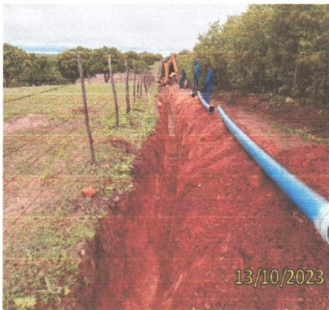
FOTO 3.3 – LOCAÇÃO DO TUBOS NA BARREIRA DA VALA.
