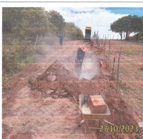
FOTO 3.8 – VISTA FRONTAL DA ESCAVAÇÃO DA VALA.
