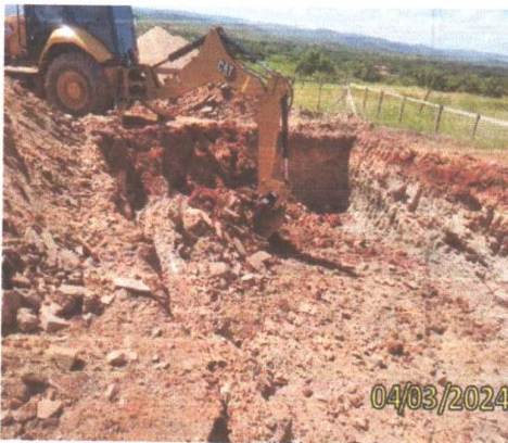
FOTO 4.15 – ESCAVAÇÃO DO LEITO DRENANTE COM AUXÍLIO DA RETROESCAVADEIRA.
