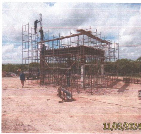
FOTO 1.25 – VISTA EM PERSPECTIVA DA MONTAGEM DAS FERRAGENS DO PILAR.
