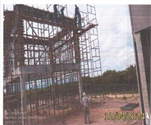
FOTO 1.33 – VISTA EM PERSPECTIVA DA CONCRETAGEM DAS VIGAS.
