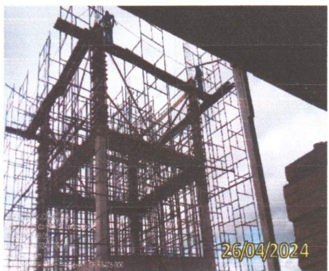
FOTO 1.36 – VISTA EM PERSPECTIVA DA CONCRETAGEM DOS PILARES.
