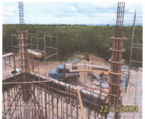
FOTO 1.28 – VISTA EM PERSPEQUIVA DA FINALIZAÇÃO DA CONCRETAGEM.
