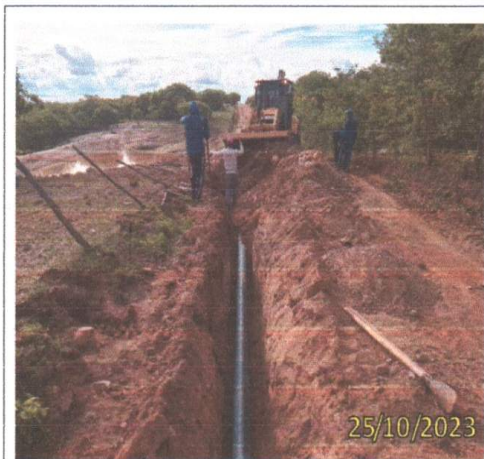
FOTO 3.7 – ATERRO DA VALA.
