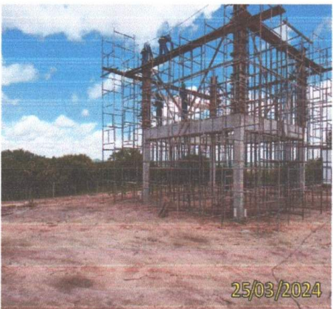
FOTO 1.29 – MONTAGEM DAS FORMAS DAS VIGAS.
