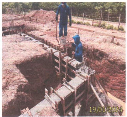
FOTO 1.18 – CONCRETAGEM DAS VIGAS.
