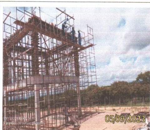
FOTO 1.32 – VISTA EM PERSPECTIVA DAS FORMAS DA VIGA.
