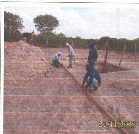
FOTO 1.7 – MONTAGEM DO GABARITO.
