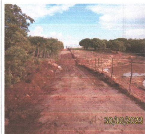
FOTO 3.9 – ESCAVAÇÃO E ATERRO FINALIZADO.
