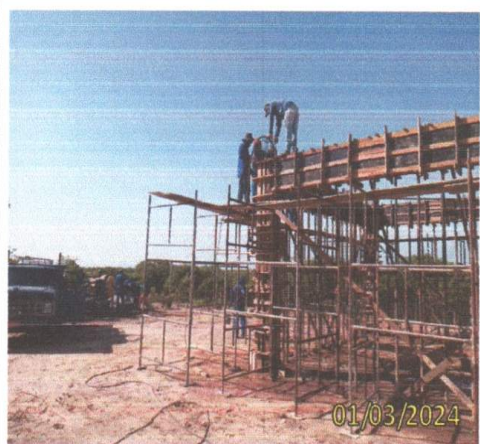
FOTO 1.24 – CONCRETAGEM DA VIGA.
