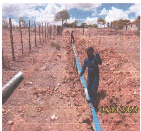
FOTO 2.5 – VISTA FRONTAL DA LOCAÇÃO DOS TUBOS NA VALA.
