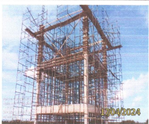
FOTO 1.34 – VISTA EM PERSPECTIVA DA MONTAGEM DAS FORMAS DOS PILARES.
