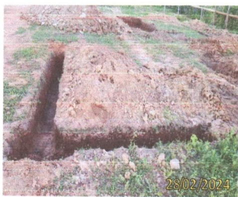
FOTO 4.13 – ESCAVAÇÃO DA FUNDAÇÃO DA CASA DE BOMBAS
