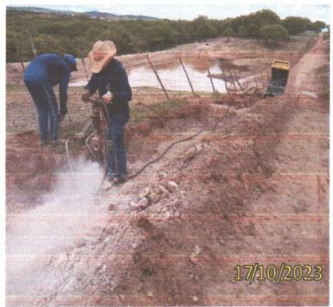
FOTO 3.4 – VISTA EM PERSPECTIVA DA ESCAVAÇÃO EM MATERIAL DE TERCEIRA CATEGORIA.
