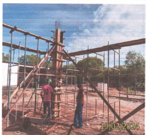
FOTO 1.22 – VISTA EM PERSPECTIVA DAS FORMAS DAS VIGAS.
