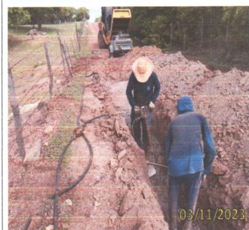
FOTO 3.11 – VISTA FRONTAL DA ESCAVAÇÃO.
