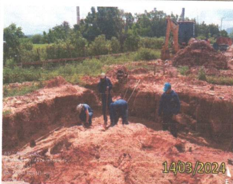
FOTO 4.17 – ESCAVAÇÃO DO POÇO DE SUÇÃO.
