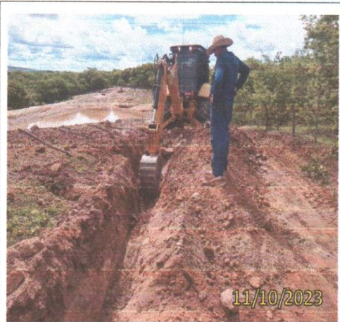
FOTO 3.2 – VISTA FRONTAL DA ESCAVAÇÃO DA VALA.
