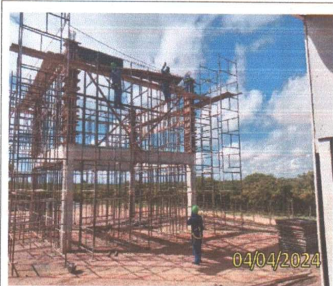
FOTO 1.31 – MONTAGEM DAS FORMAS NAS VIGAS.
