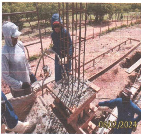
FOTO 1.21 – DETALHE DA EXECUÇÃO DA CONCRETAGEM DOS PILARES.
