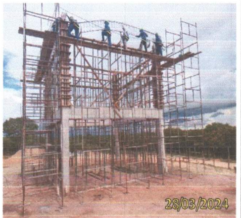
FOTO 1.30 – VISTA DA MONTAGEM DAS FERRAGENS DAS VIGAS
