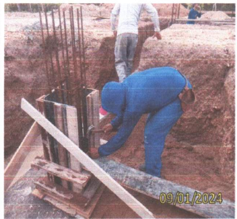
FOTO 1.16 – MONTAGEM DAS FORMAS.
