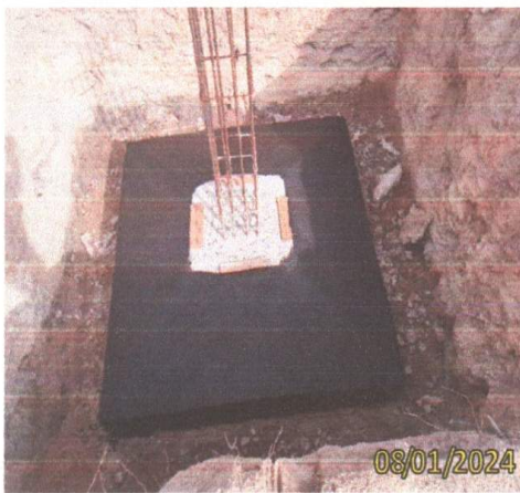
FOTO 1.15 – IMPERMEABILIZAÇÃO DA SAPATA.
