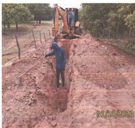
FOTO 3.10 – ESCAVAÇÃO DA VALA.
