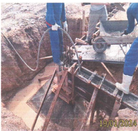
FOTO 1.17 – VIBRAÇÃO DO CONCRETO DA VIGA PARA ADENSAMENTO.
