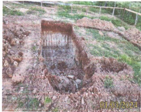
FOTO 4.14 – VISTA FRONTAL DA ESCAVAÇÃO DO POÇO DE SUÇÃO.
