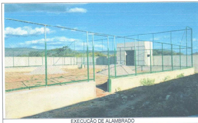
EXECUÇÃO DE ALAMEDADO
