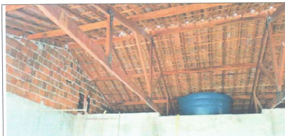
EXECUÇÃO DE COBERTURA
