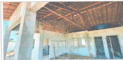
EXECUÇÃO DE COBERTURA
