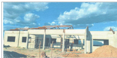
EXECUÇÃO DE ESTRUTURA DE MADEIRA
