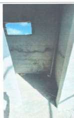
EXECUÇÃO DE BANHEIROS DA QUADRA
