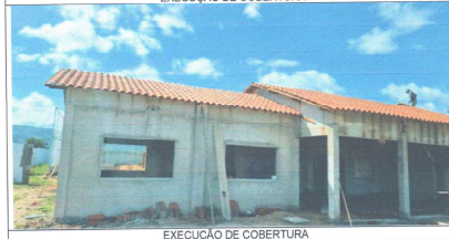
EXECUÇÃO DE COBERTURA
