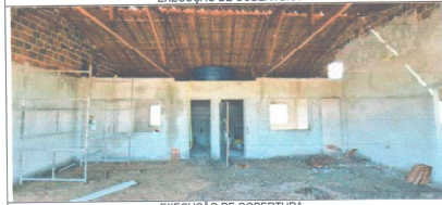
EXECUÇÃO DE COBERTURA
