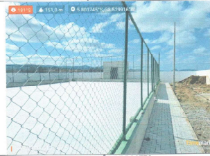
INSTALAÇÃO DE POSTES
