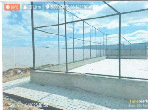
EXECUÇÃO DE ALAMBRADO
