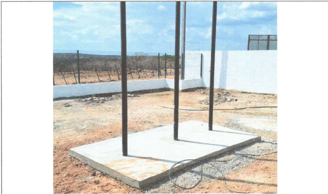
EXECUÇÃO DE MASTRO
