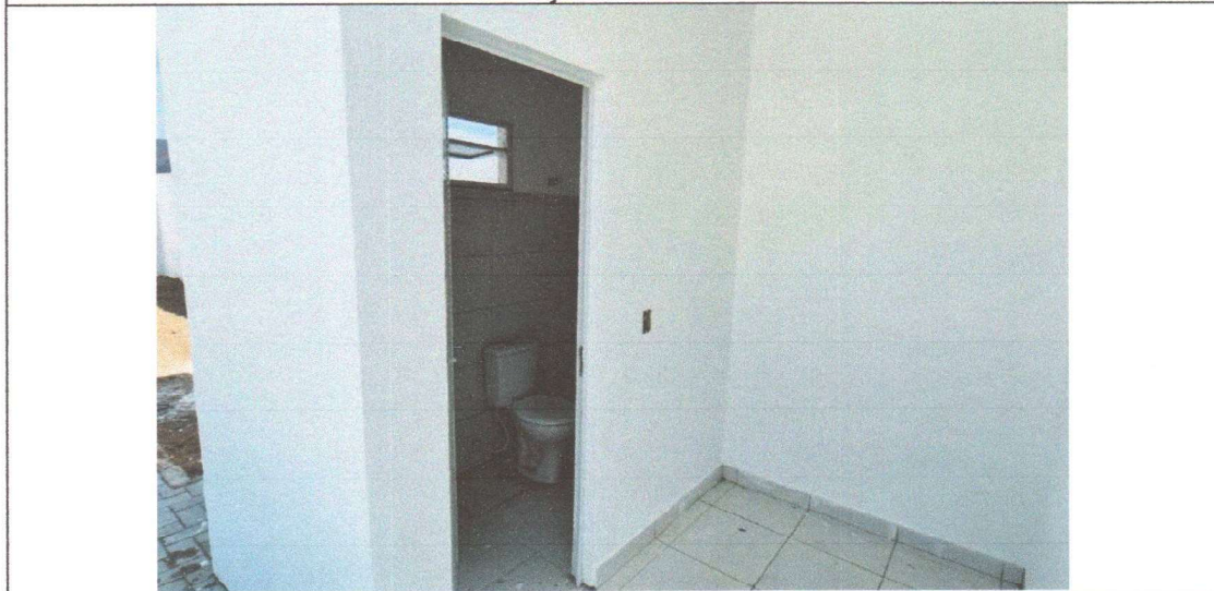
EXECUÇÃO DE PINTURA
