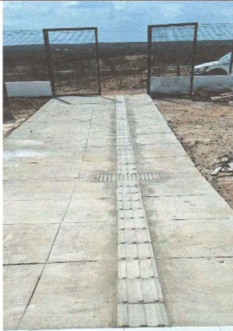
EXECUÇÃO DO PISO PODOTÁTIL EXTERNO
