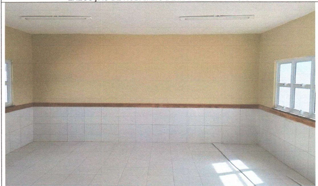
EXECUÇÃO DE RODAMEIO DE MADEIRA E PINTURA
