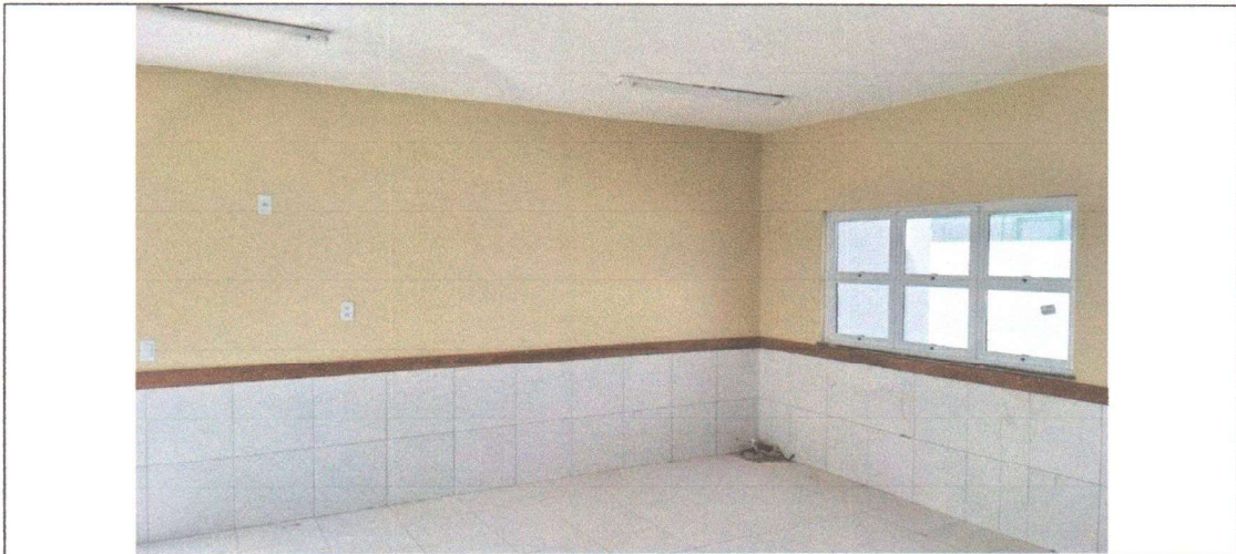
EXECUÇÃO DE RODAMEIO DE MADEIRA E PINTURA
