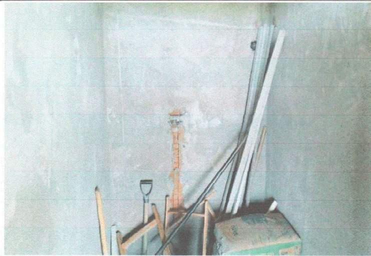
EXECUÇÃO DE INSTALAÇÕES HIDROSSANITÁRIAS
