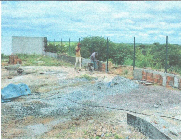
EXECUÇÃO DE MURETA DO GRADIL
