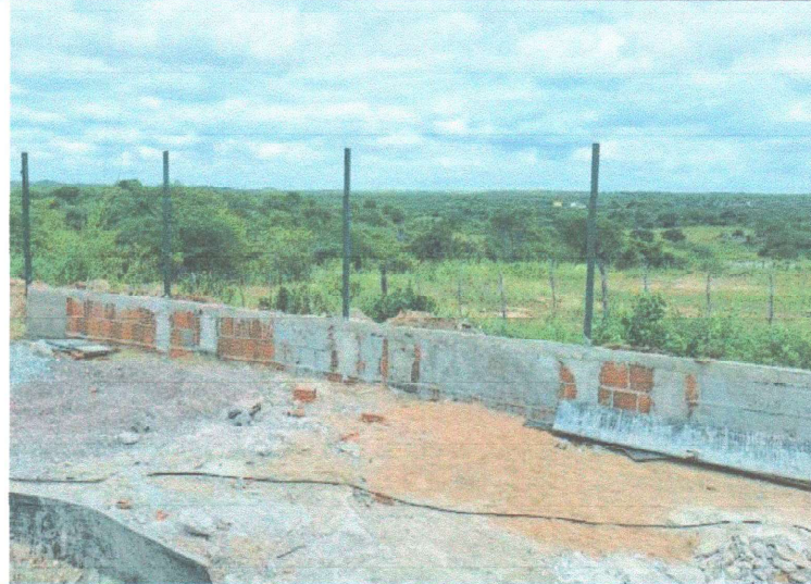
EXECUÇÃO DE MURETA DO GRADIL
