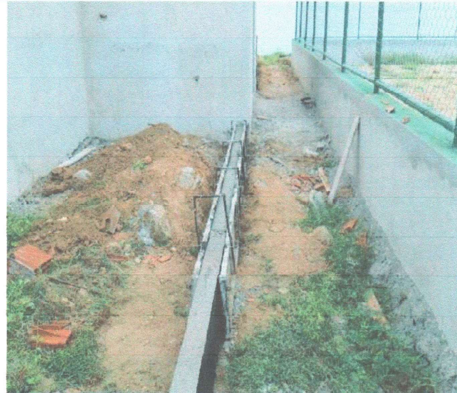
EXECUÇÃO DE MEIO FIO DA QUADRA
