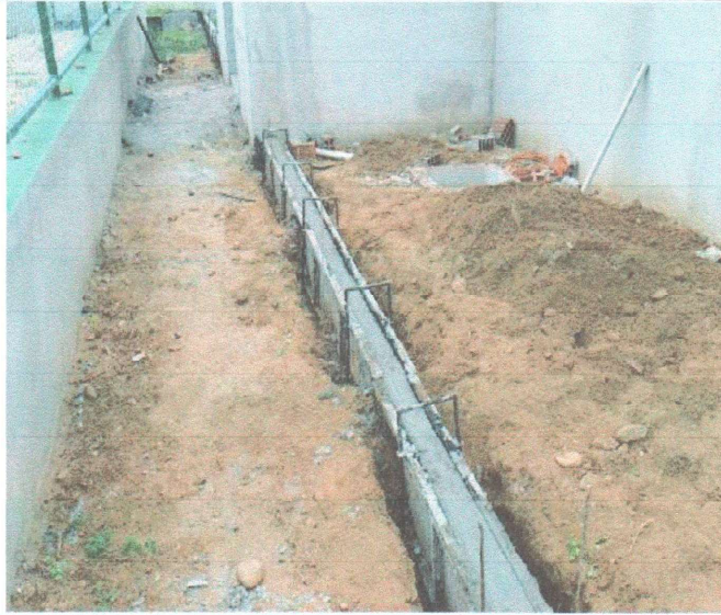
EXECUÇÃO DE MEIO FIO DA QUADRA
