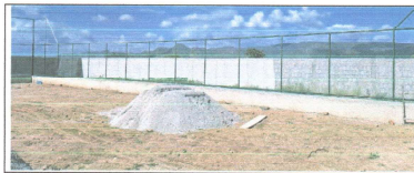
EXECUÇÃO DE ALAMBRADO
