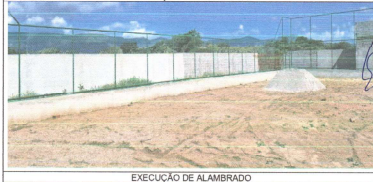
EXECUÇÃO DE ALAMBRADO
