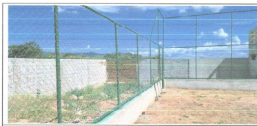
EXECUÇÃO DE ALAMBRADO
