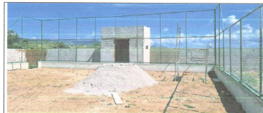
EXECUÇÃO DE ALAMBRADO
