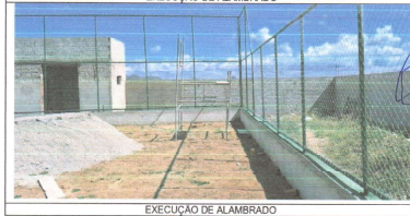
EXECUÇÃO DE ALAMBRADO
