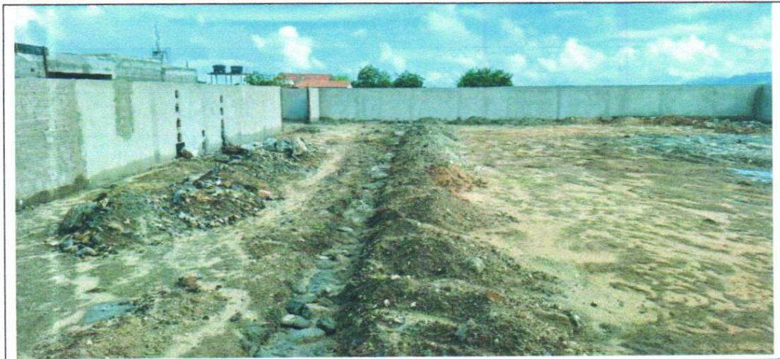
EXECUÇÃO DE ALVENARIA DE PEDRA PARA QUADRA
