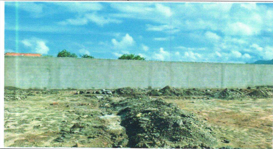
ALVENARIA DE PEDRA DA QUADRA
