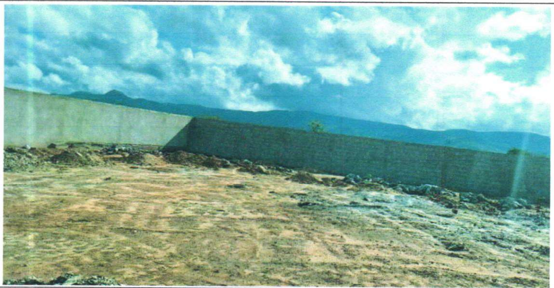
EXECUÇÃO DO MURO
