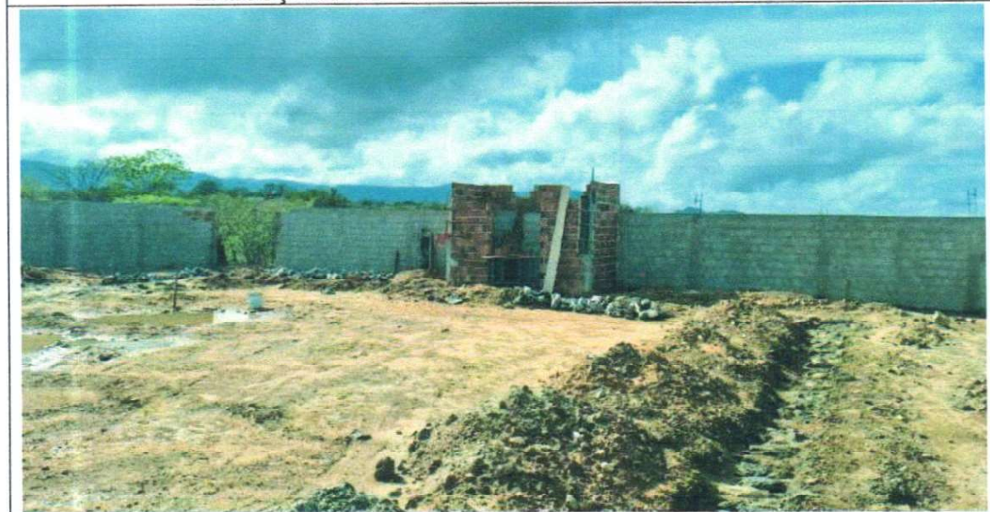
EXECUÇÃO DE ALVENARIA DE PEDRA DA QUADRA
