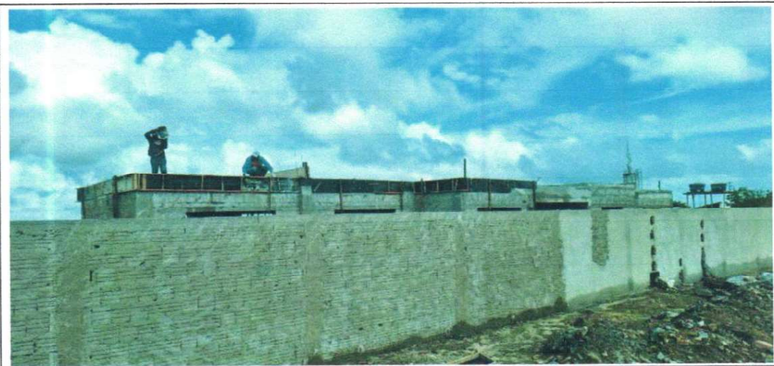
CONCRETAGEM DAS LAJES
