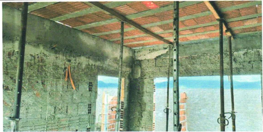
EXECUÇÃO DE ESCORAS PARA CONCRETAGEM DE LAJE
