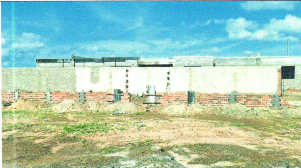
EXECUÇÃO DE MURETA DA QUADRA
