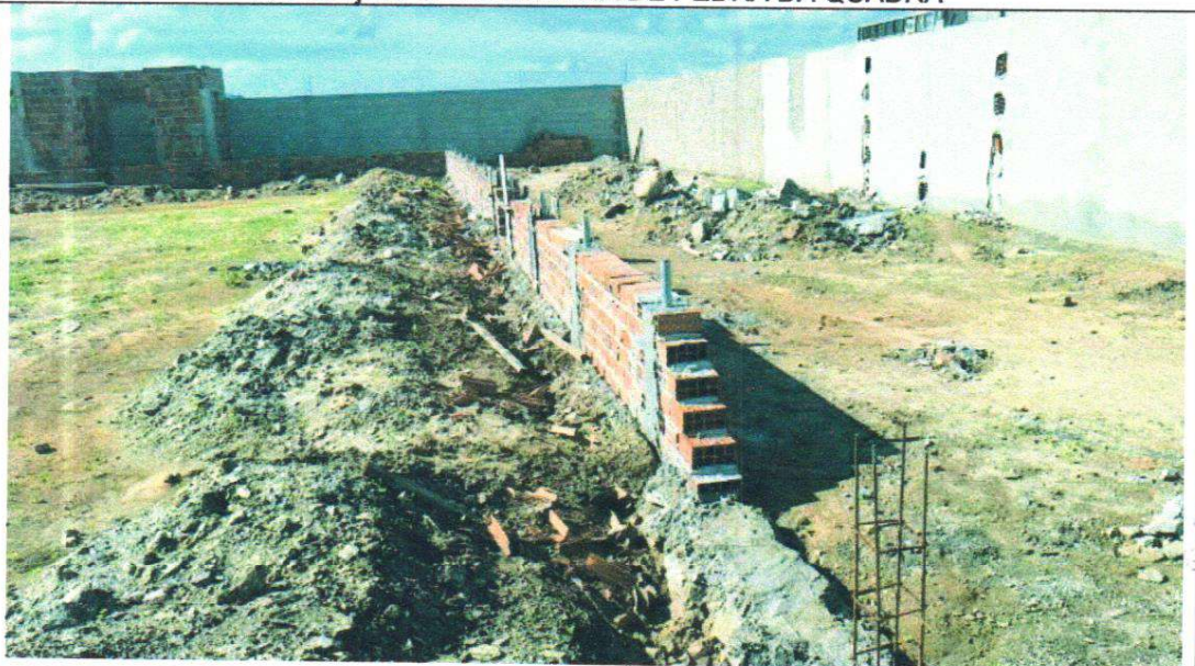
EXECUÇÃO DE MURETA DA QUADRA
