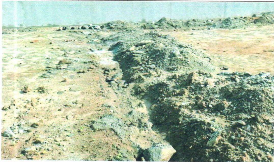
EXECUÇÃO DE ALVENARIA DE PEDRA DA QUADRA
