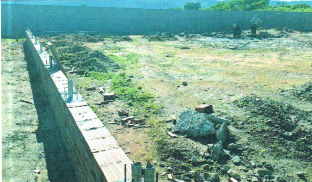
EXECUÇÃO DE MURETA DA QUADRA
