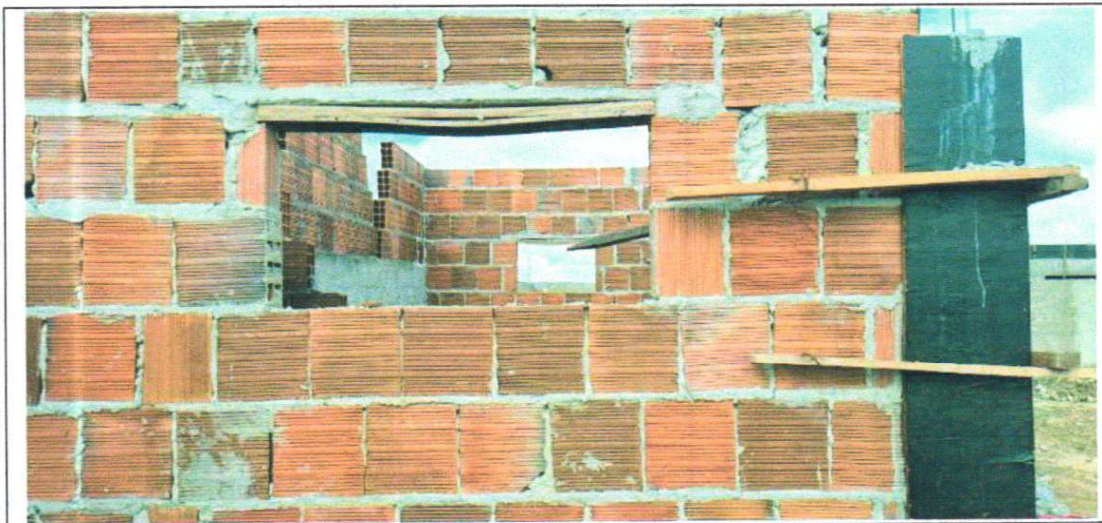
ALVENARIAS DO BANHEIRO DA QUADRA
