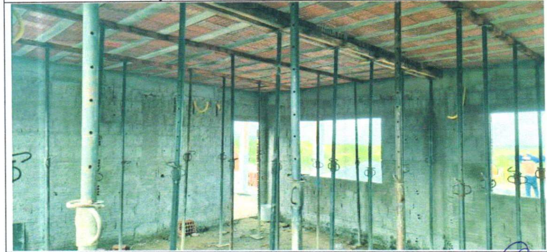
ESCORAS PARA CONCRETAGEM DAS LAJES
