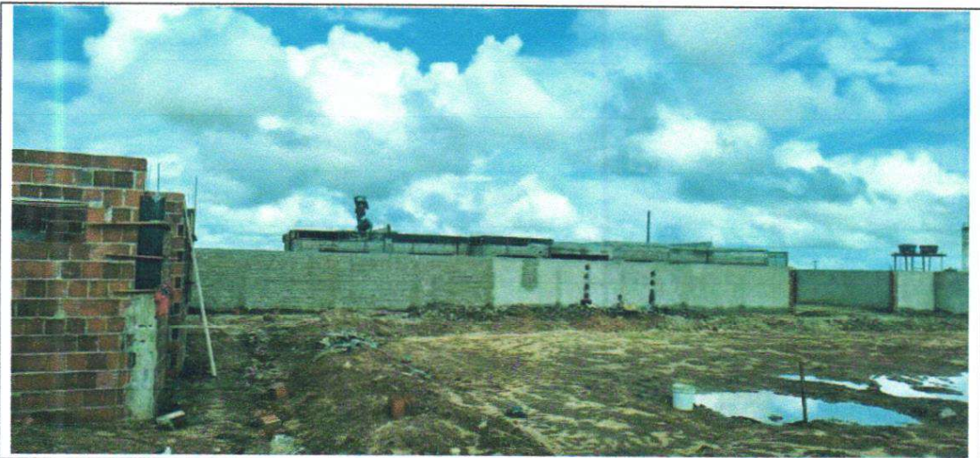
EXECUÇÃO DO MURO
