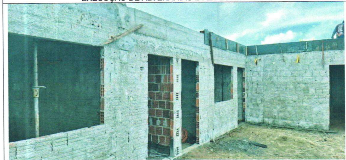
EXECUÇÃO DE ALVENARIAS E REVESTIMENTOS
