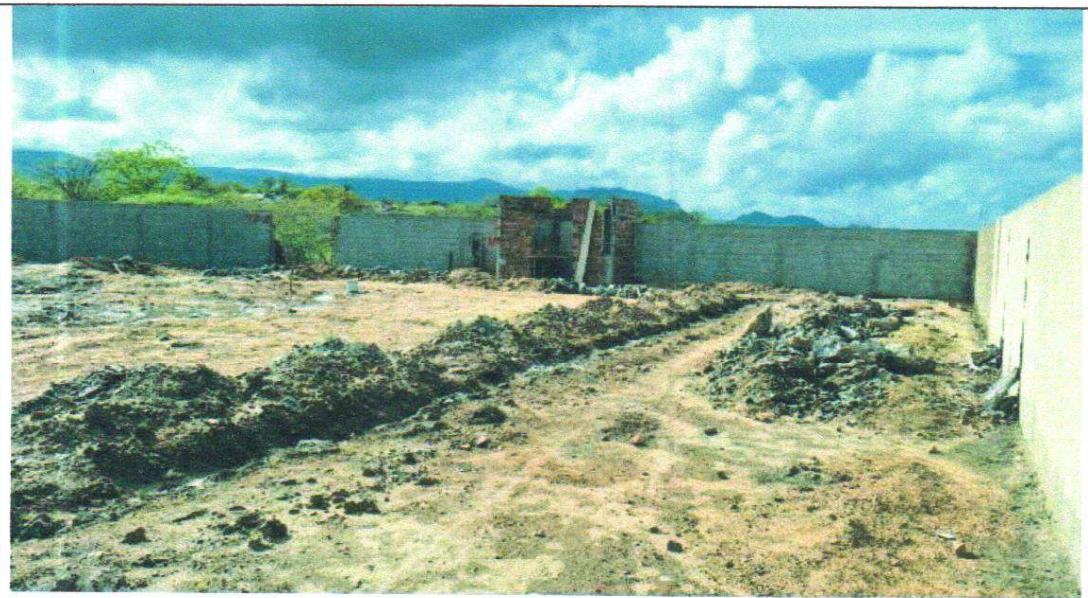
EXECUÇÃO DE ALVENARIA DE PEDRA DA QUADRA
