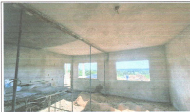
EXECUÇÃO DE REBOCO
