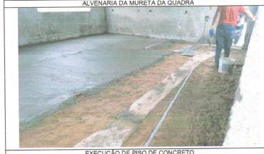
EXECUÇÃO DE PISO DE CONCRETO
