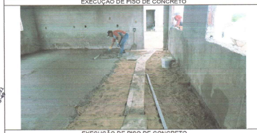
EXECUÇÃO DE PISO DE CONCRETO
