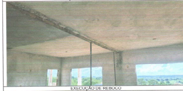
EXECUÇÃO DE REBOCO
