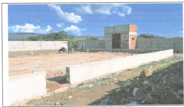
ALVENARIA DA MURETA DA QUADRA
