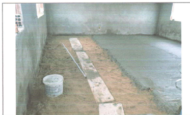
EXECUÇÃO DE PISO DE CONCRETO
