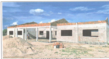
EXECUÇÃO DE ALVENARIA DE EMPENA
