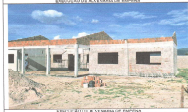
EXECUÇÃO DE ALVENARIA DE EMPENA
