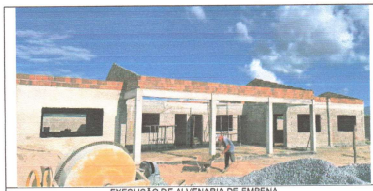
EXECUÇÃO DE ALVENARIA DE EMPENA
