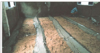
EXECUÇÃO DE PISO DE CONCRETO
