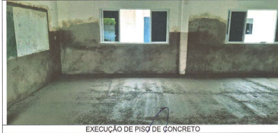
EXECUÇÃO DE PISO DE CONCRETO
