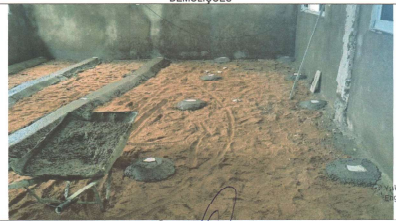
EXECUÇÃO DE PISO DE CONCRETO
