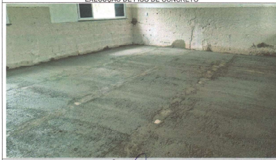
EXECUÇÃO DE PISO DE CONCRETO
