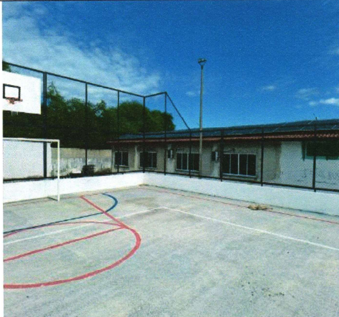
EXECUÇÃO DE DEMARCAÇÃO DE PISO
