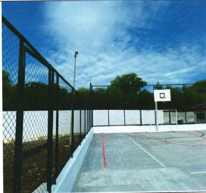
EXECUÇÃO DE PINTURAS DE PISO E ALAMBRADO
