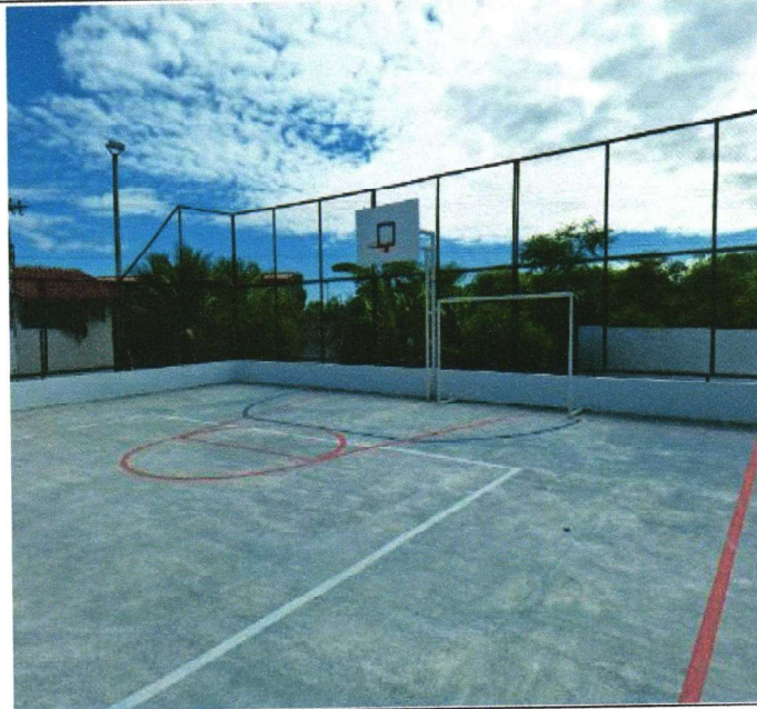
EXECUÇÃO DE PINTURAS DE PISO E ALAMBRADO
