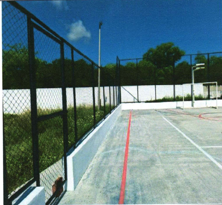
EXECUÇÃO DE PINTURAS DE PISO E ALAMBRADO
