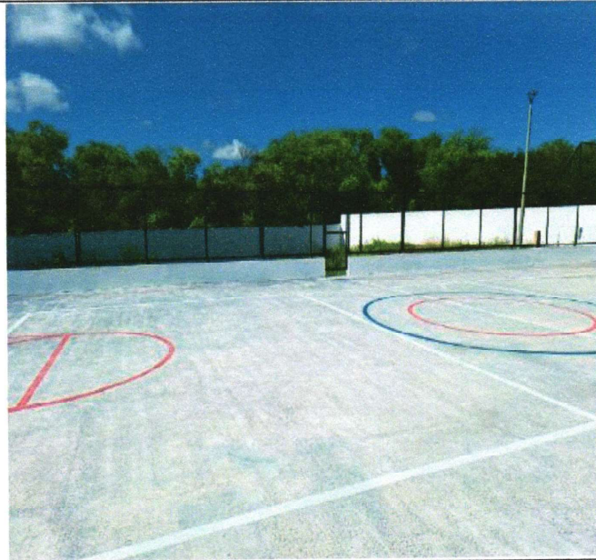
EXECUÇÃO DE PINTURAS DE PISO E ALAMBRADO
