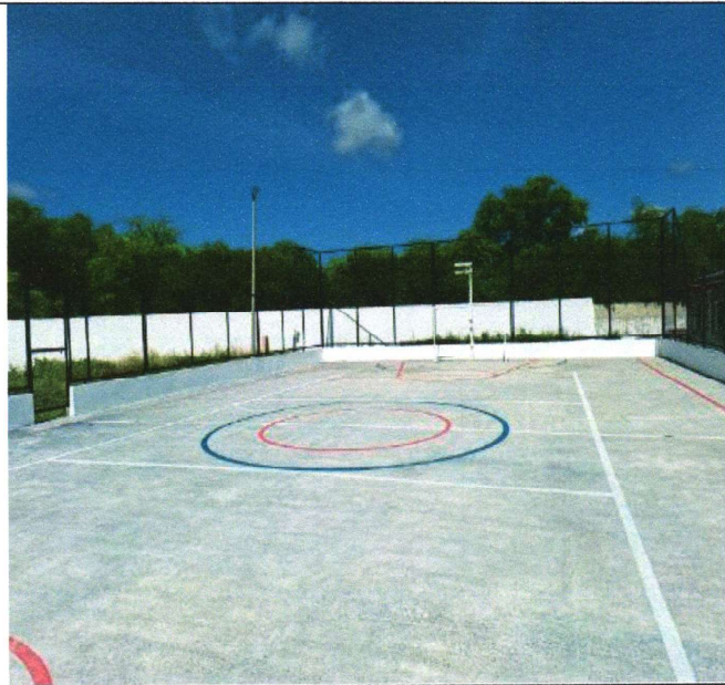
EXECUÇÃO DE PISO INDUSTRIAL E ALAMBRADO
