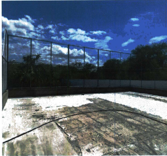
EXECUÇÃO DE PISO INDUSTRIAL E ALAMBRADO
