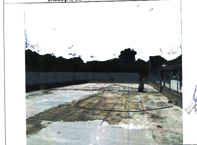
EXECUÇÃO DE PISO INDUSTRIAL E ALAMBRADO
