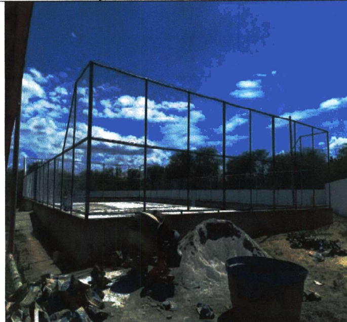
EXECUÇÃO DE PISO INDUSTRIAL E ALAMBRADO
