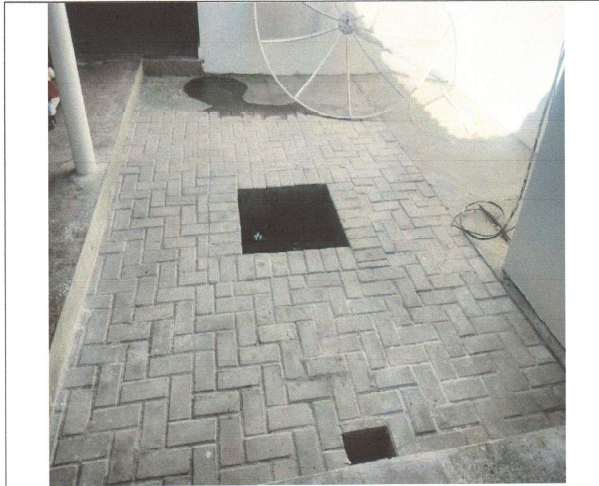
EXECUÇÃO DE PISO INTERTRAVADO
