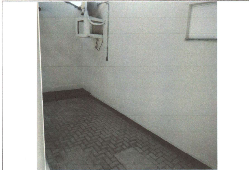
EXECUÇÃO DE PISO E PINTURA
