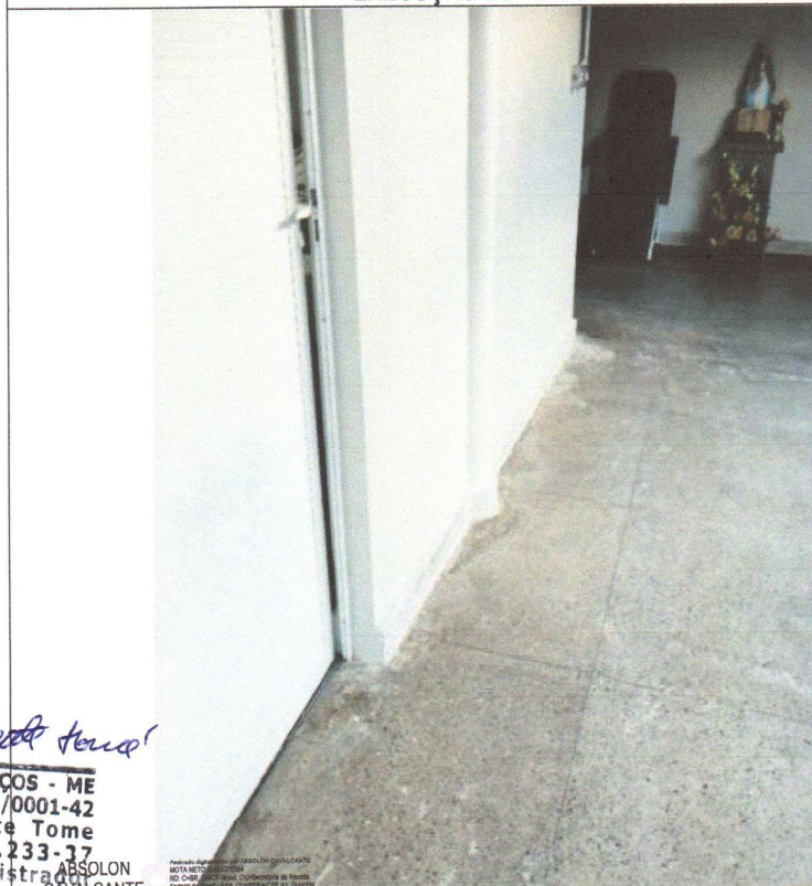
EXECUÇÃO DE PINTURA
