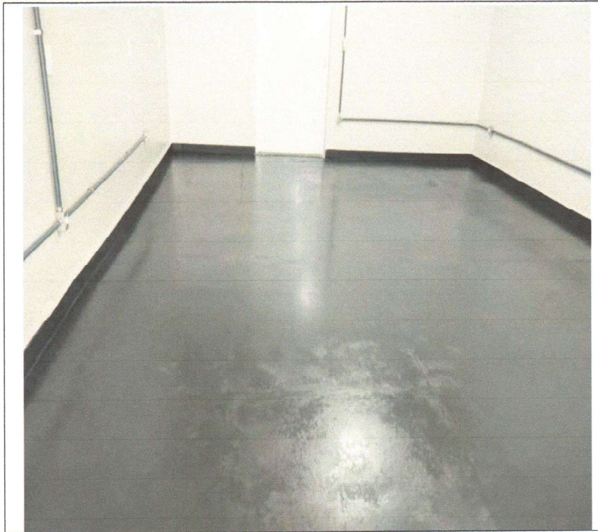
EXECUÇÃO DE PINTURA DE PISO
