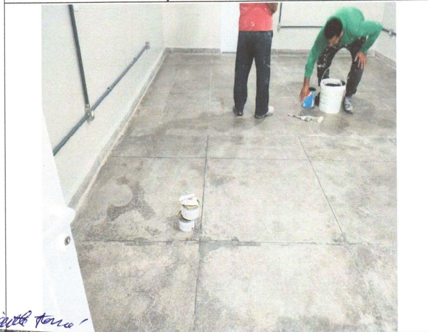
PREPARAÇÃO DO PISO PARA PINTURA
