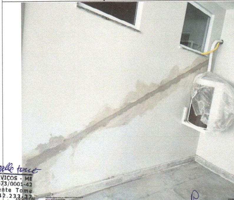
EXECUÇÃO DE DRENOS
