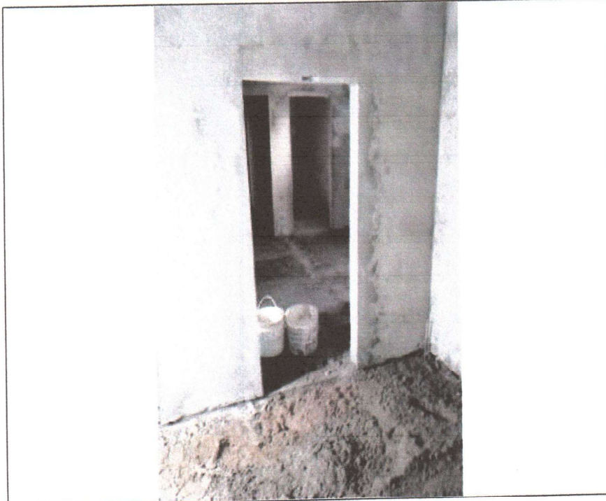
EXECUÇÃO DE ALVENARIA
