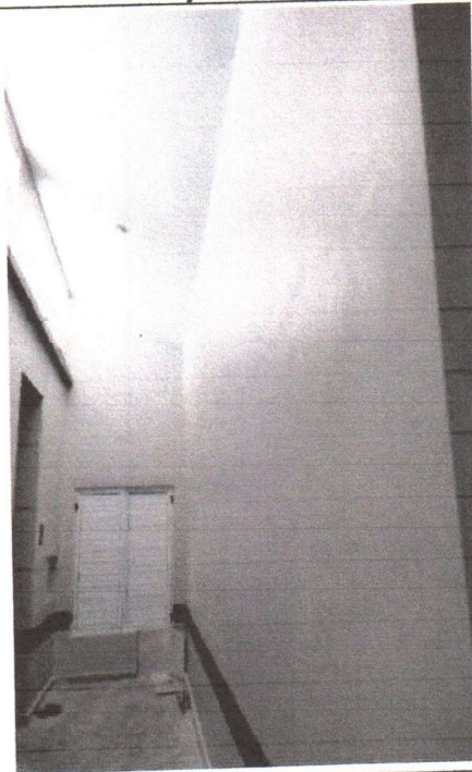
EXECUÇÃO DE PINTURA
