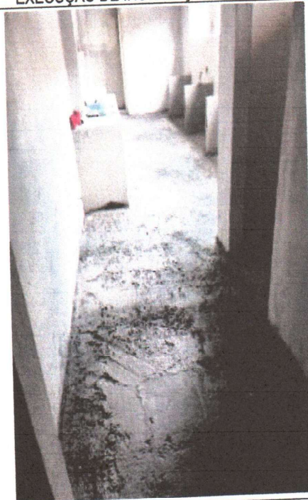
EXECUÇÃO DE PISO INDUSTRIAL
