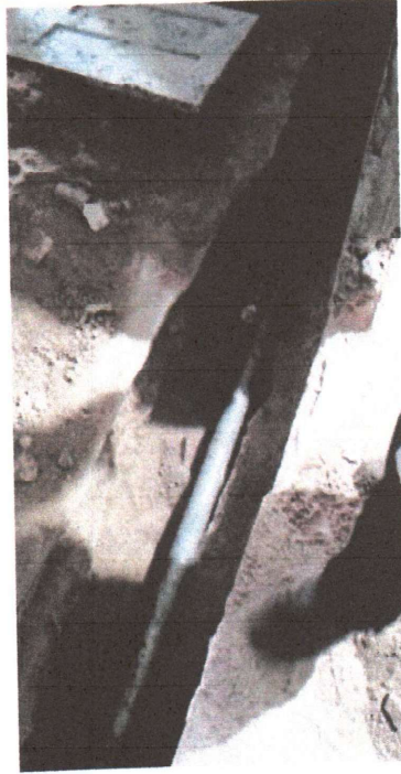
EXECUÇÃO DE INSTALAÇÃO DE VAPOR
