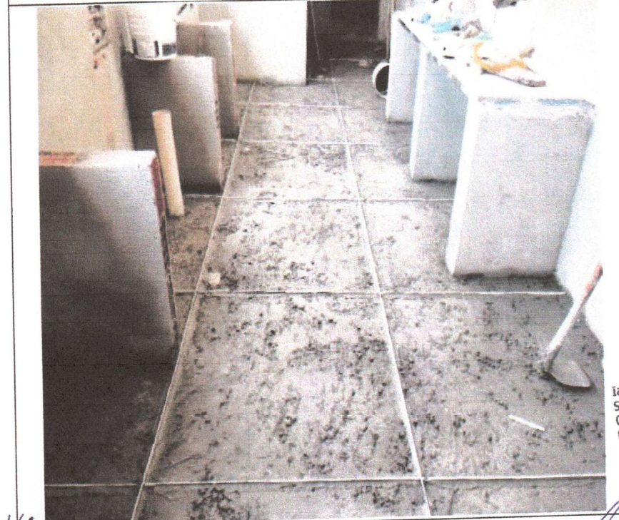
EXECUÇÃO DE PISO INDUSTRIAL
