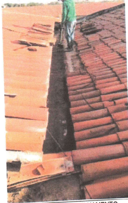
EXECUÇÃO DE RETELHAMENTO
