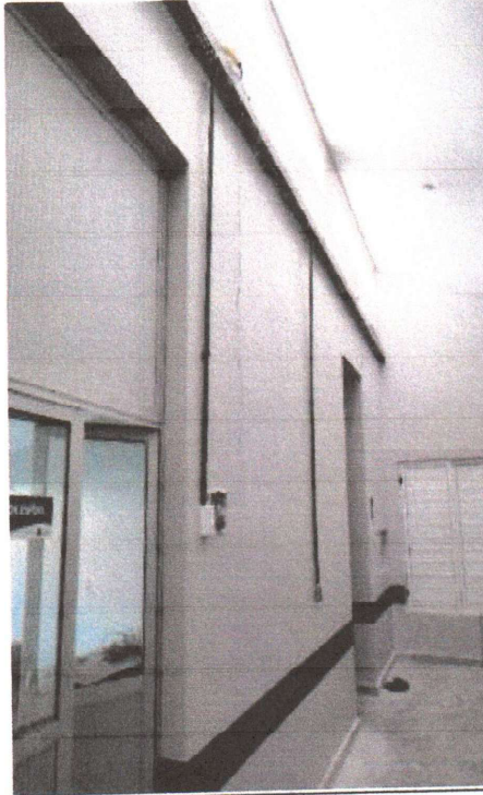
EXECUÇÃO DE PINTURA
