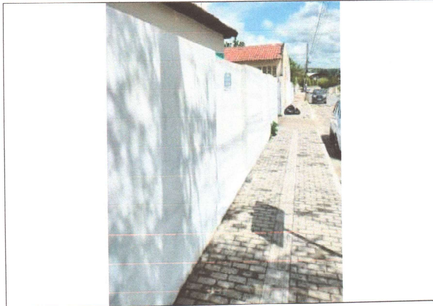
EXECUÇÃO DE PINTURA
