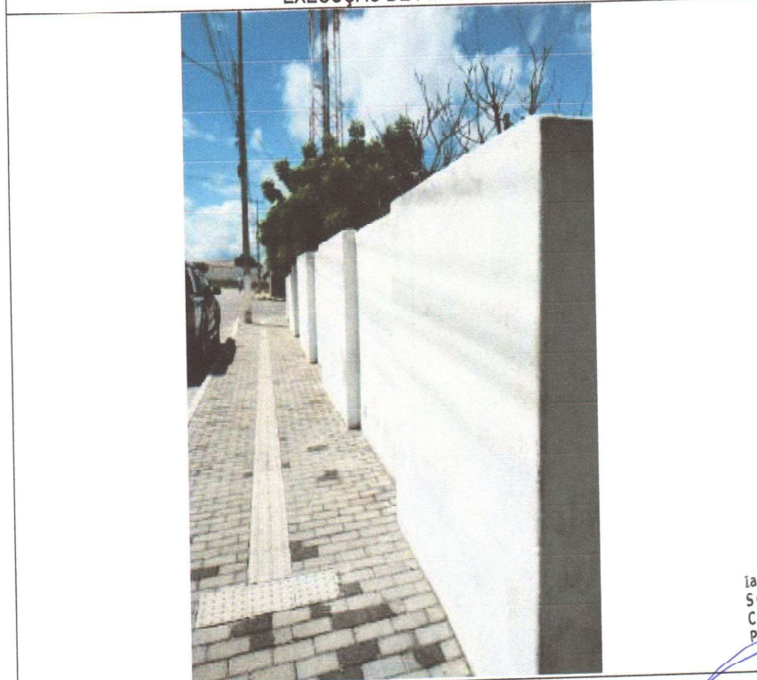
EXECUÇÃO DE PINTURA
