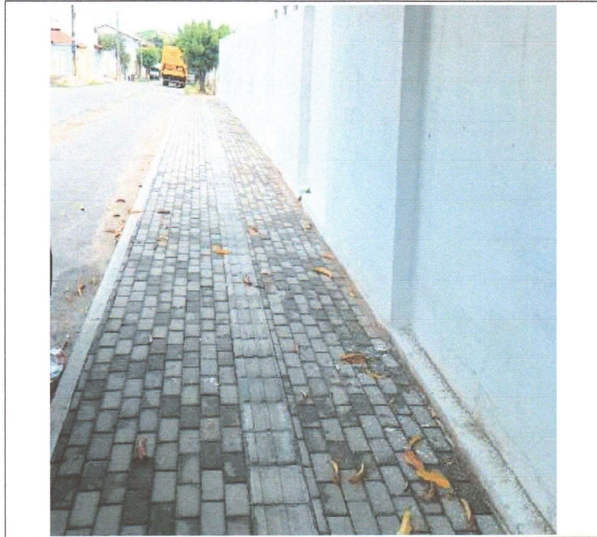
EXECUÇÃO DE PISO PODOTÁTIL
