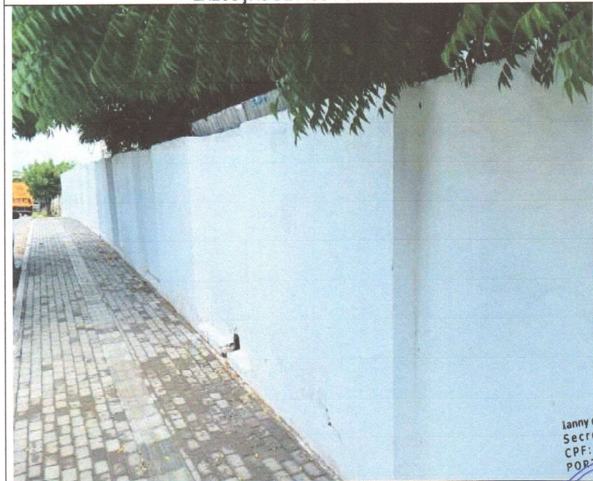
EXECUÇÃO DE PINTURA
