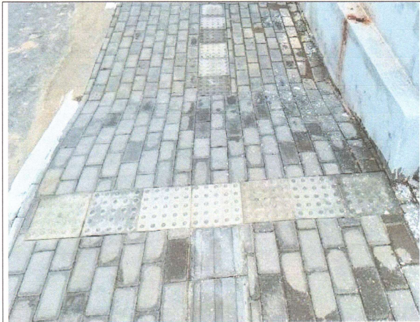
EXECUÇÃO DE PISO PODOTÁTIL
