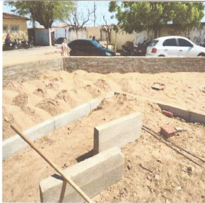
EXECUÇÃO DE PAVIMENTAÇÃO
