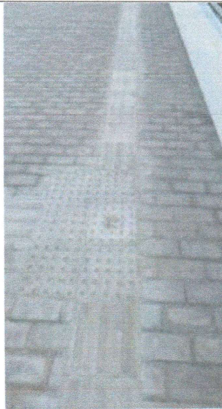
EXECUÇÃO DE PISO PODOTÁTIL
