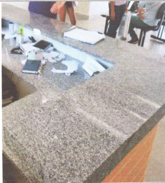
EXECUÇÃO DE BANCADA DE GRANITO
