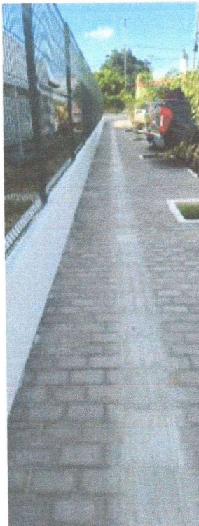
EXECUÇÃO DE PISO PODOTÁTIL
