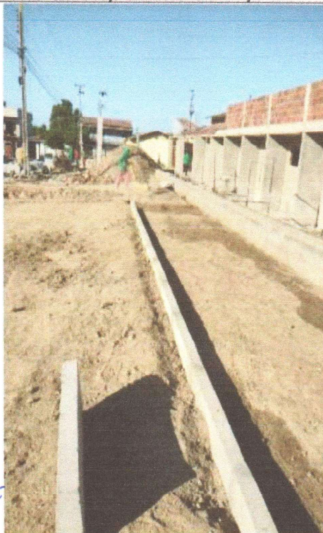
EXECUÇÃO DE PAVIMENTAÇÃO
