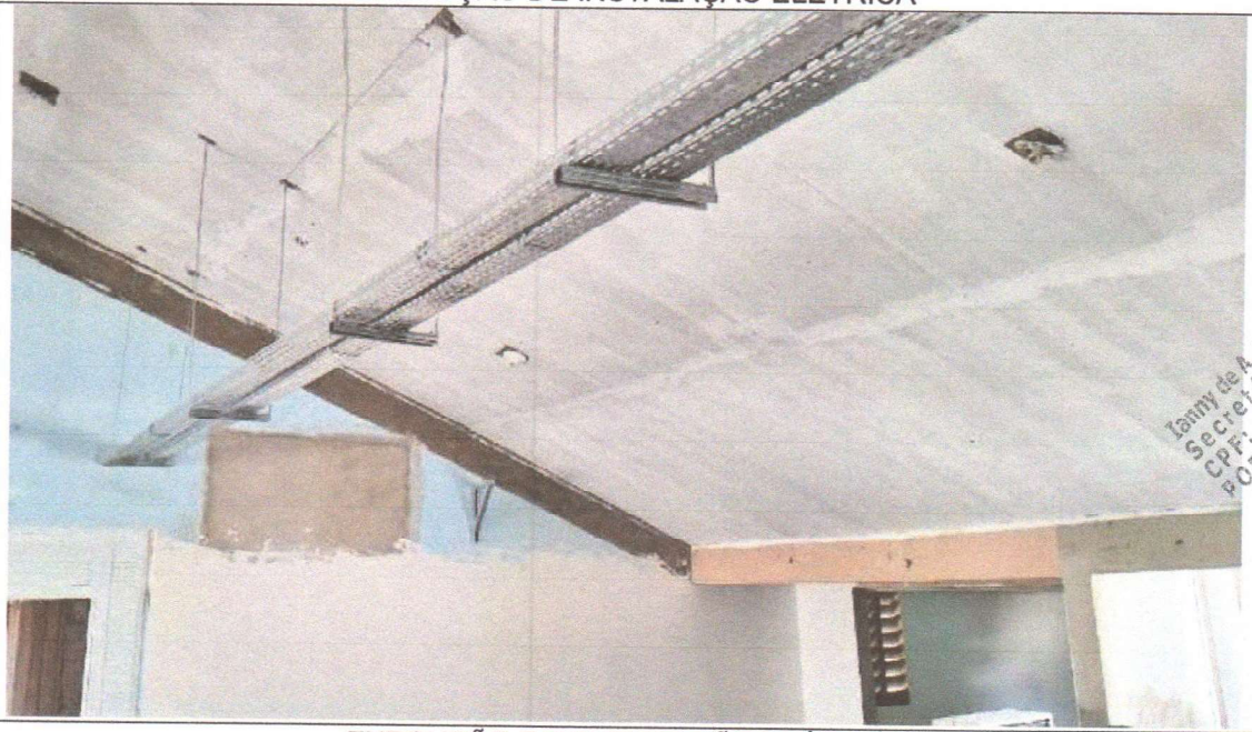
EXECUÇÃO DE INSTALAÇÃO ELÉTRICA
