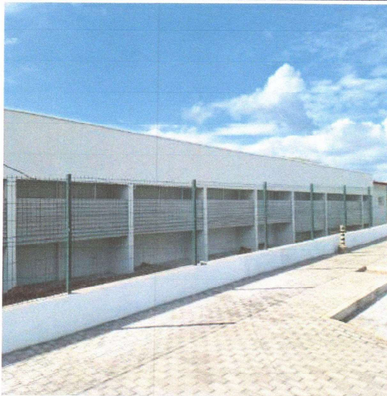
PINTURA DA FACHADA
