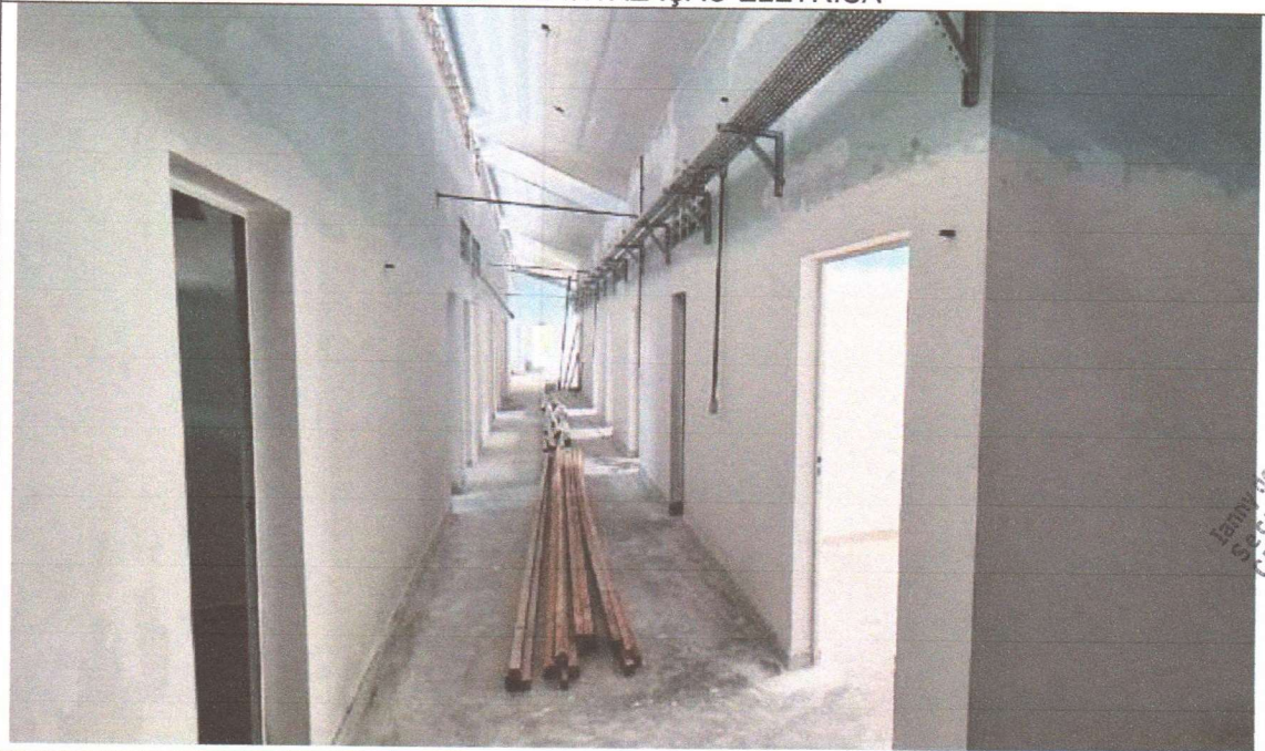
IMPERMEABILIZAÇÃO DA FACHADA
