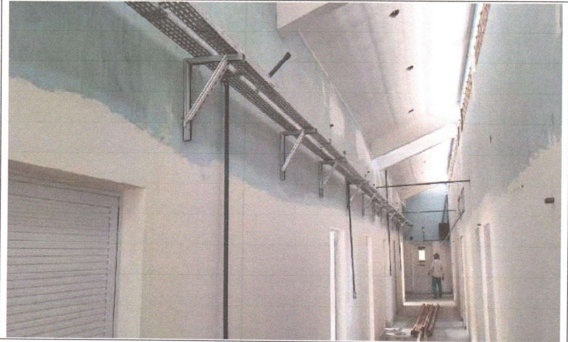
EXECUÇÃO DE INSTALAÇÃO ELÉTRICA
