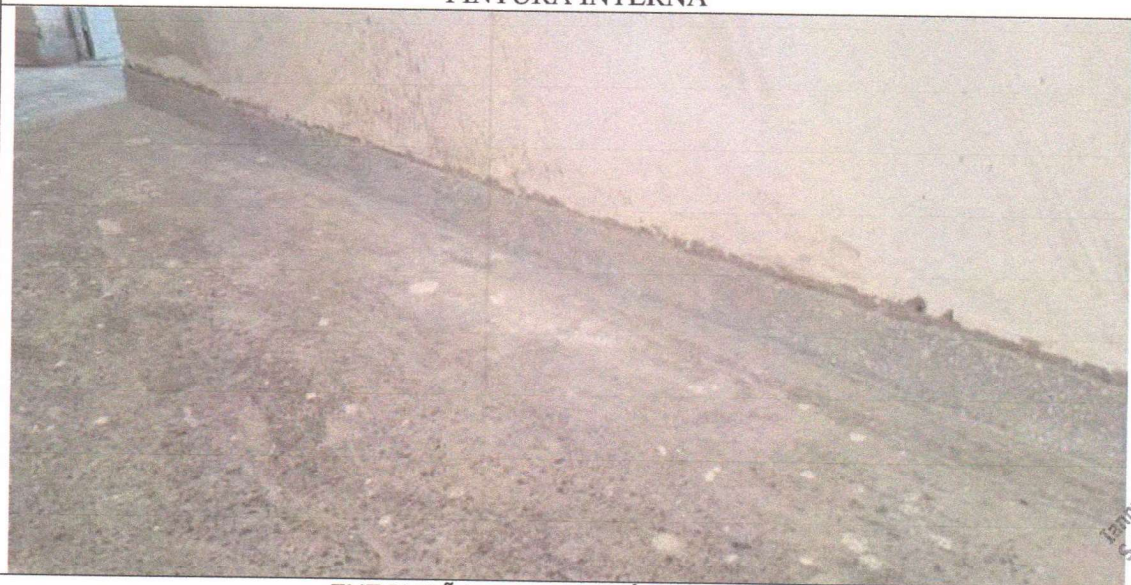
EXECUÇÃO DE RODAPÉ INDUSTRIAL
