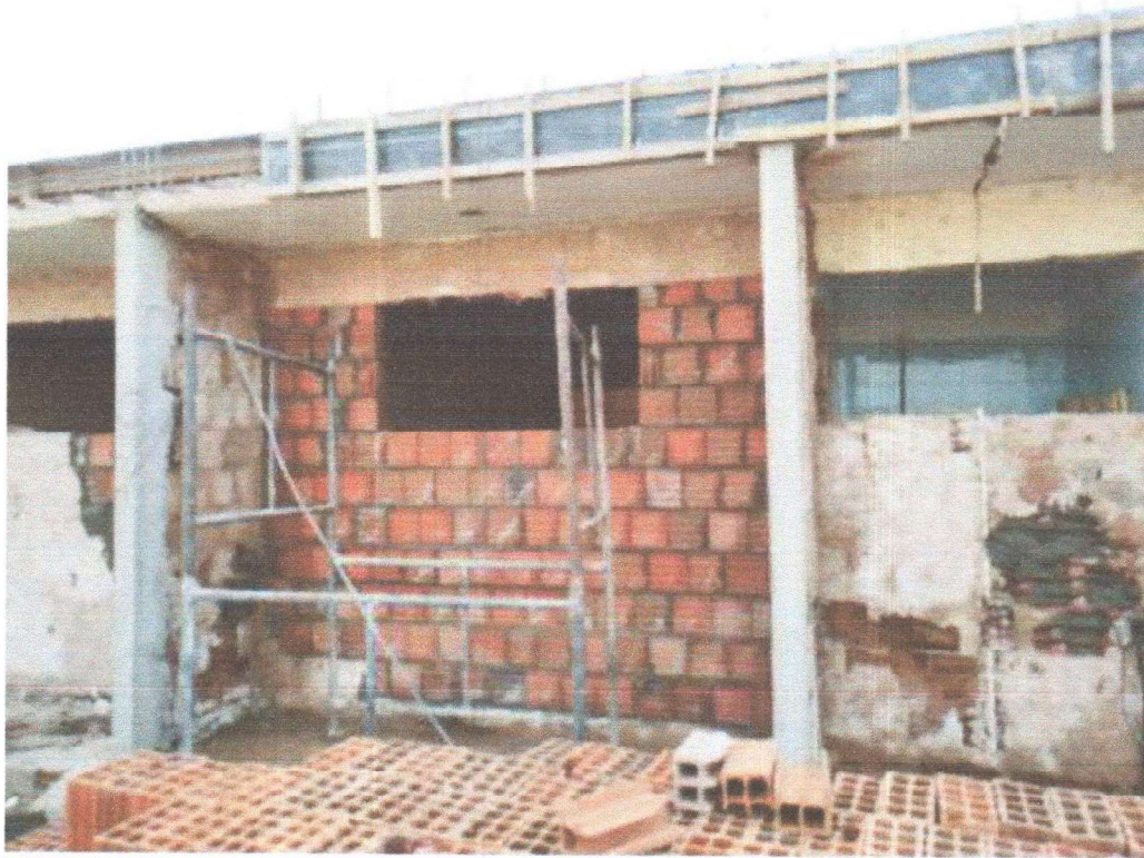
ESTRUTURA DA PLATIBANDA
