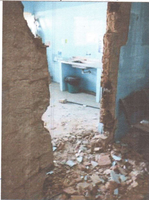
DEMOLIÇÕES E RETIRADAS
