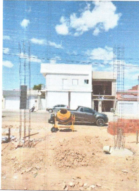
EXECUÇÃO DA ESTRUTURA DO PORTICO
