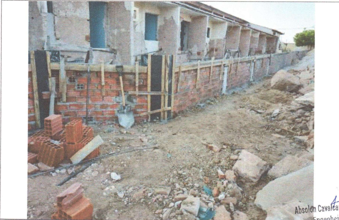
CONSTRUÇÃO DA MURETA
