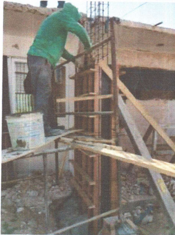
ESTRUTURA DA PLATIBANDA
