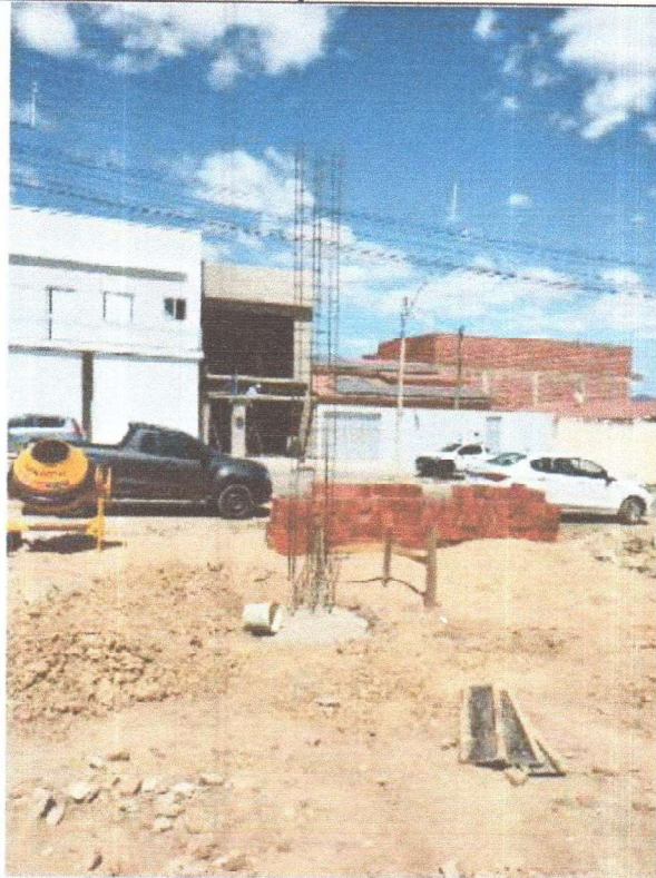
EXECUÇÃO DA ESTRUTURA DO PORTICO
