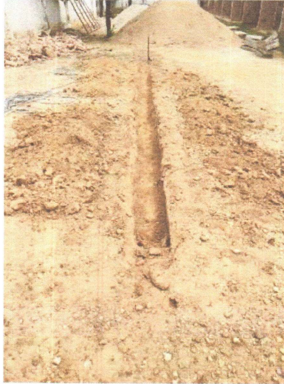
ESCAVAÇÃO PARA ALVENARIA DA MURETA
