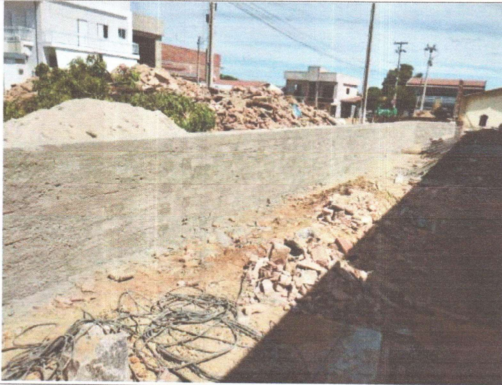
CONSTRUÇÃO DA MURETA
