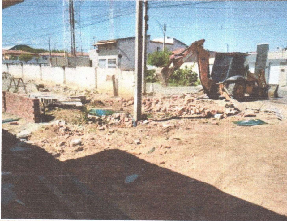
DEMOLIÇÕES E RETIRADAS
