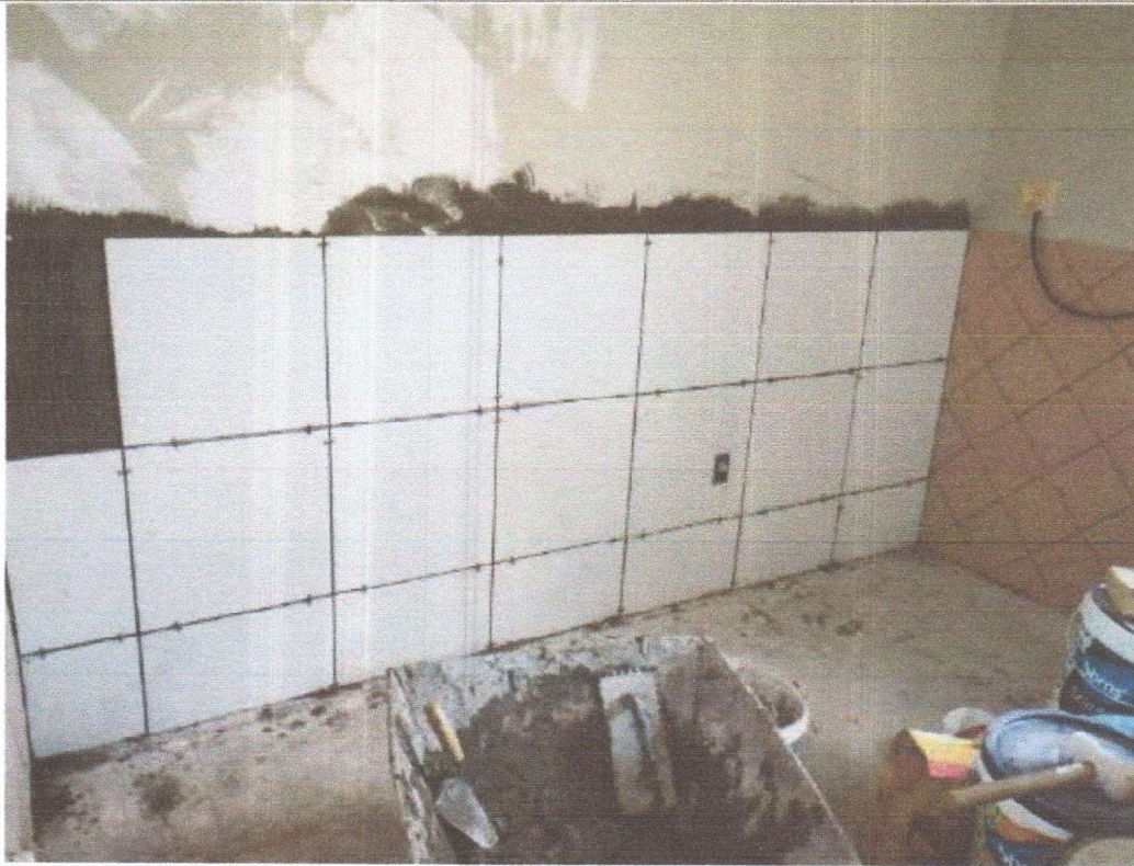
REVESTIMENTO CERÂMICO INTERNO
