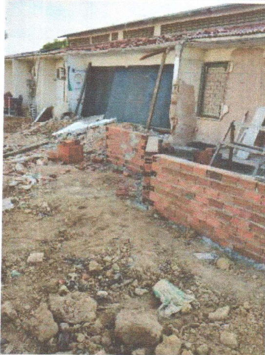
CONSTRUÇÃO DA MURETA
