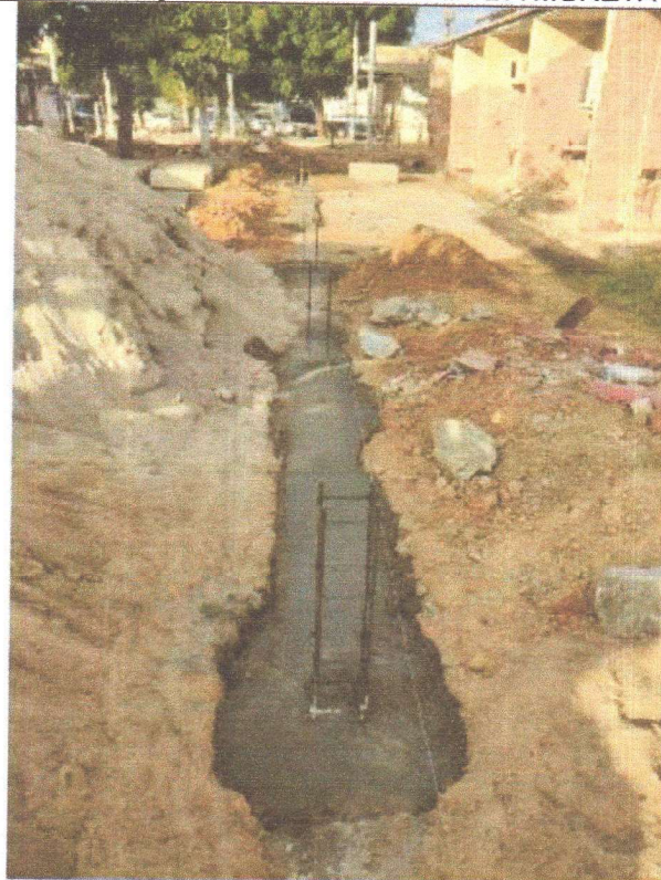
FUNDAÇÃO DA NOVA MURETA
