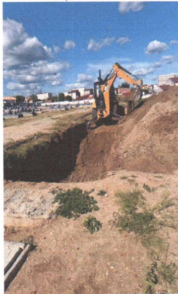
EXECUÇÃO DOS TUMULOS
