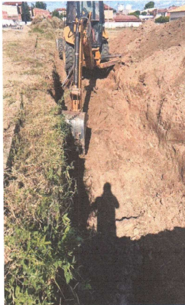
EXECUÇÃO DOS TUMULOS
