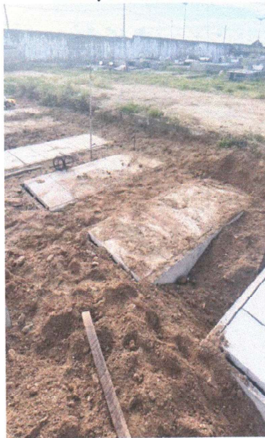
EXECUÇÃO DOS TUMULOS
