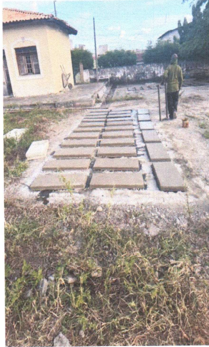
EXECUÇÃO DOS TUMULOS
