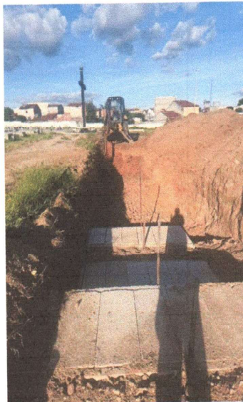
EXECUÇÃO DOS TUMULO
