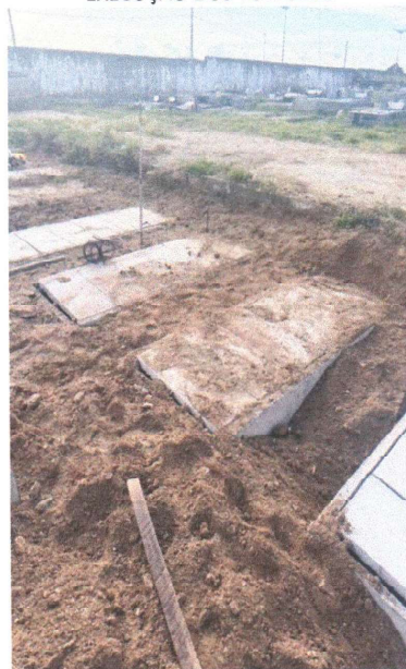
EXECUÇÃO DOS TUMULOS
