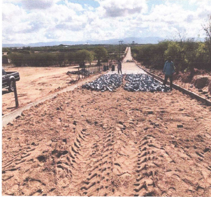
EXECUÇÃO DA PAVIMENTAÇÃO
