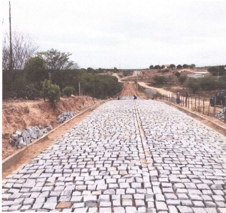
EXECUÇÃO DA PAVIMENTAÇÃO
