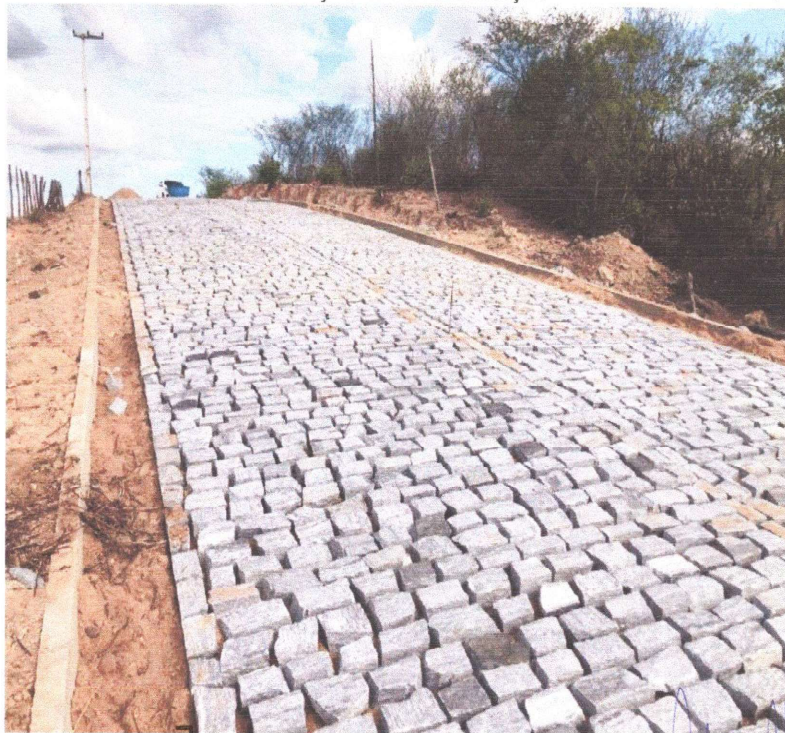
EXECUÇÃO DA PAVIMENTAÇÃO
