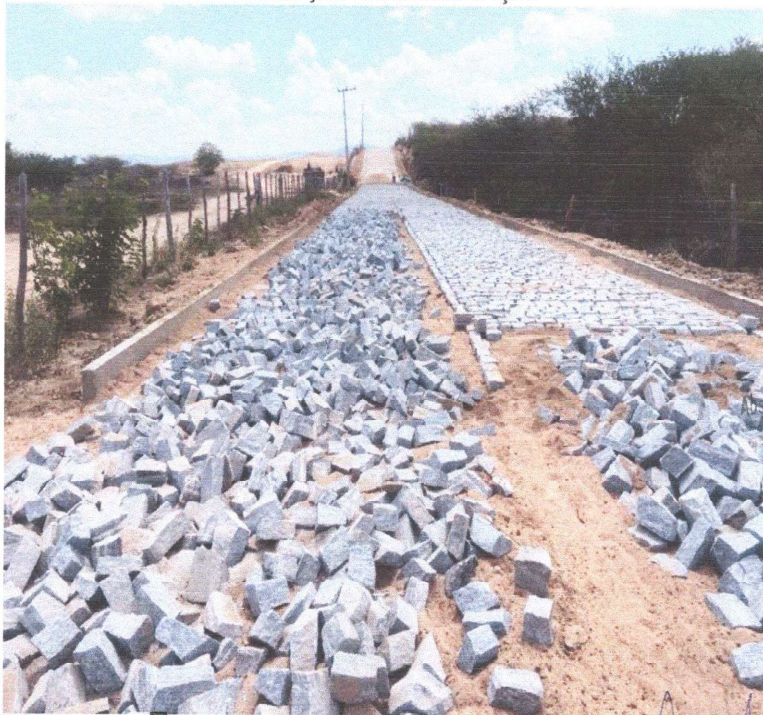
EXECUÇÃO DA PAVIMENTAÇÃO
