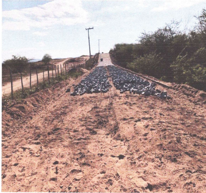
EXECUÇÃO DA PAVIMENTAÇÃO
