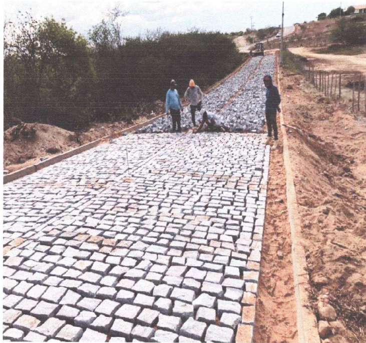
EXECUÇÃO DA PAVIMENTAÇÃO
