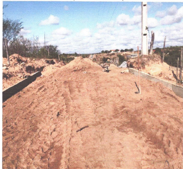
EXECUÇÃO DA PAVIMENTAÇÃO
