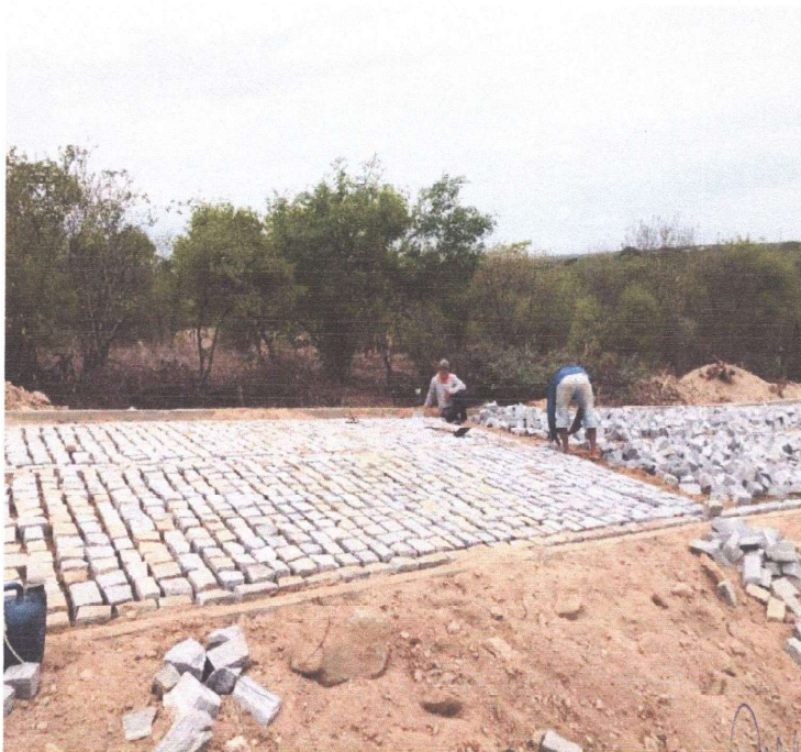
EXECUÇÃO DA PAVIMENTAÇÃO
