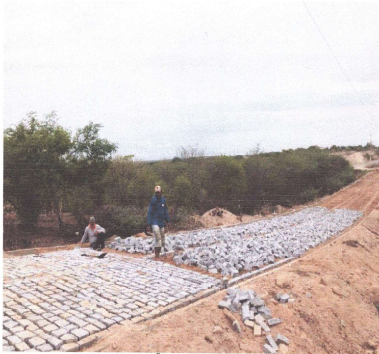
EXECUÇÃO DA PAVIMENTAÇÃO
