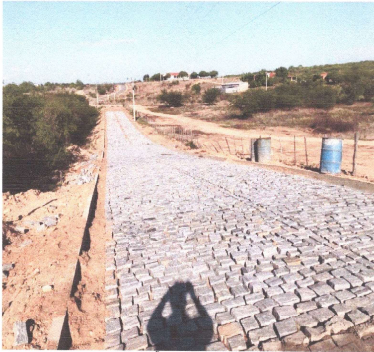
EXECUÇÃO DA PAVIMENTAÇÃO
