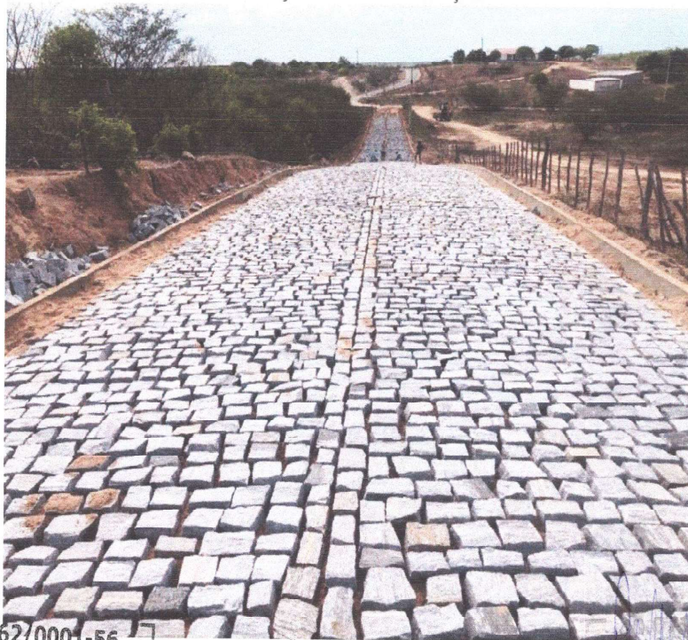
EXECUÇÃO DA PAVIMENTAÇÃO
