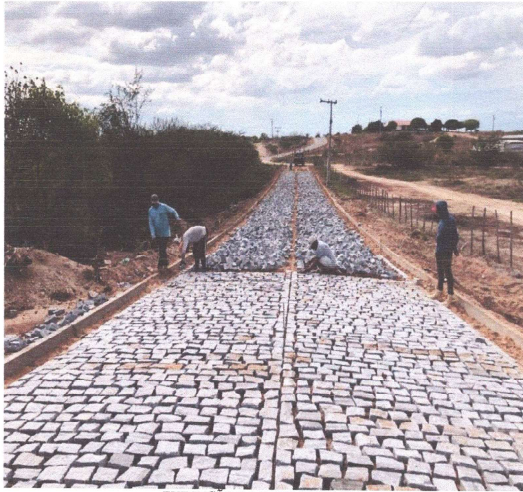
EXECUÇÃO DA PAVIMENTAÇÃO
