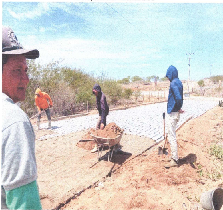
SERVIÇOS DE REJUNTAMENTO
