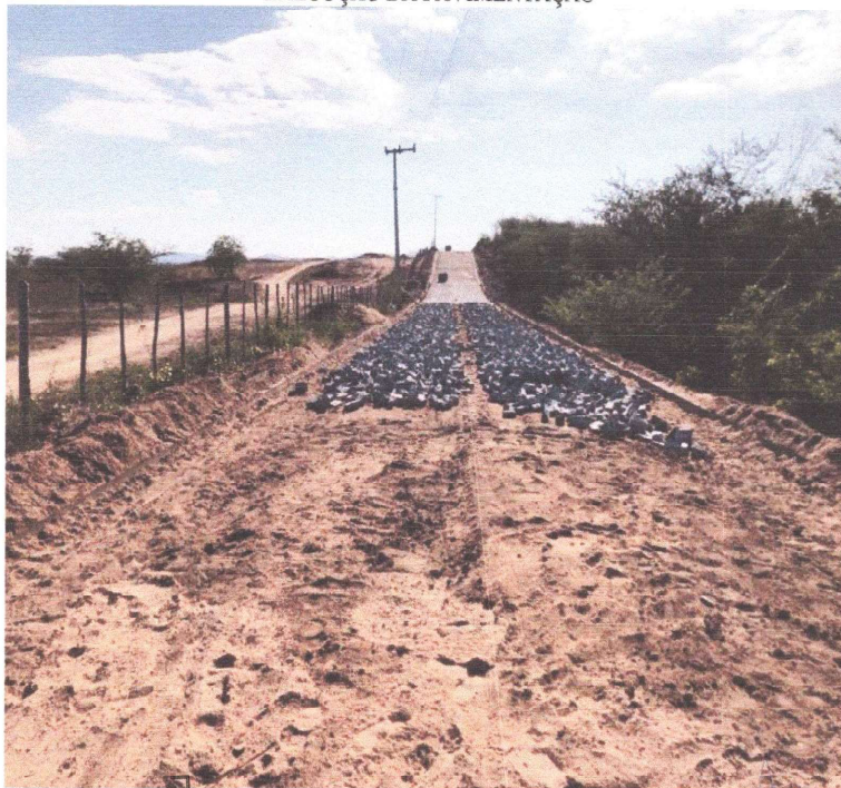
EXECUÇÃO DA PAVIMENTAÇÃO
