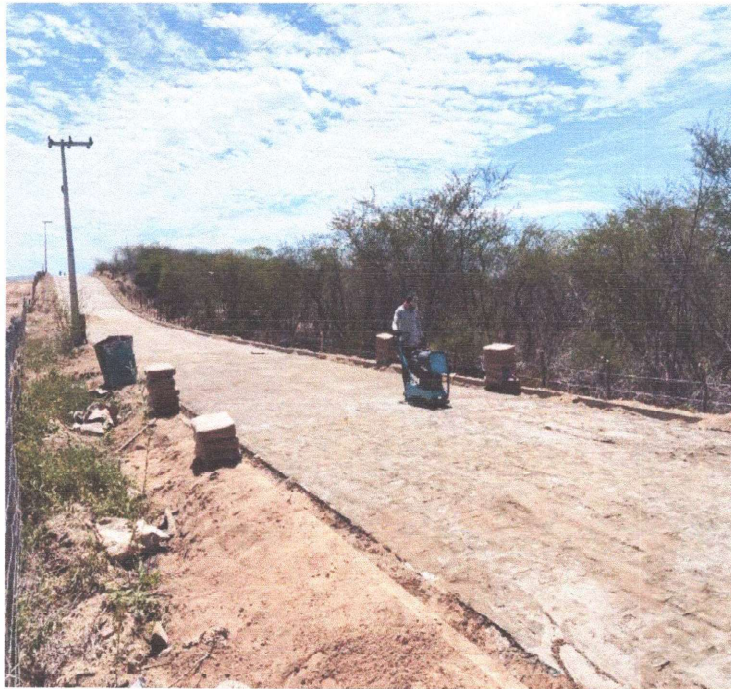
SERVIÇOS DE REJUNTAMENTO
