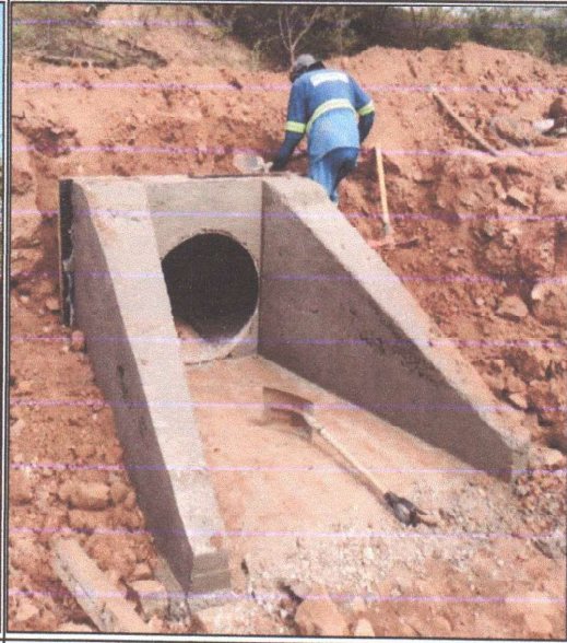
EXECUÇÃO DE BOCA DE BUEIRO SIMPLES TUBULAR D= 800cm
