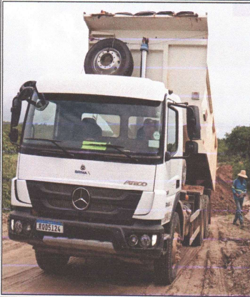
TRANSPORTE E LANÇAMENTO DE MATERIAL 1ª-CAT
