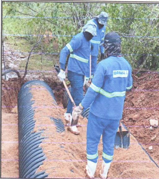
EXECUÇÃO DE CORPO DE BUEIRO DUPLO TUBULAR D= 100cm
