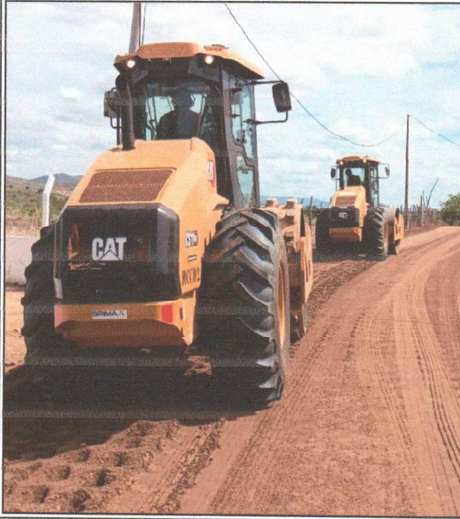
COMPACTAÇÃO DE MATERIAL 1ª-CAT
