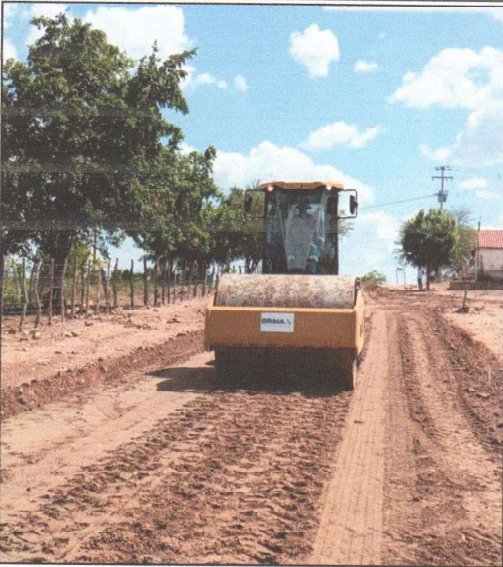
COMPACTAÇÃO DE MATERIAL 1ª-CAT
