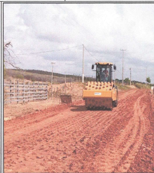
COMPACTAÇÃO DE MATERIAL 1ª-CAT
