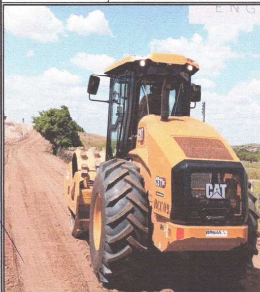
COMPACTAÇÃO DE MATERIAL 1ª-CAT
