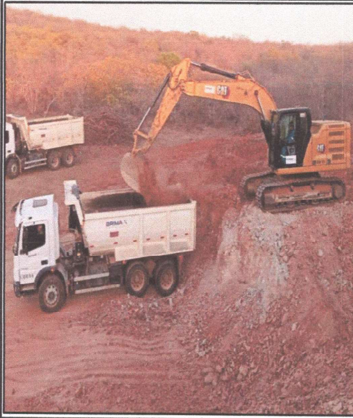
EXTRAÇÃO DE MATERIAL EM JAZIDA
