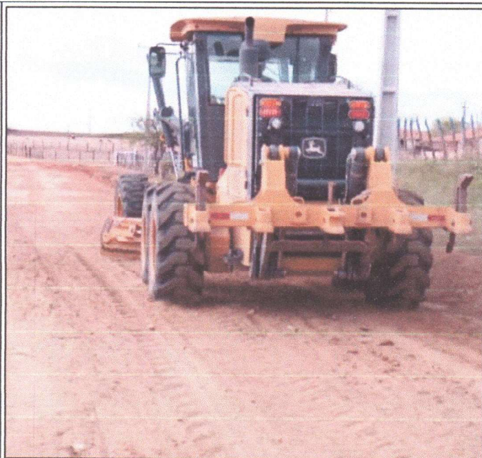
LIMPEZA DE VIA VICINAL
