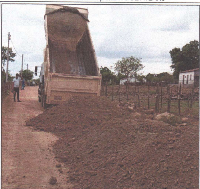
TRANSPORTE E LANÇAMENTO DE ATERRO
