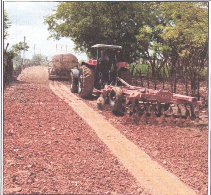
EXECUÇÃO DE ATERRO
