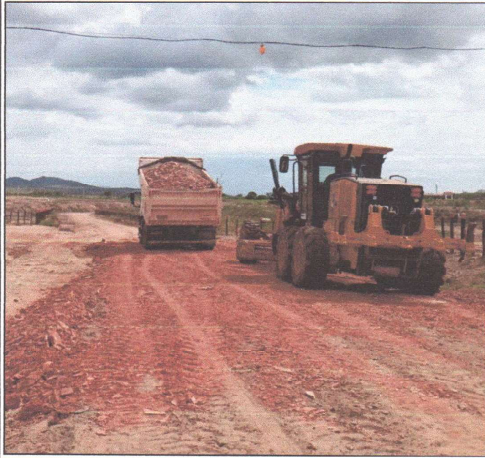
TRANSPORTE E LANÇAMENTO DE ATERRO
