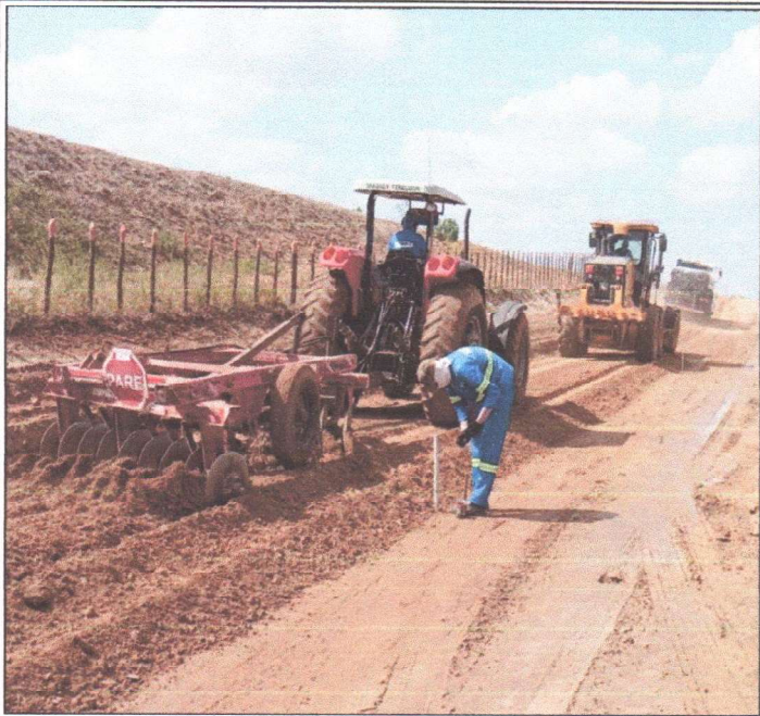
EXECUÇÃO DE ATERRO
