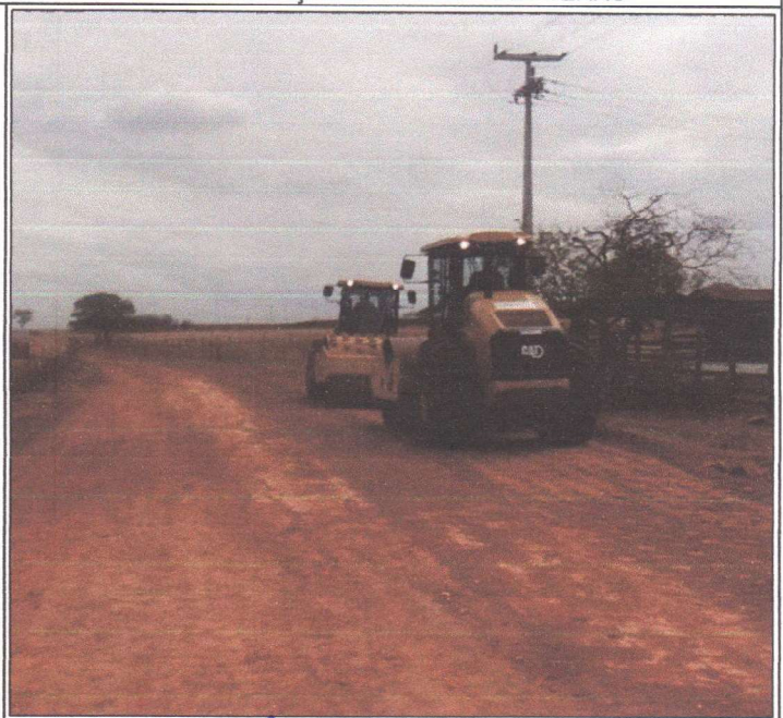
COMPACTAÇÃO DA CAMADA DE ATERRO
