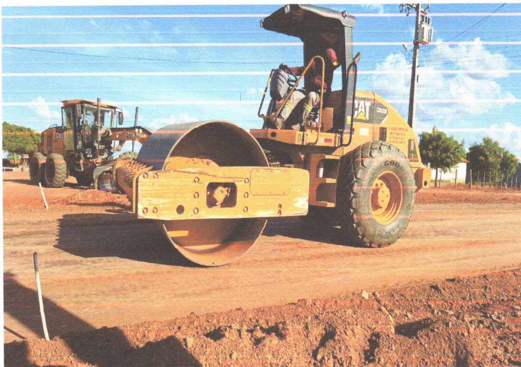
EXECUÇÃO DE TERRAPLENAGEM
