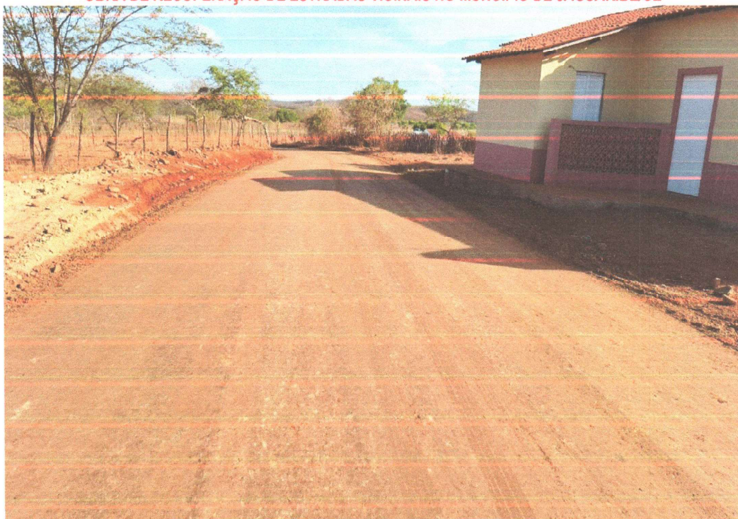
EXECUÇÃO DE TERRAPLENAGEM
