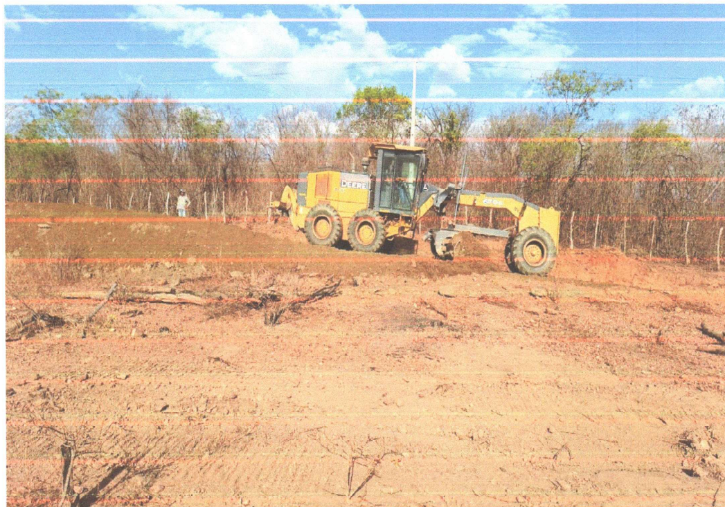
EXECUÇÃO DE TERRAPLENAGEM
