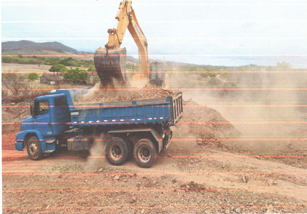
EXECUÇÃO DE TERRAPLENAGEM
