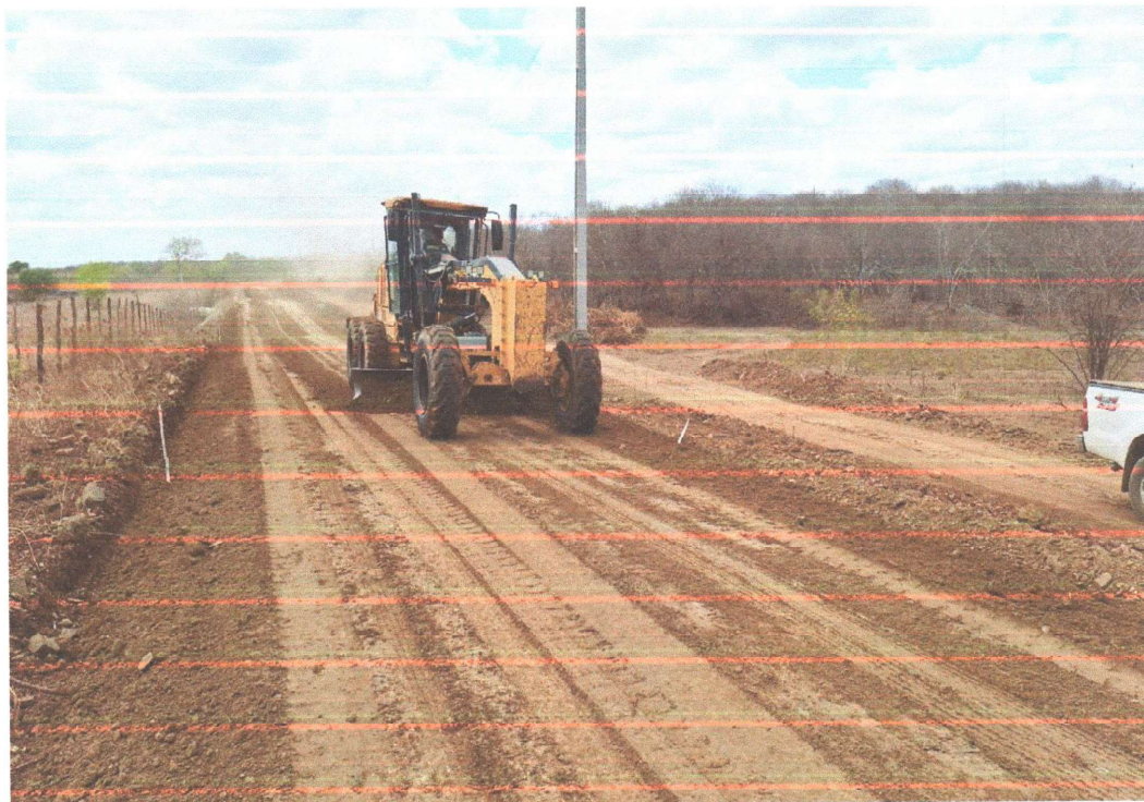
EXECUÇÃO DE TERRAPLENAGEM
