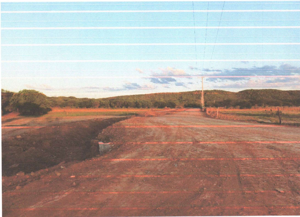
EXECUÇÃO DE TERRAPLENAGEM
