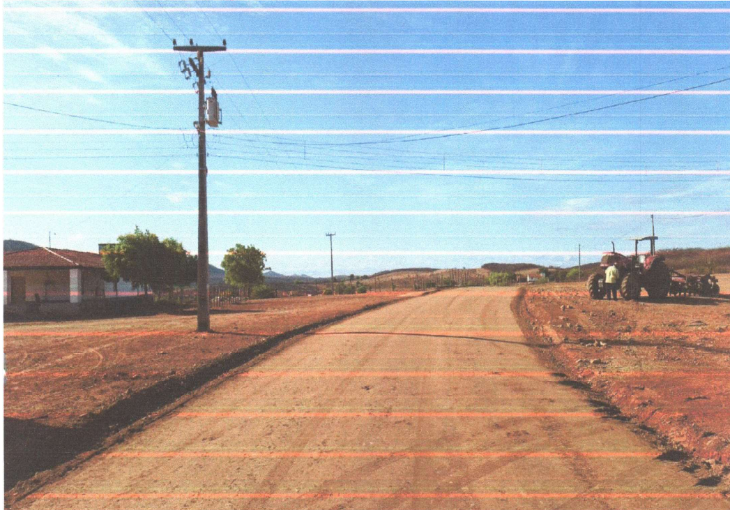
EXECUÇÃO DE TERRAPLENAGEM
