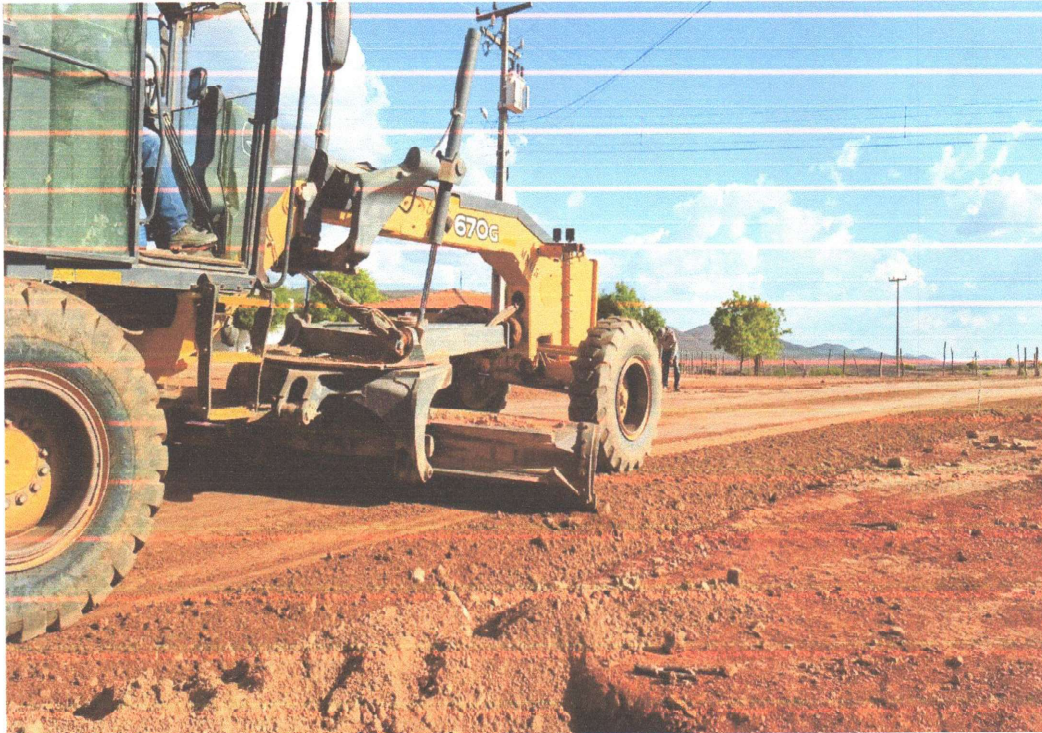
EXECUÇÃO DE TERRAPLENAGEM
