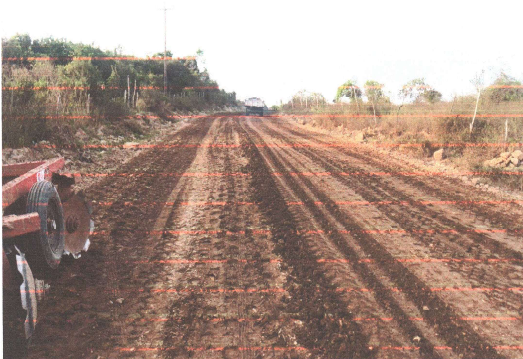
EXECUÇÃO DE TERRAPLENAGEM
