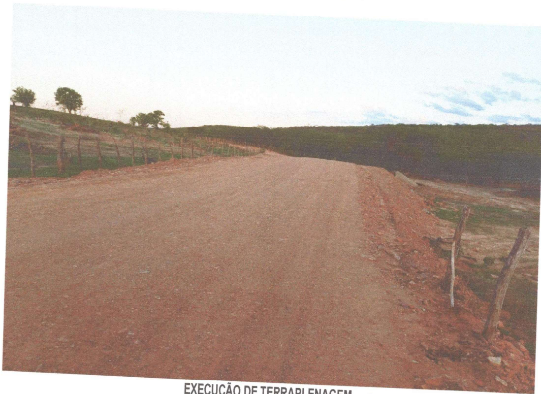
EXECUÇÃO DE TERRAPLENAGEM
