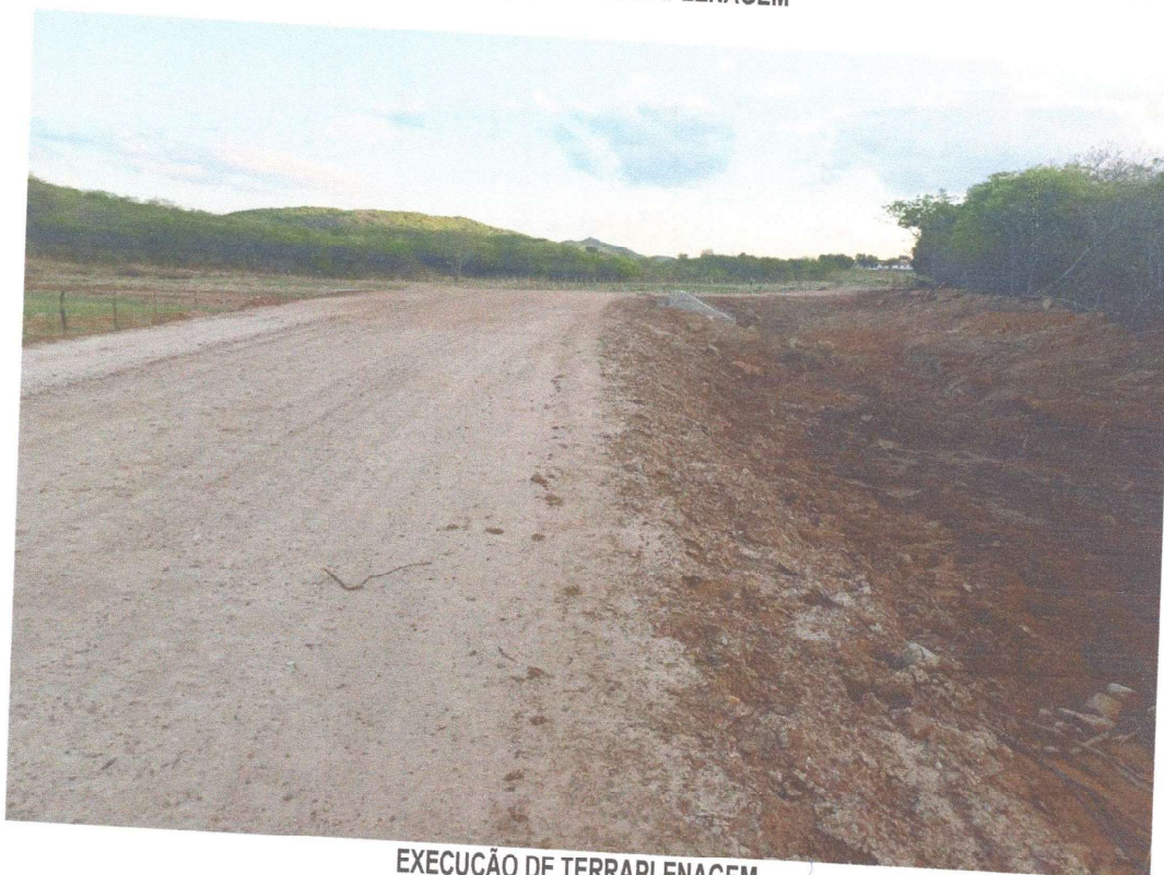
EXECUÇÃO DE TERRAPLENAGEM
