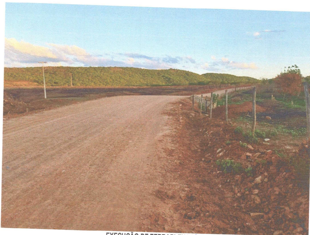
EXECUÇÃO DE TERRAPLENAGEM
