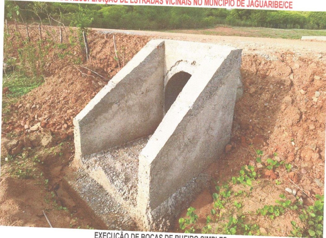
EXECUÇÃO DE BOCAS DE BUEIRO SIMPLES
