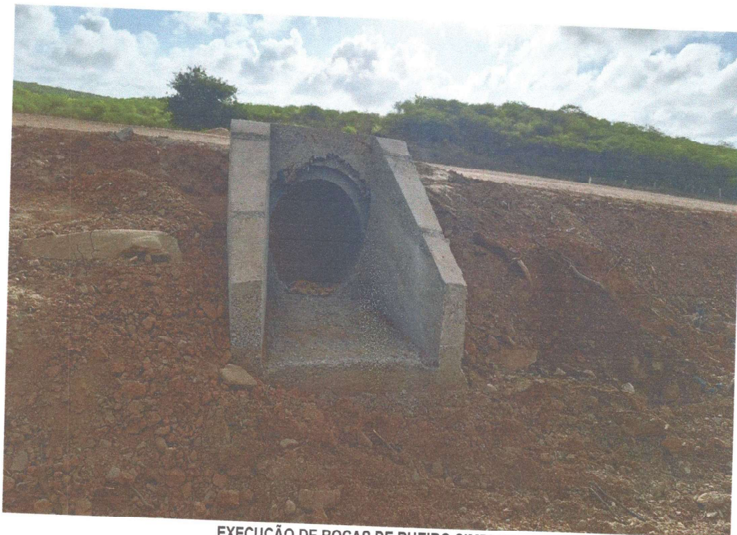
EXECUÇÃO DE BOCAS DE BUEIRO SIMPLES
