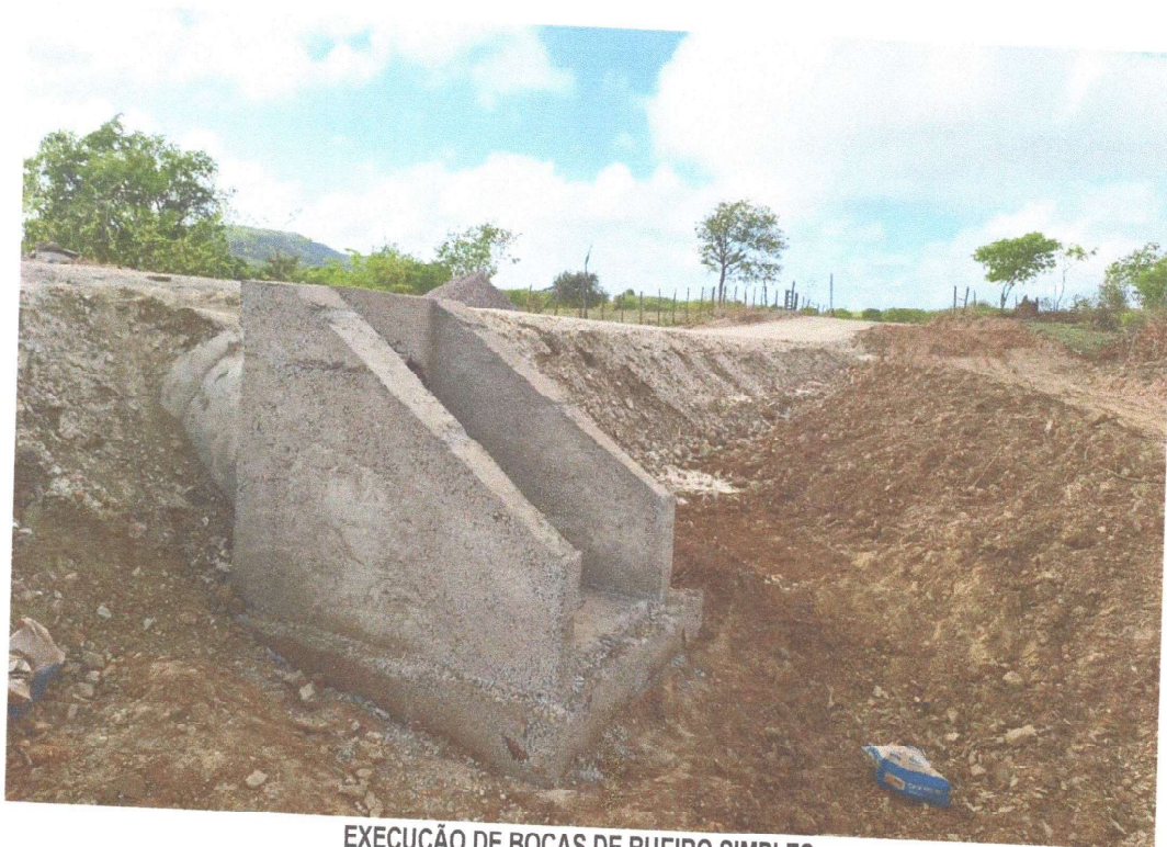
EXECUÇÃO DE BOCAS DE BUEIRO SIMPLES
