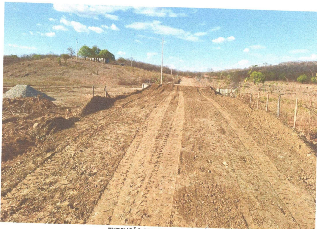
EXECUÇÃO DE TERRAPLENAGEM
