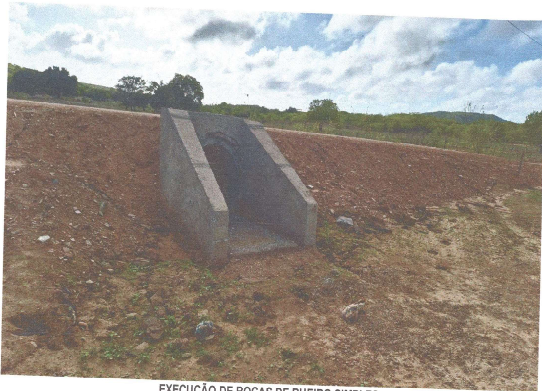
EXECUÇÃO DE BOCAS DE BUEIRO SIMPLES
