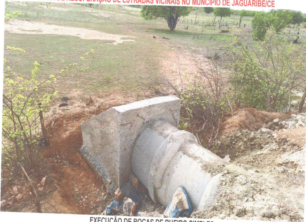
EXECUÇÃO DE BOCAS DE BUEIRO SIMPLES
