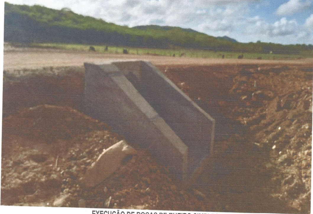
EXECUÇÃO DE BOCAS DE BUEIRO SIMPLES
