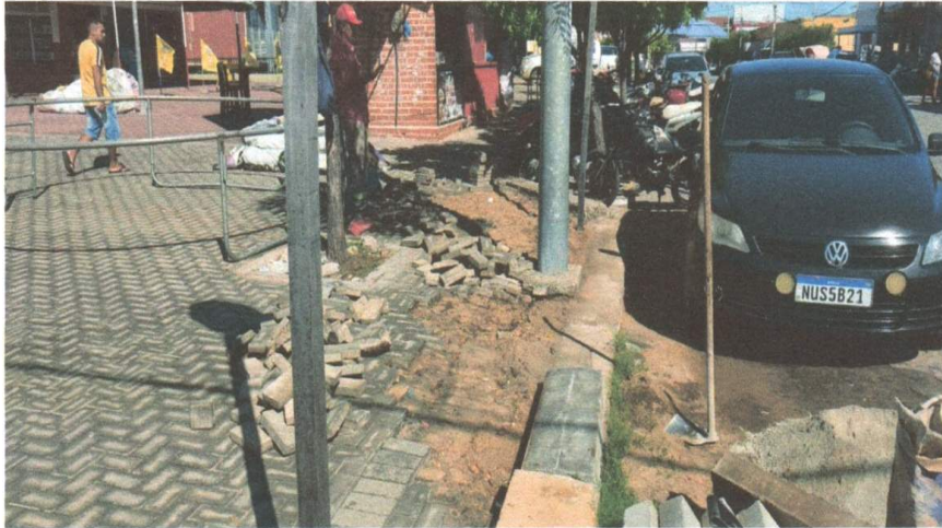
RECOMPOSIÇÃO EM INTERTRAVADO E MEIO FIO
