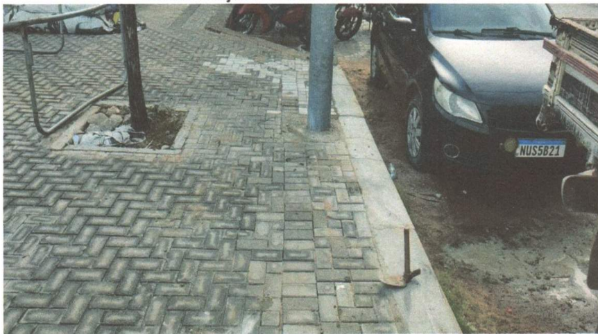
RECOMPOSIÇÃO EM INTERTRAVADO E MEIO FIO
