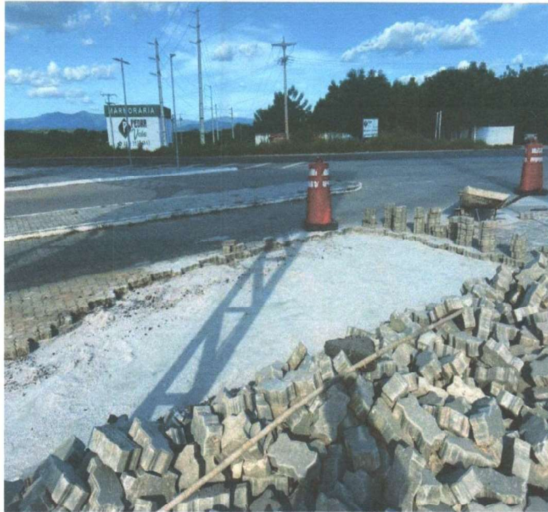
RECOMPOSIÇÃO DE PISO INTERTRAVADO
