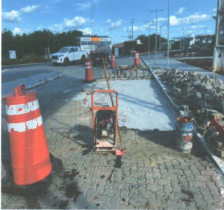
RECOMPOSIÇÃO DE PISO INTERTRAVADO
