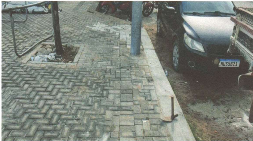
RECOMPOSIÇÃO EM INTERTRAVADO E MEIO FIO
