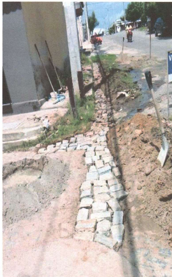
RECOMPOSIÇÃO EM PARALELEPIPEDO
