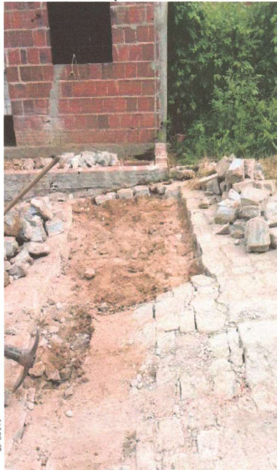
RECOMPOSIÇÃO EM PARALELEPIPEDO
