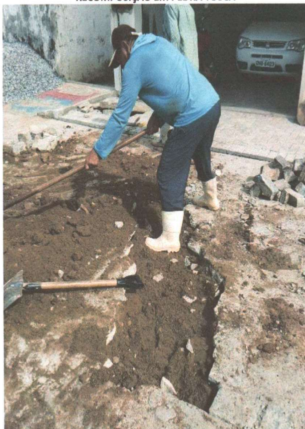
RECOMPOSIÇÃO EM PARALELEPIPEDO
