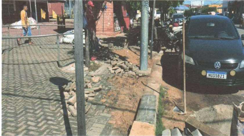
RECOMPOSIÇÃO EM INTERTRAVADO E MEIO FIO
