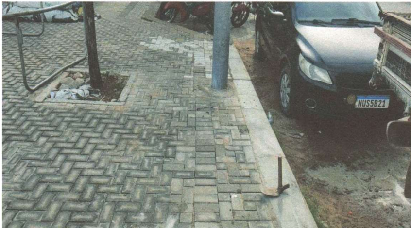
RECOMPOSIÇÃO EM INTERTRAVADO E MEIO FIO
