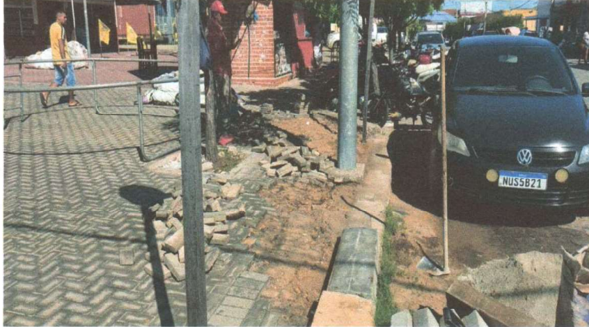
RECOMPOSIÇÃO EM INTERTRAVADO E MEIO FIO
