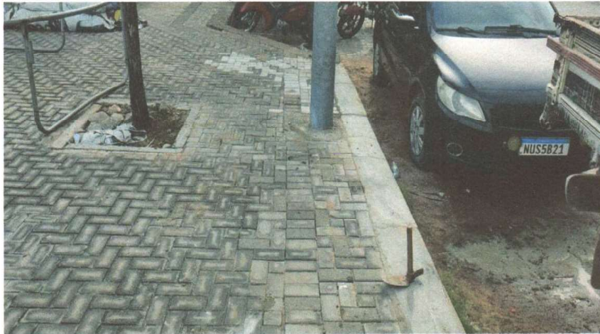
RECOMPOSIÇÃO EM INTERTRAVADO E MEIO FIO
