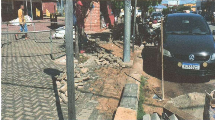
RECOMPOSIÇÃO EM INTERTRAVADO E MEIO FIO
