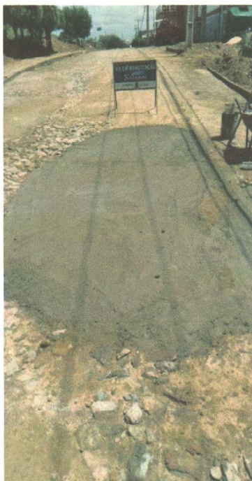
RECOMPOSIÇÃO DA PAVIMENTAÇÃO EM PEDRA TOSCA
