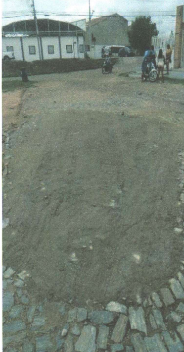
RECOMPOSIÇÃO DA PAVIMENTAÇÃO EM PEDRA TOSCA
