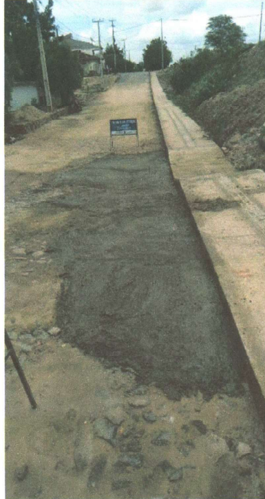
RECOMPOSIÇÃO DA PAVIMENTAÇÃO EM PEDRA TOSCA
