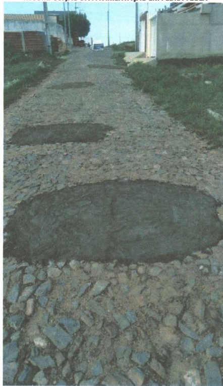
RECOMPOSIÇÃO DA PAVIMENTAÇÃO EM PEDRA TOSCA
