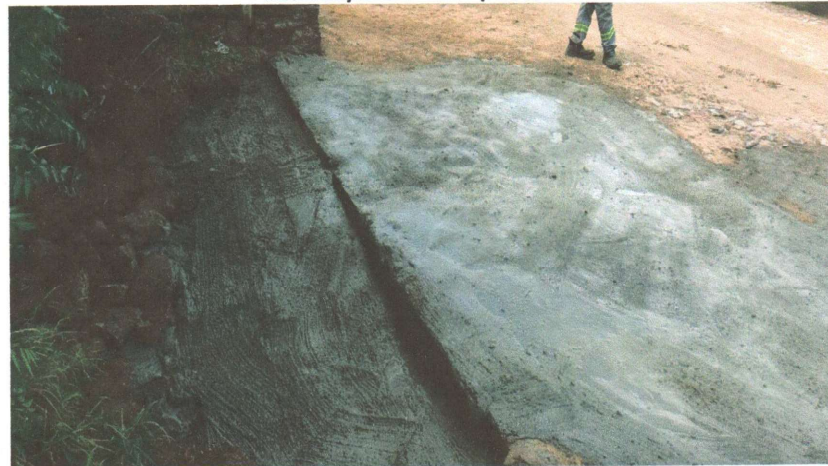
RECOMPOSIÇÃO EM PAVIMENTAÇÃO EM PEDRA TOSCA E MEIO FIO
