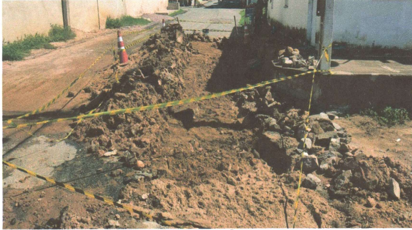
RECOMPOSIÇÃO DA PAVIMENTAÇÃO EM PEDRA TOSCA
