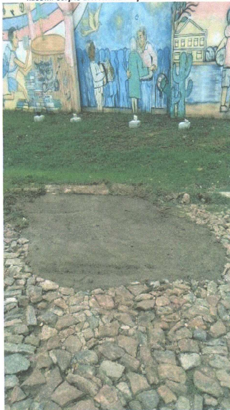
RECOMPOSIÇÃO DA PAVIMENTAÇÃO EM PEDRA TOSCA
