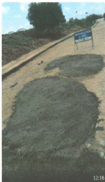
RECOMPOSIÇÃO DA PAVIMENTAÇÃO EM PEDRA TOSCA
