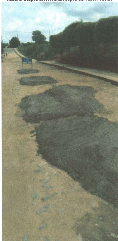
RECOMPOSIÇÃO DA PAVIMENTAÇÃO EM PEDRA TOSCA
