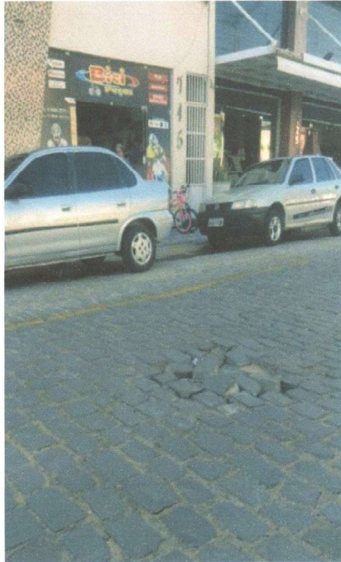
RECOMPOSIÇÃO EM PARALELEPIPEDO
