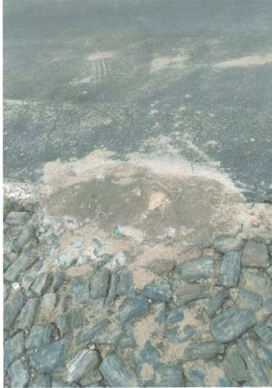
RECOMPOSIÇÃO DA PAVIMENTAÇÃO EM PEDRA TOSCA
