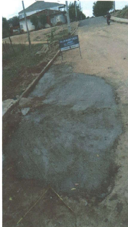
RECOMPOSIÇÃO DA PAVIMENTAÇÃO EM PEDRA TOSCA
