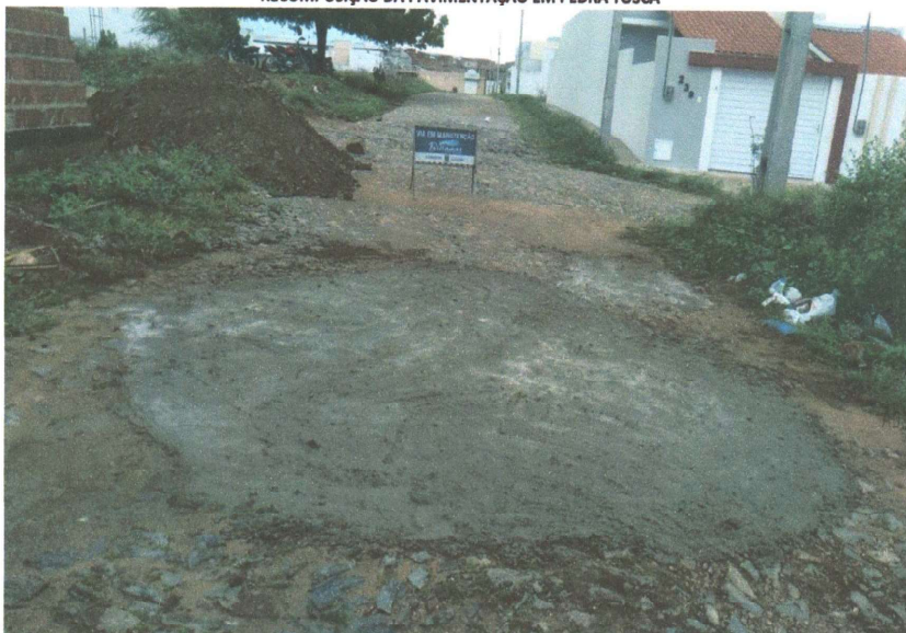
RECOMPOSIÇÃO DA PAVIMENTAÇÃO EM PEDRA TOSCA
