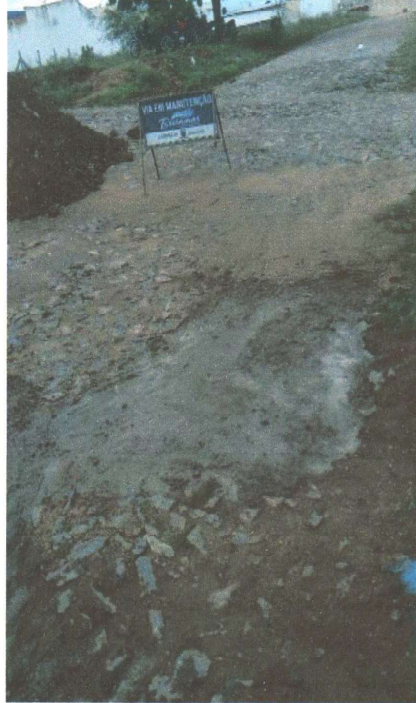
RECOMPOSIÇÃO DA PAVIMENTAÇÃO EM PEDRA TOSCA
