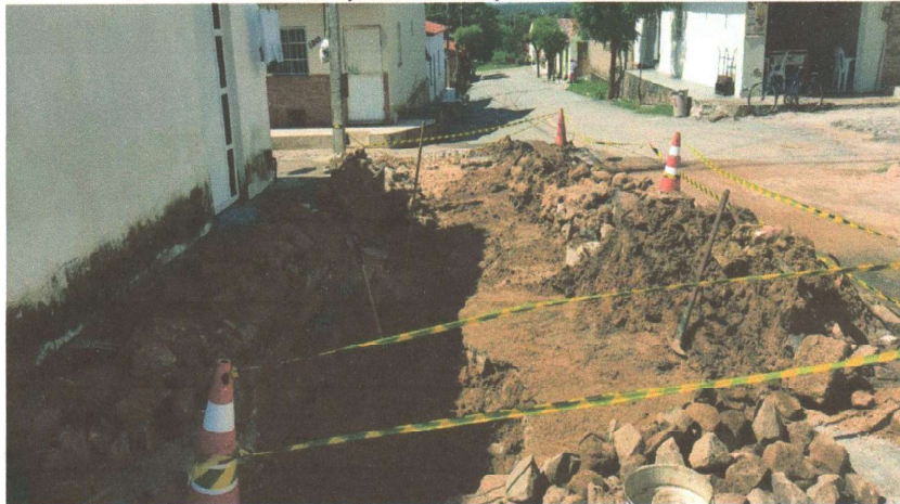
RECOMPOSIÇÃO DA PAVIMENTAÇÃO EM PEDRA TOSCA
