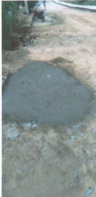
RECOMPOSIÇÃO DA PAVIMENTAÇÃO EM PEDRA TOSCA
