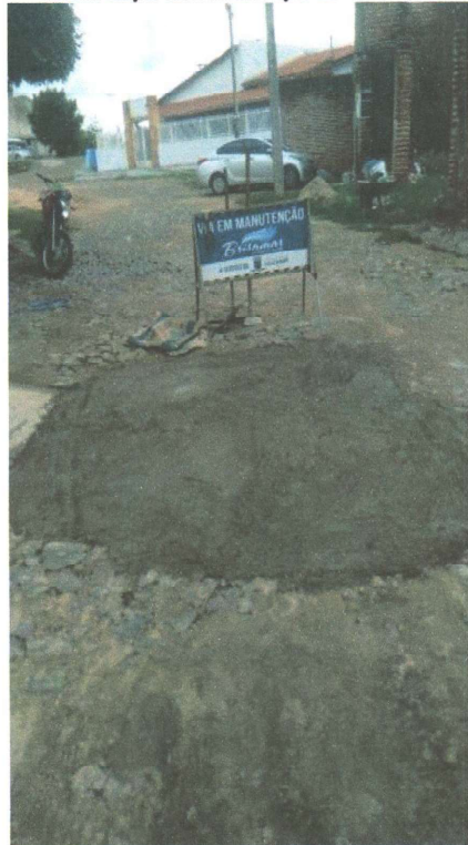
RECOMPOSIÇÃO DA PAVIMENTAÇÃO EM PEDRA TOSCA
