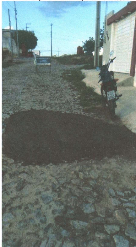
RECOMPOSIÇÃO DA PAVIMENTAÇÃO EM PEDRA TOSCA
