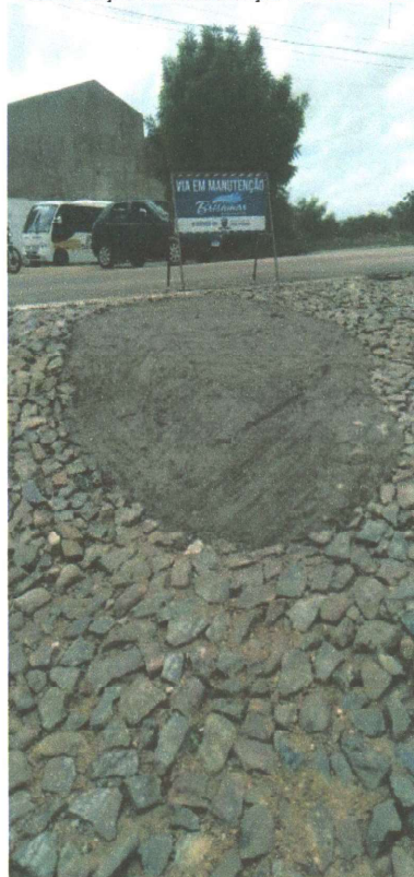
RECOMPOSIÇÃO DA PAVIMENTAÇÃO EM PEDRA TOSCA
