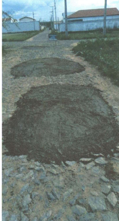
RECOMPOSIÇÃO DA PAVIMENTAÇÃO EM PEDRA TOSCA
