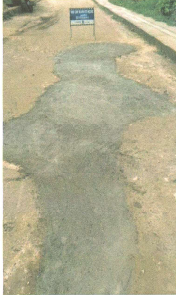
RECOMPOSIÇÃO DA PAVIMENTAÇÃO EM PEDRA TOSCA
