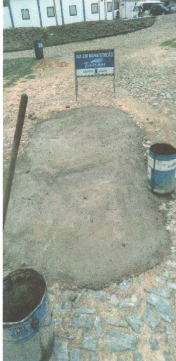
RECOMPOSIÇÃO DA PAVIMENTAÇÃO EM PEDRA TOSCA
