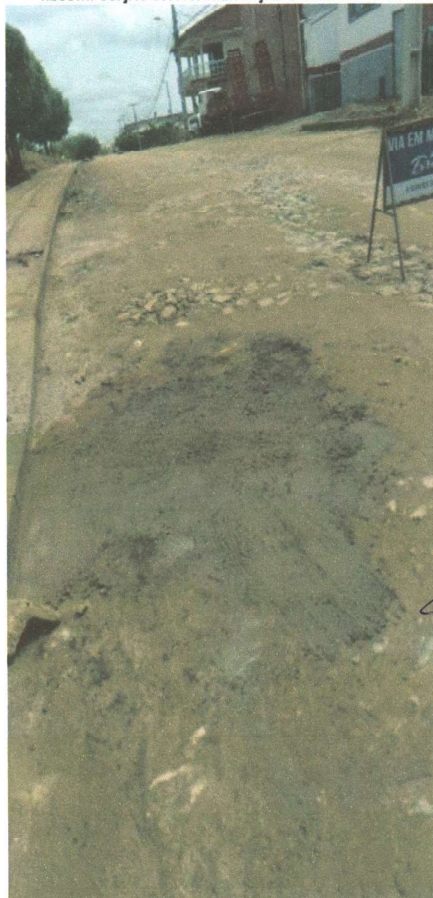
RECOMPOSIÇÃO DA PAVIMENTAÇÃO EM PEDRA TOSCA
