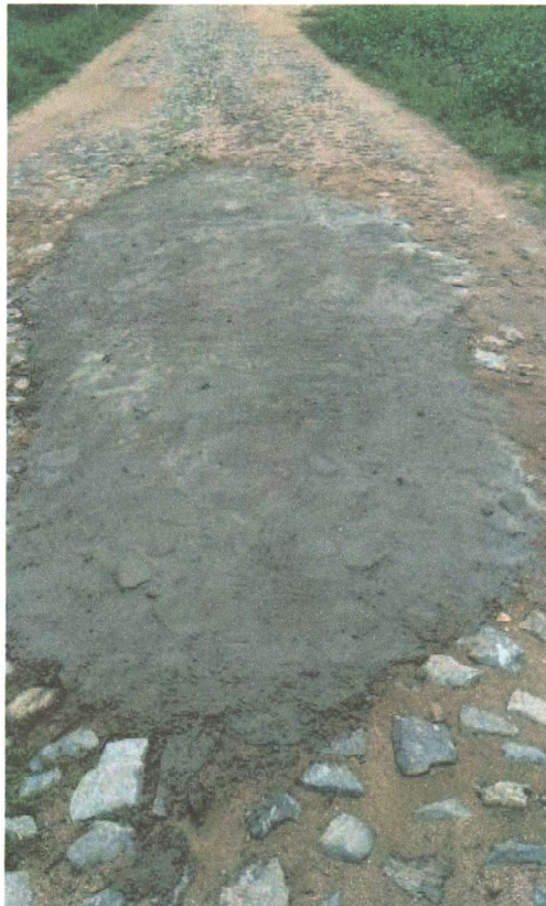
RECOMPOSIÇÃO DA PAVIMENTAÇÃO EM PEDRA TOSCA
