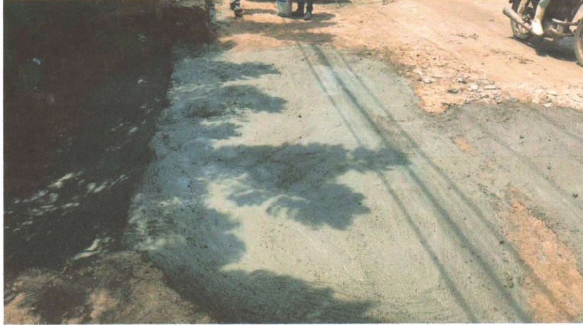
RECOMPOSIÇÃO EM PAVIMENTAÇÃO EM PEDRA TOSCA E MEIO FIO
