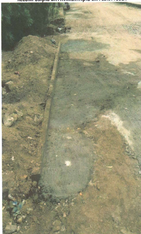
RECOMPOSIÇÃO DA PAVIMENTAÇÃO EM PEDRA TOSCA
