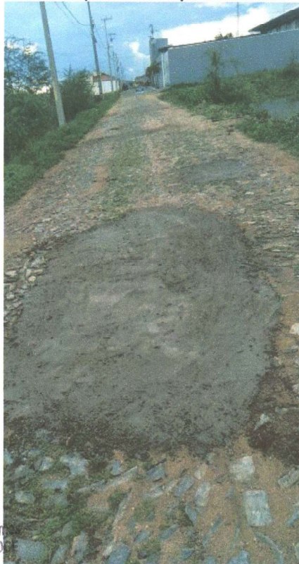
RECOMPOSIÇÃO DA PAVIMENTAÇÃO EM PEDRA TOSCA
