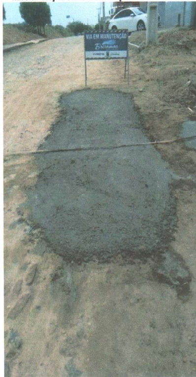
RECOMPOSIÇÃO DA PAVIMENTAÇÃO EM PEDRA TOSCA
