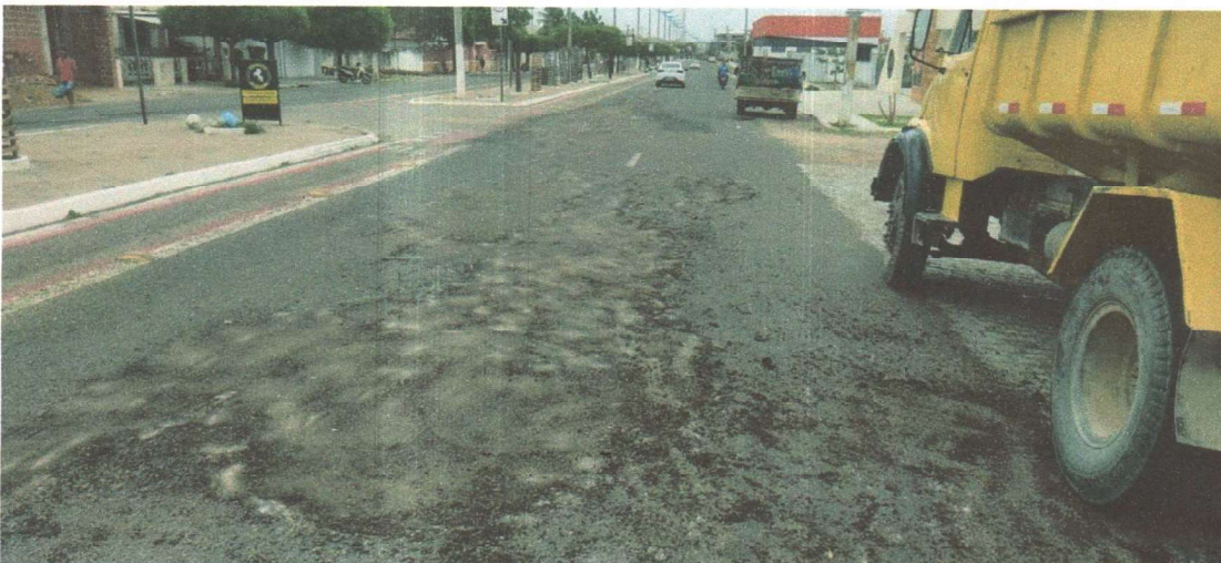
RECOMPOSIÇÃO DA PAVIMENTAÇÃO ASFÁLTICA
