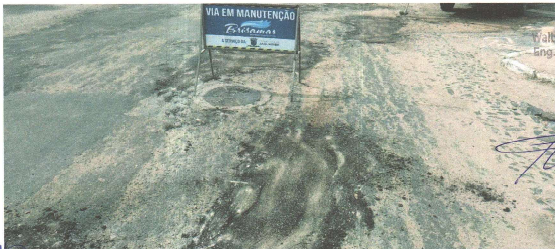
RECOMPOSIÇÃO DA PAVIMENTAÇÃO ASFÁLTICA
