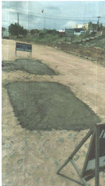
RECOMPOSIÇÃO DA PAVIMENTAÇÃO
