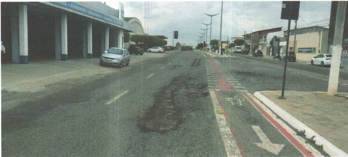
RECOMPOSIÇÃO DA PAVIMENTAÇÃO ASFÁLTICA
