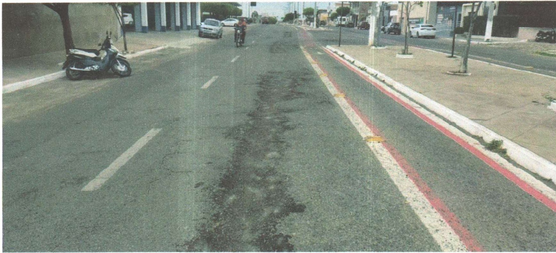
RECOMPOSIÇÃO DA PAVIMENTAÇÃO ASFÁLTICA
