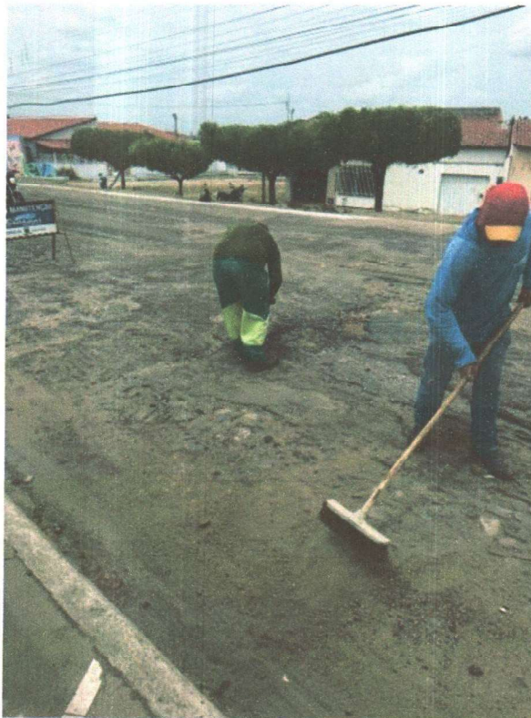
LIMPEZA DA ÁREA PARA RECEBER A PINTURA DE LIGAÇÃO
