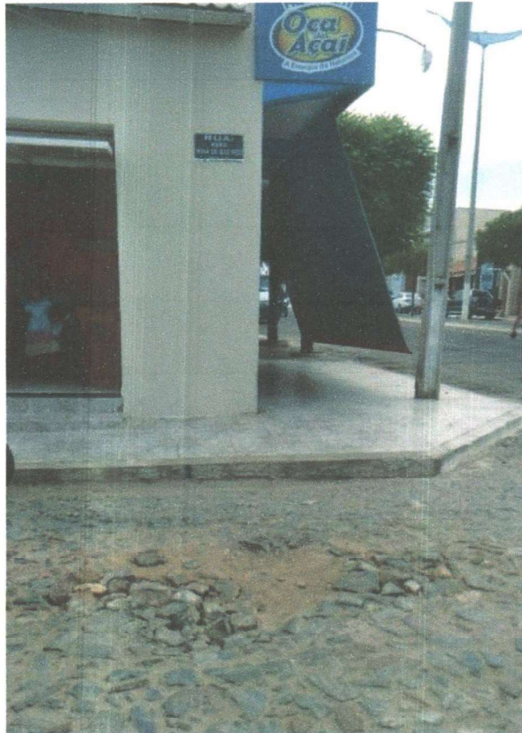
RECOMPOSIÇÃO DA PAVIMENTAÇÃO
