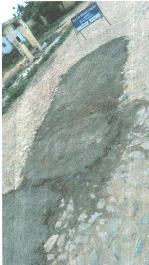
RECOMPOSIÇÃO DA PAVIMENTAÇÃO EM PEDRA TOSCA
