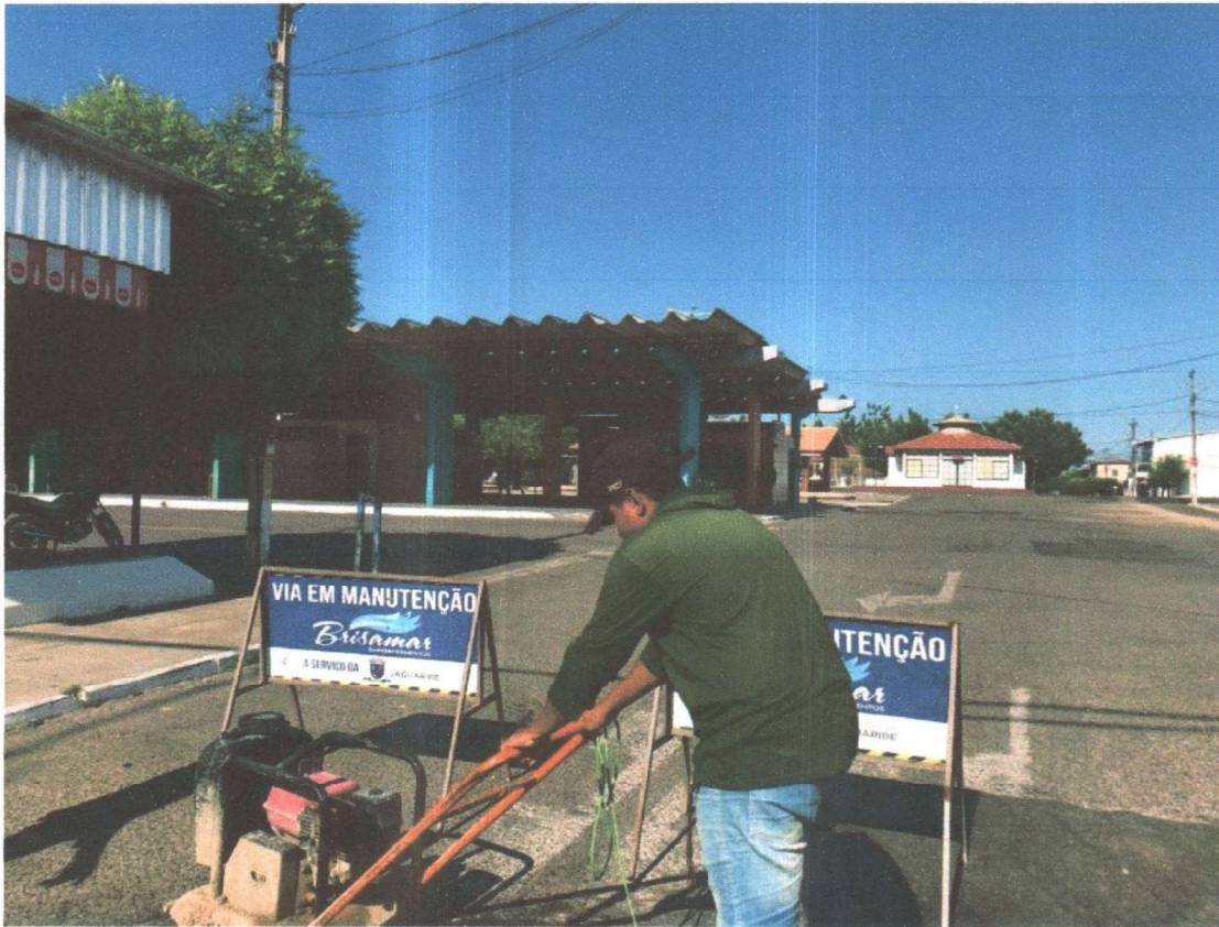
RECOMPOSIÇÃO DA PAVIMENTAÇÃO ASFÁLTICA
