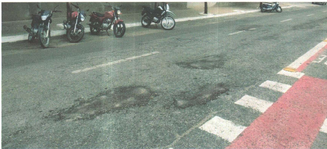
RECOMPOSIÇÃO DA PAVIMENTAÇÃO ASFÁLTICA
