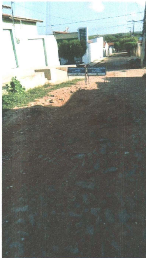
RECOMPOSIÇÃO DA PAVIMENTAÇÃO EM PEDRA TOSCA
