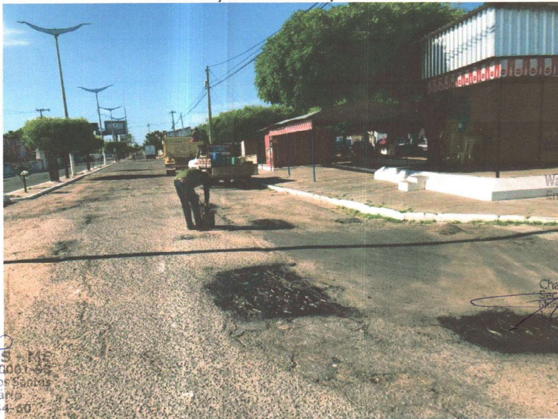
RECOMPOSIÇÃO DA PAVIMENTAÇÃO ASFÁLTICA
