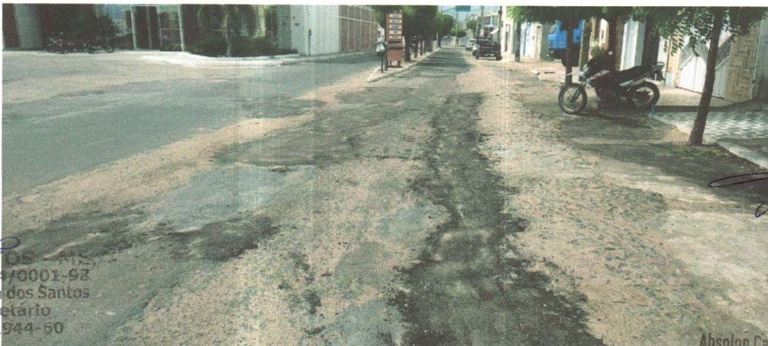
RECOMPOSIÇÃO DA PAVIMENTAÇÃO ASFÁLTICA
