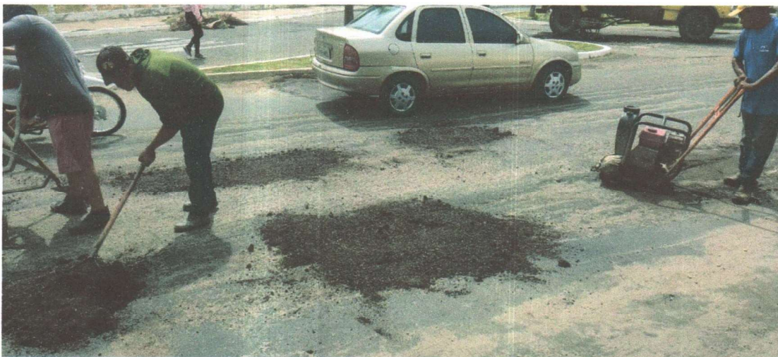
RECOMPOSIÇÃO DA PAVIMENTAÇÃO ASFÁLTICA
