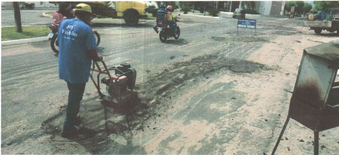
RECOMPOSIÇÃO DA PAVIMENTAÇÃO ASFÁLTICA
