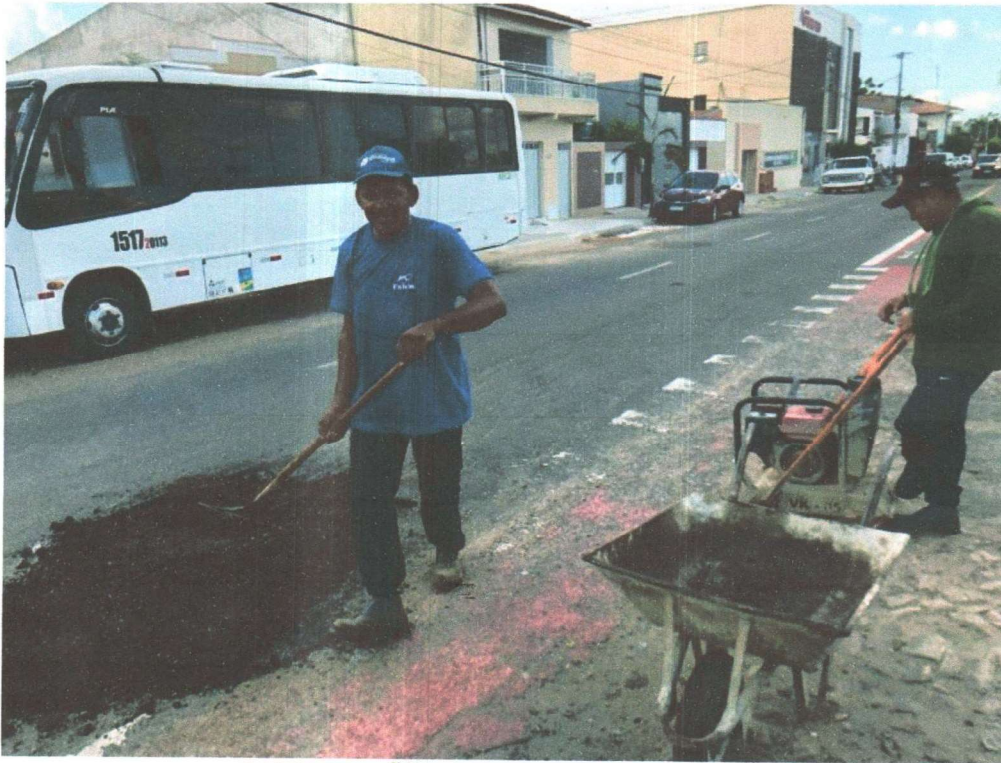
RECOMPOSIÇÃO DA PAVIMENTAÇÃO ASFÁLTICA
