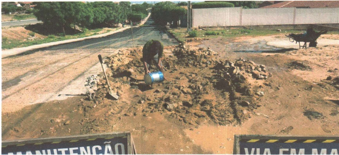
RECOMPOSIÇÃO DA PAVIMENTAÇÃO NA RUA ELIZARIO PINHEIRO
