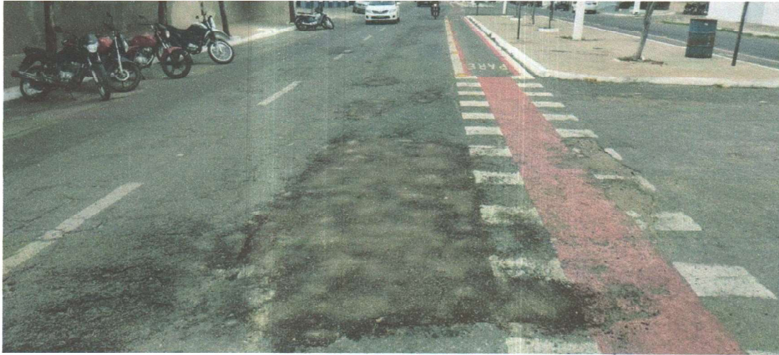
RECOMPOSIÇÃO DA PAVIMENTAÇÃO ASFÁLTICA
