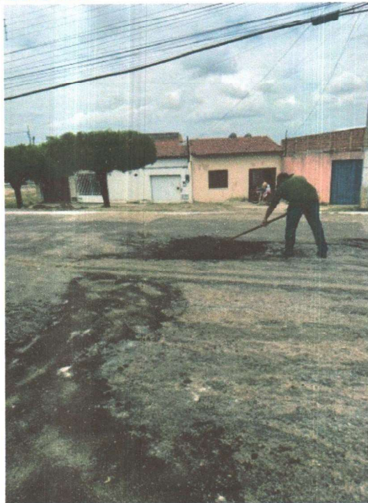
RECOMPOSIÇÃO DA PAVIMENTAÇÃO ASFÁLTICA
