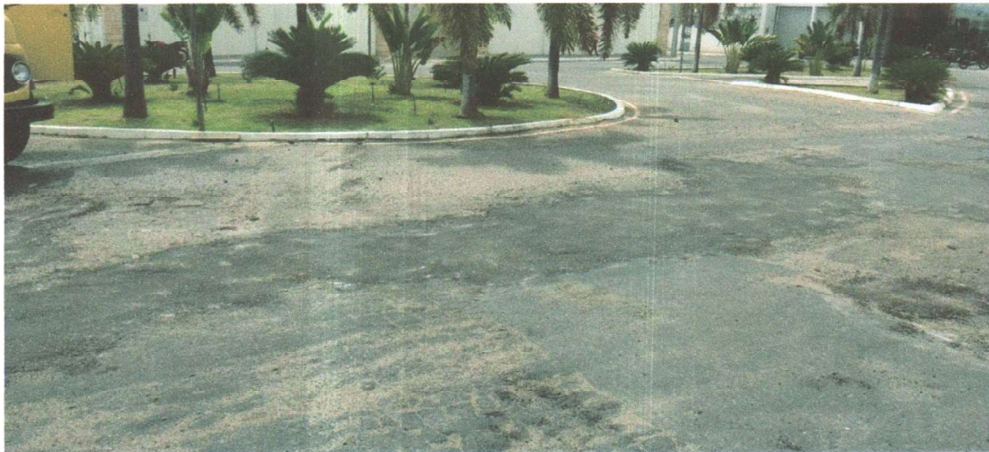
RECOMPOSIÇÃO DA PAVIMENTAÇÃO ASFÁLTICA
