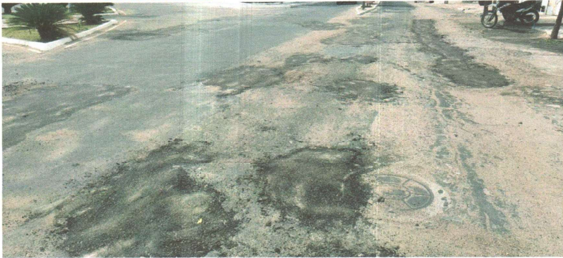
RECOMPOSIÇÃO DA PAVIMENTAÇÃO ASFÁLTICA
