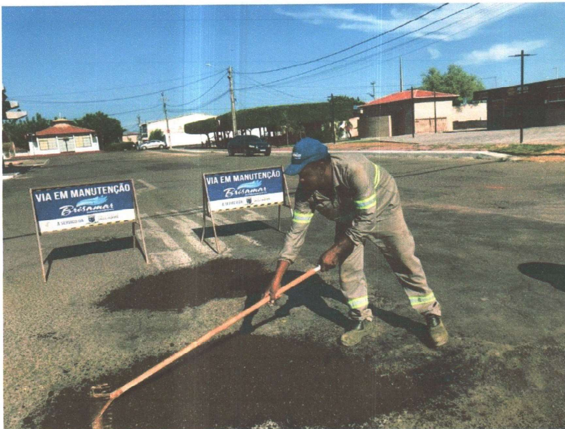
RECOMPOSIÇÃO DA PAVIMENTAÇÃO ASFÁLTICA
