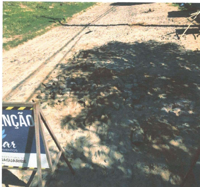
RECOMPOSIÇÃO DA PAVIMENTAÇÃO
