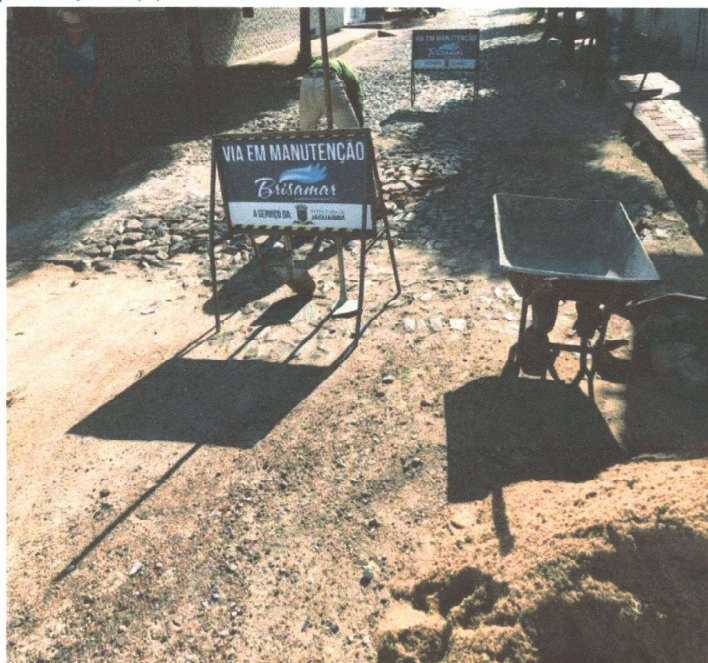
RECOMPOSIÇÃO DA PAVIMENTAÇÃO
