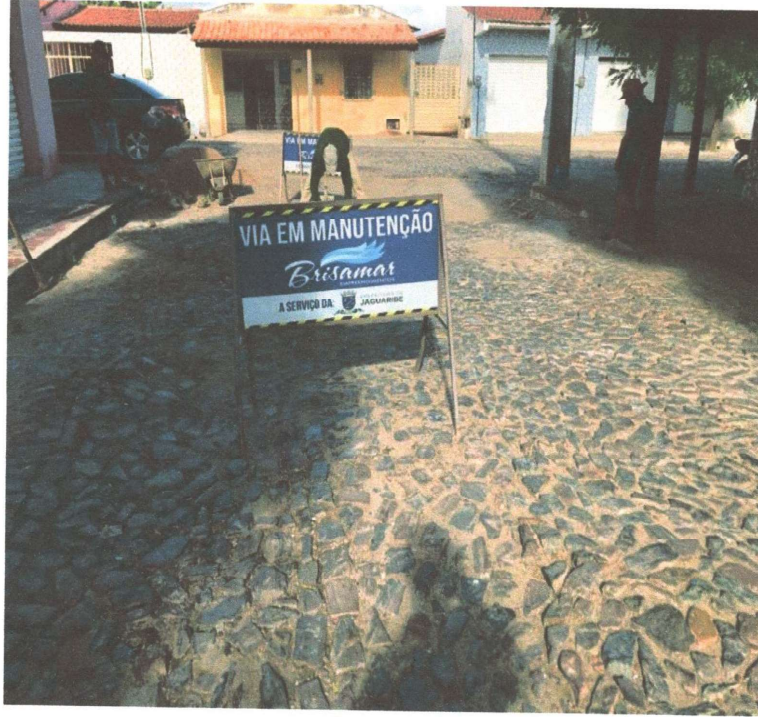
RECOMPOSIÇÃO DA PAVIMENTAÇÃO
