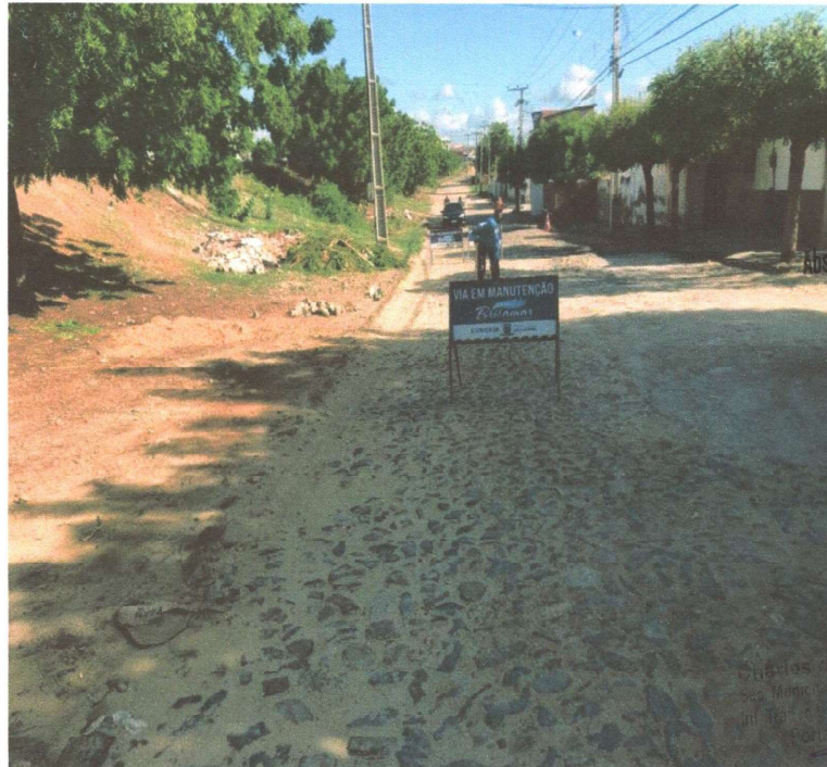
RECOMPOSIÇÃO DA PAVIMENTAÇÃO
