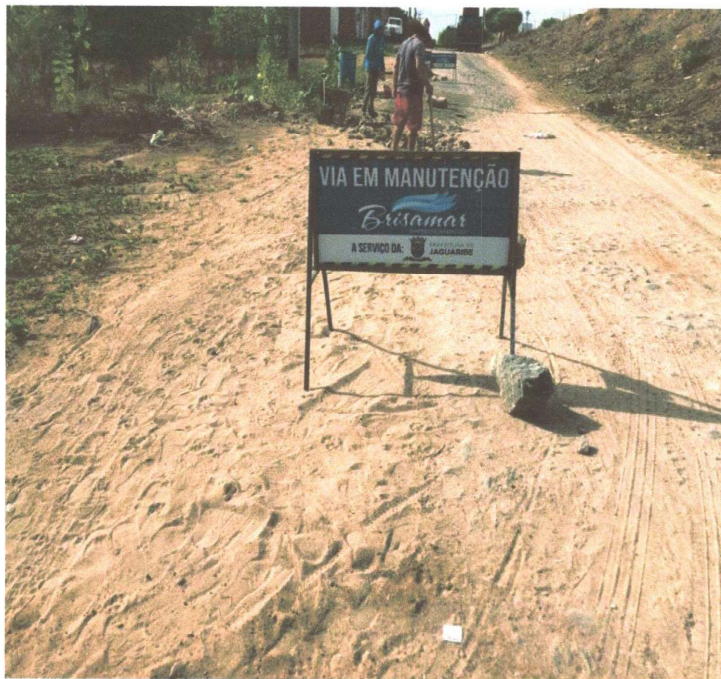
RECOMPOSIÇÃO DA PAVIMENTAÇÃO
