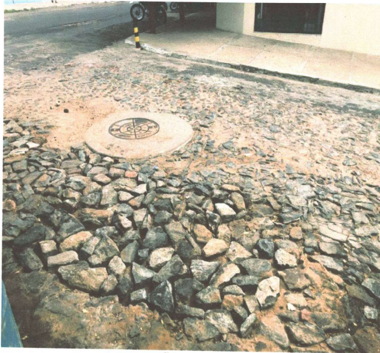
RECOMPOSIÇÃO DA PAVIMENTAÇÃO
