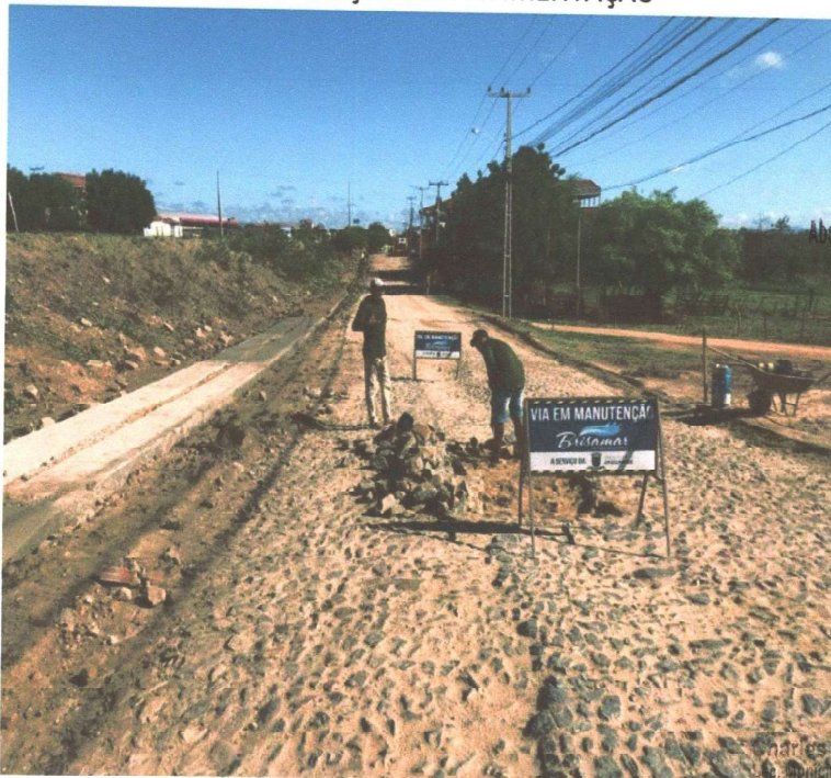
RECOMPOSIÇÃO DA PAVIMENTAÇÃO
