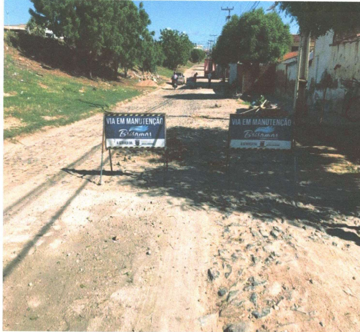
RECOMPOSIÇÃO DA PAVIMENTAÇÃO
