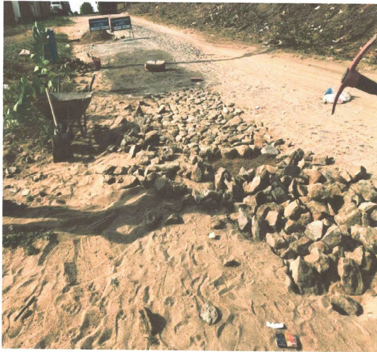
RECOMPOSIÇÃO DA PAVIMENTAÇÃO
