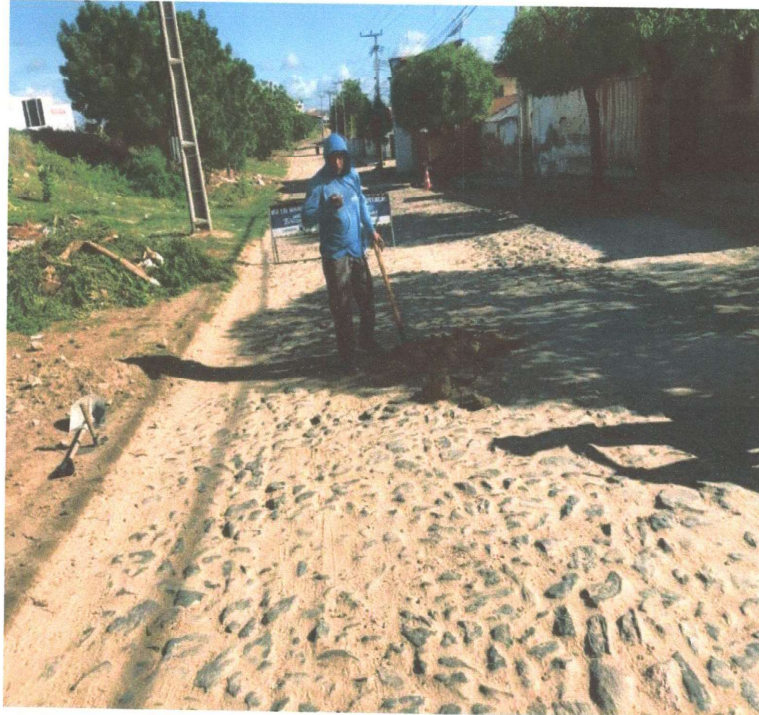
RECOMPOSIÇÃO DA PAVIMENTAÇÃO
