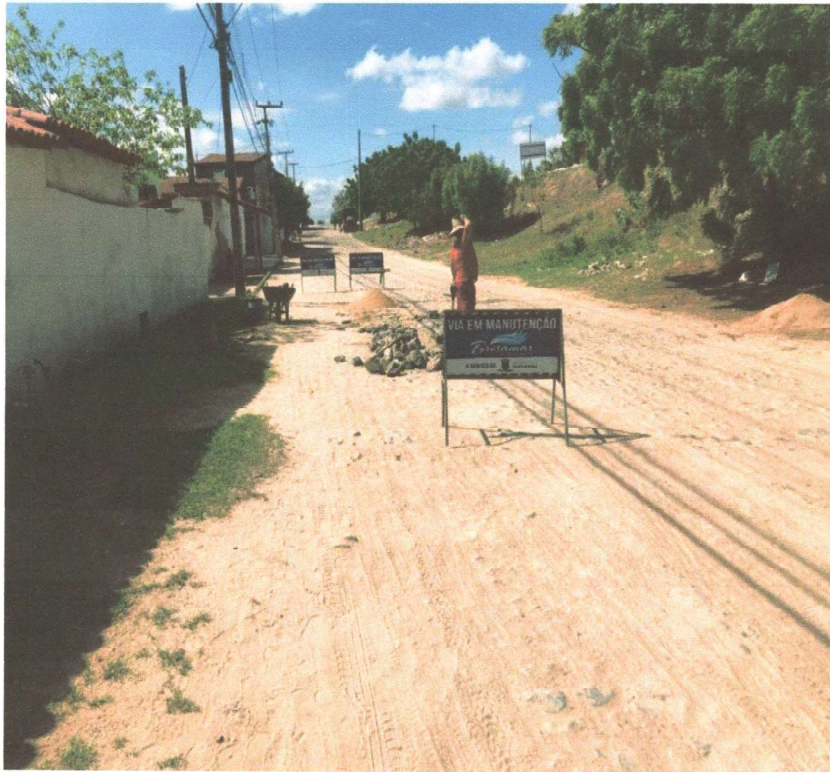
RECOMPOSIÇÃO DA PAVIMENTAÇÃO
