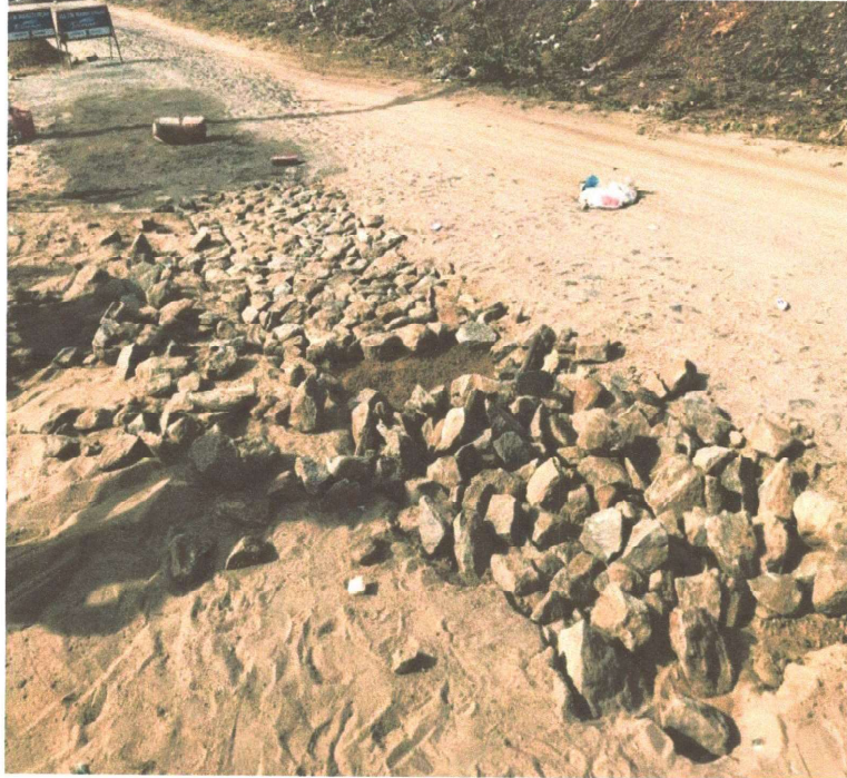
RECOMPOSIÇÃO DA PAVIMENTAÇÃO
