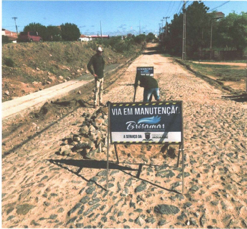
RECOMPOSIÇÃO DA PAVIMENTAÇÃO
