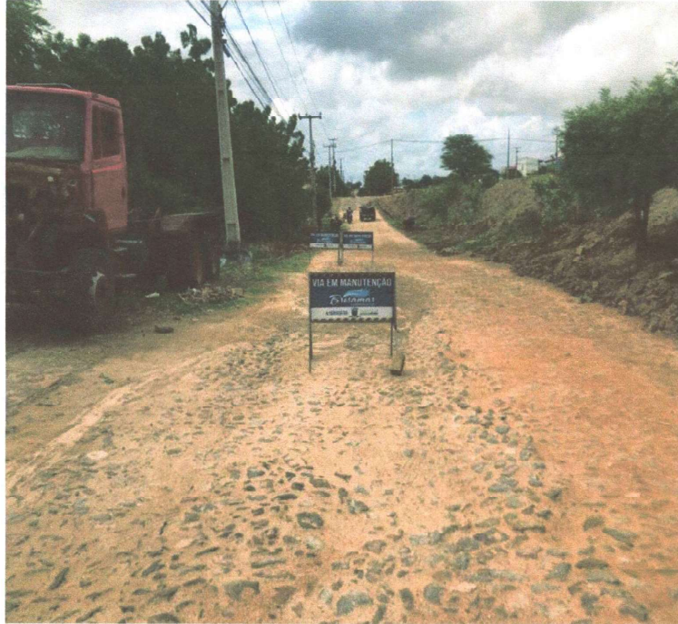
RECOMPOSIÇÃO DA PAVIMENTAÇÃO
