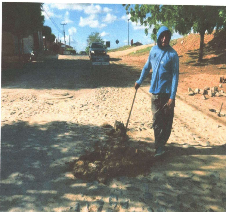
RECOMPOSIÇÃO DA PAVIMENTAÇÃO
