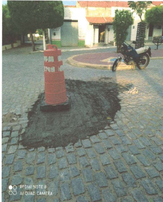
RECOMPOSIÇÃO DA PAVIMENTAÇÃO
