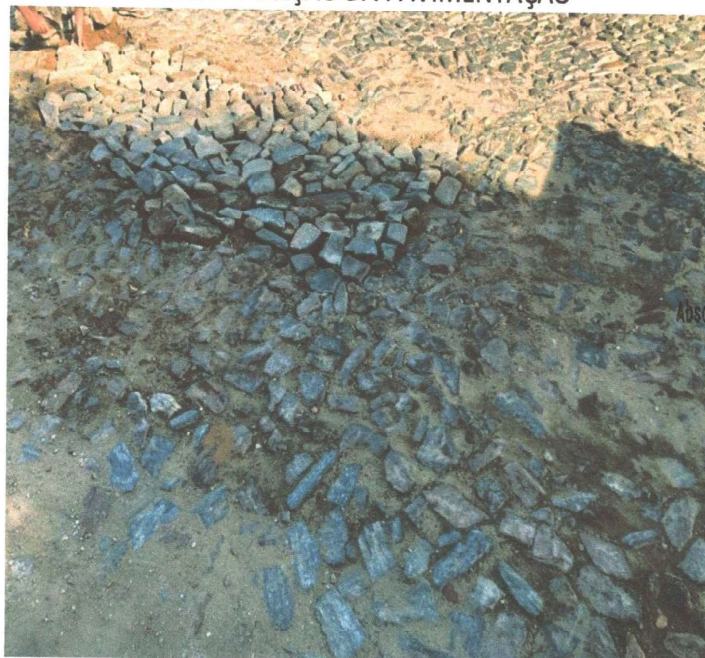
RECOMPOSIÇÃO DA PAVIMENTAÇÃO
