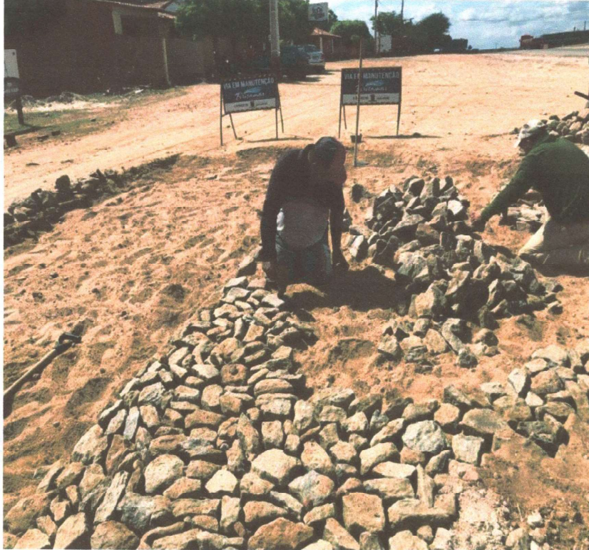
RECOMPOSIÇÃO DA PAVIMENTAÇÃO
