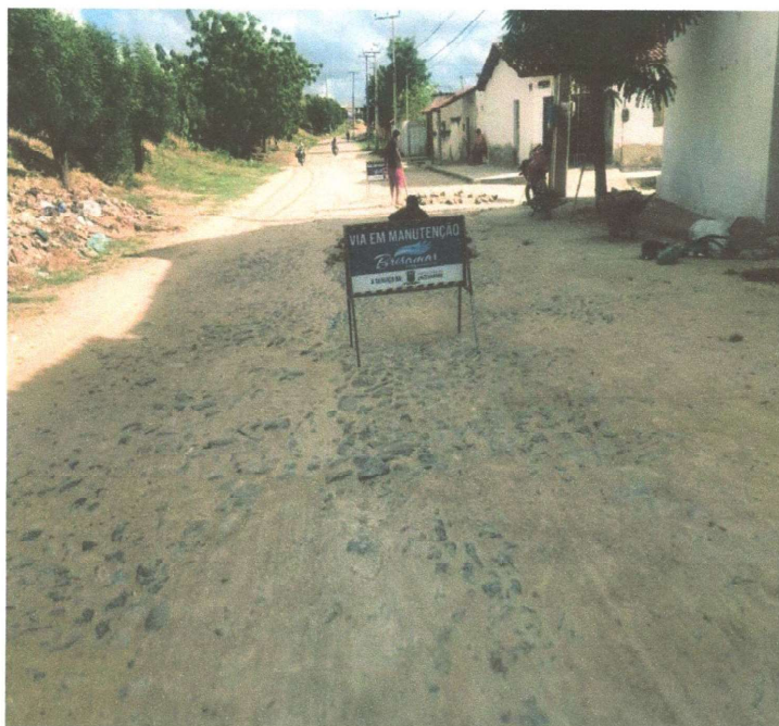
RECOMPOSIÇÃO DA PAVIMENTAÇÃO
