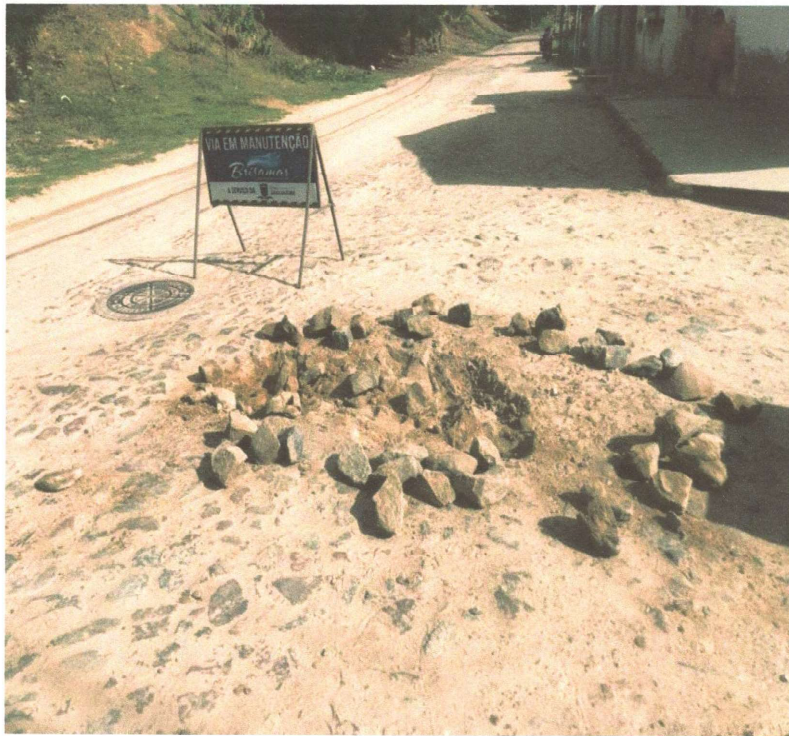
RECOMPOSIÇÃO DA PAVIMENTAÇÃO
