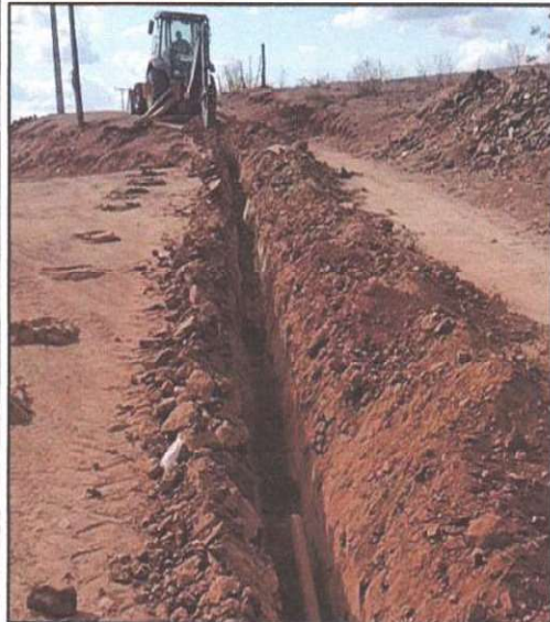
ESCAVAÇÃO DE VALA DA ADUTORA AROEIRA - RIACHO DO MEIO
