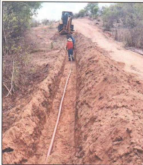
ESCAVAÇÃO DE VALA DA ADUTORA AROEIRA - RIACHO DO MEIO
