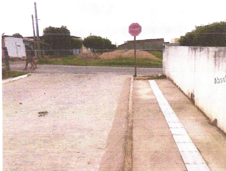
EXECUÇÃO DE PASSEIO COM PISO PODOTÁTIL
