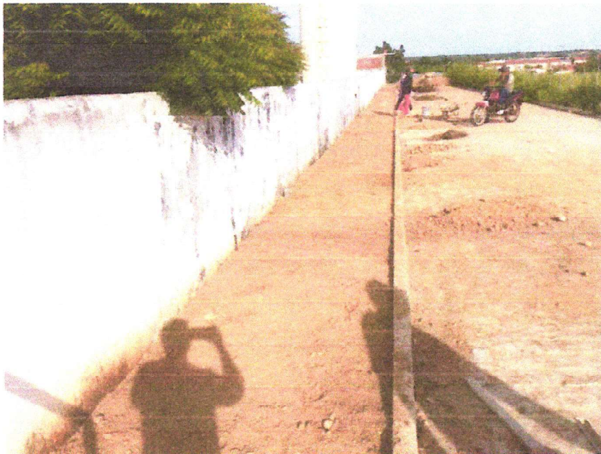
EXECUÇÃO DE PASSEIO
