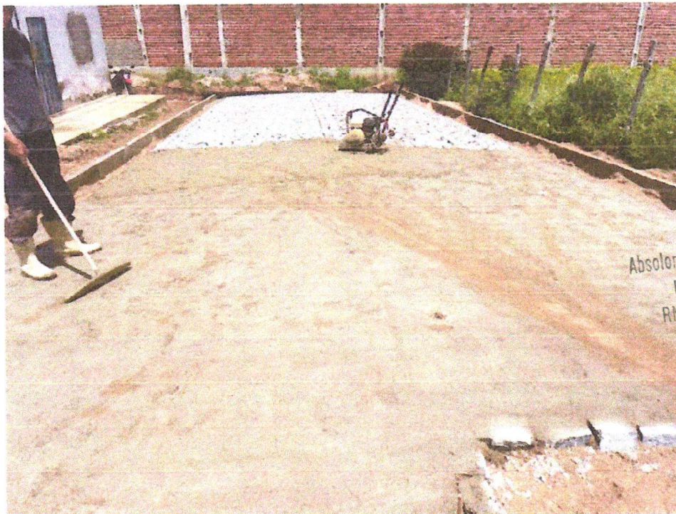
REJUNTAMENTO COM ARGAMASSA
