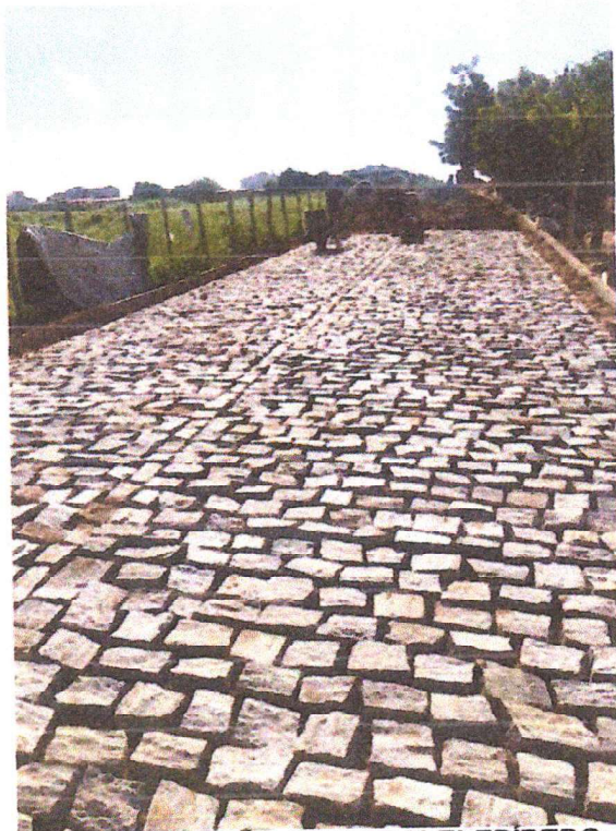
PAVIMENTAÇÃO EM PARALELEPIPEDO
