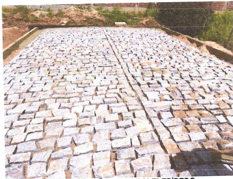
PAVIMENTAÇÃO EM PARALELEPIPEDO
