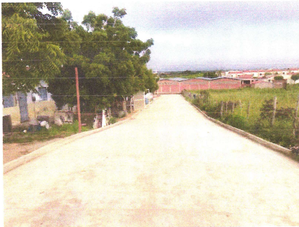
PAVIMENTAÇÃO EM PARALELEPÍPEDO
