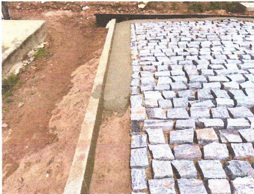
EXECUÇÃO DE SARJETA DE CONCRETO
