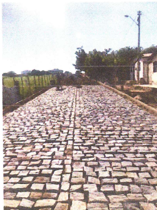
PAVIMENTAÇÃO EM PARALELEPIPEDO
