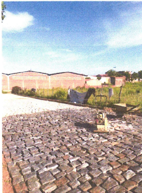
EXECUÇÃO DE REJUNTAMENTO
