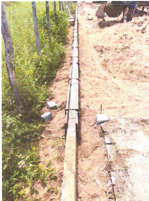
EXECUÇÃO DE MEIO FIO MOLDADO NO LOCAL
