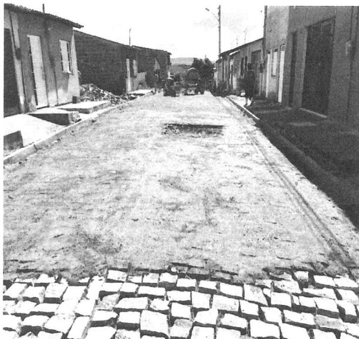
REJUNTAMENTO COM ARGAMASSA TRAÇO 1:3
