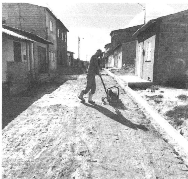
REJUNTAMENTO COM ARGAMASSA TRAÇO 1:3
