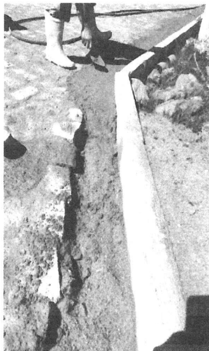
EXECUÇÃO DE SARJETA
