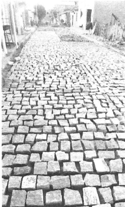
PAVIMENTAÇÃO EM PARALELEPÍPEDO
