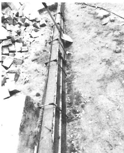
BANQUETA/MEIO FIO DE CONCRETO MOLDADO NO LOCAL
