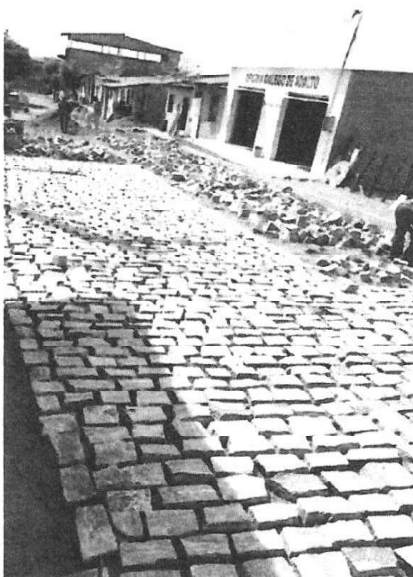
EXECUÇÃO DE PAVIMENTAÇÃO EM PARALELEPÍEDO
