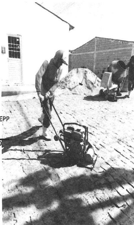
REJUNTAMENTO COM ARGAMASSA
