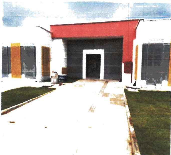
INSTALAÇÃO DE CHAPA PERFURADA NA FACHADA
