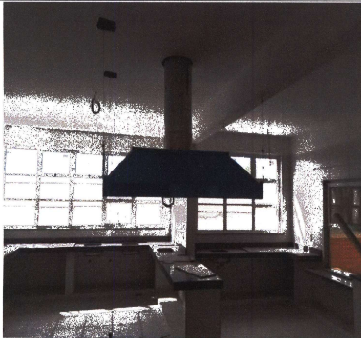
INSTALAÇÃO DE COIFA
