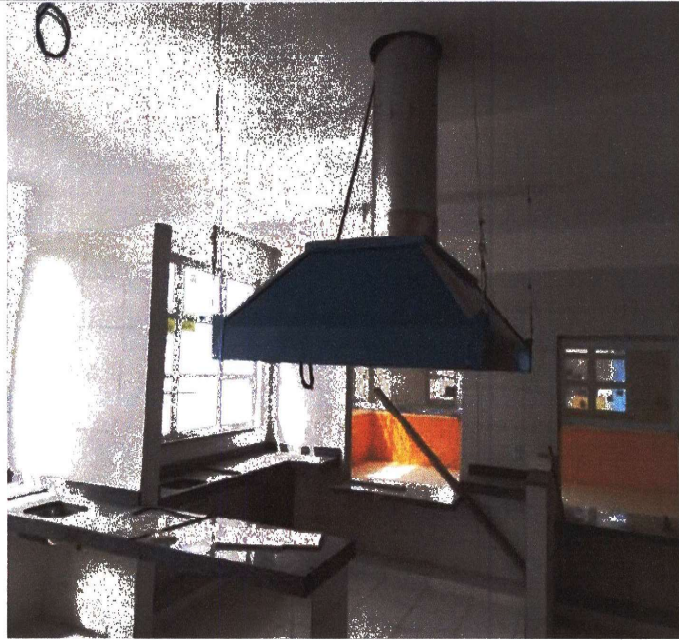
INSTALAÇÃO DE COIFA
