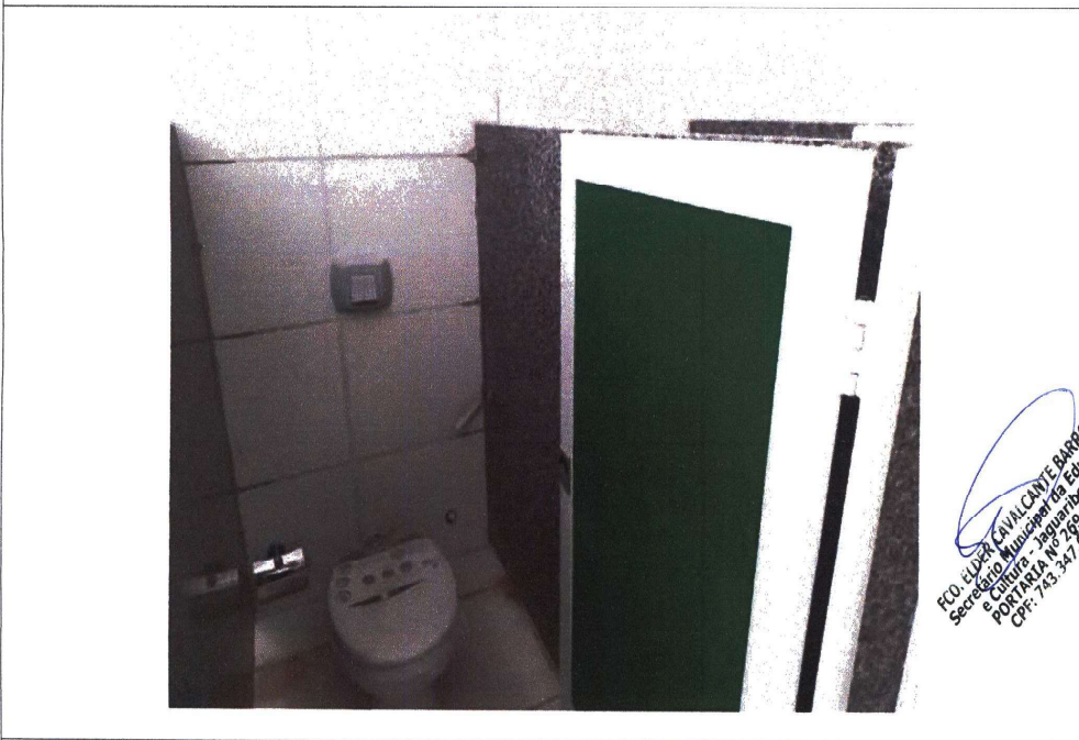
INSTALAÇÃO DE PAPELEIRAS METÁLICAS
