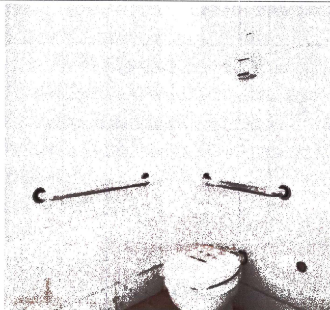
W.M CONSTRUÇÕES LTDA INSTALAÇÃO DE BARRAS DE APOIO
