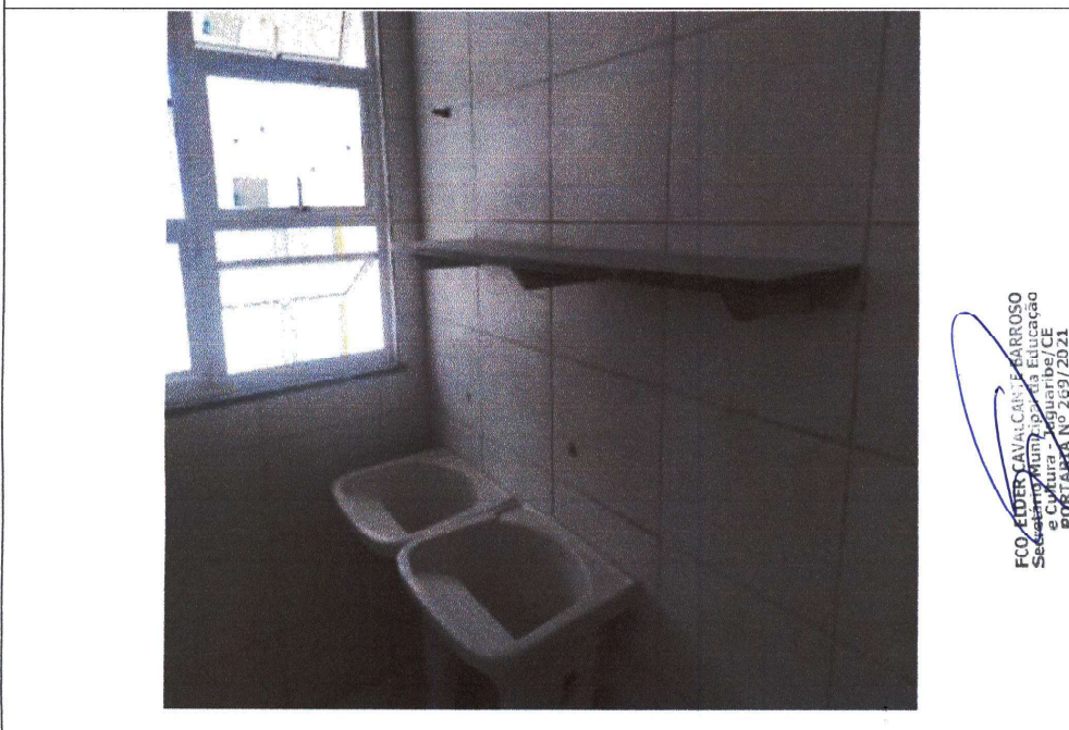
INSTALAÇÃO DE BANCADAS E PRATELEIRAS
