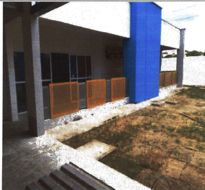
INSTALAÇÃO DE TELA MOEDA
