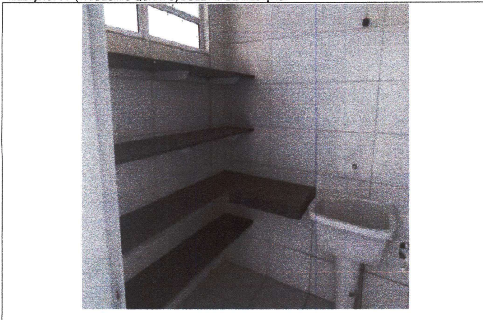
INSTALAÇÃO DE BANCADAS E PRATELEIRAS
