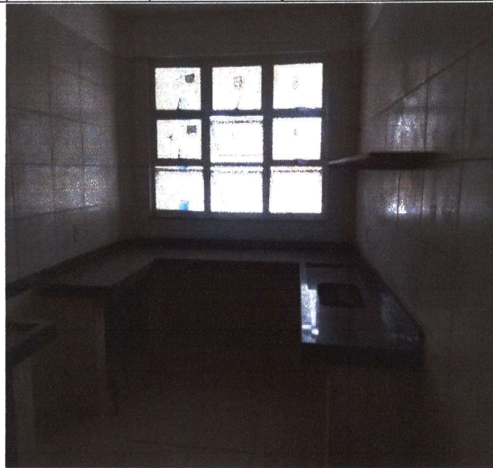
INSTALAÇÃO DE BANCADAS E PRATELEIRAS
