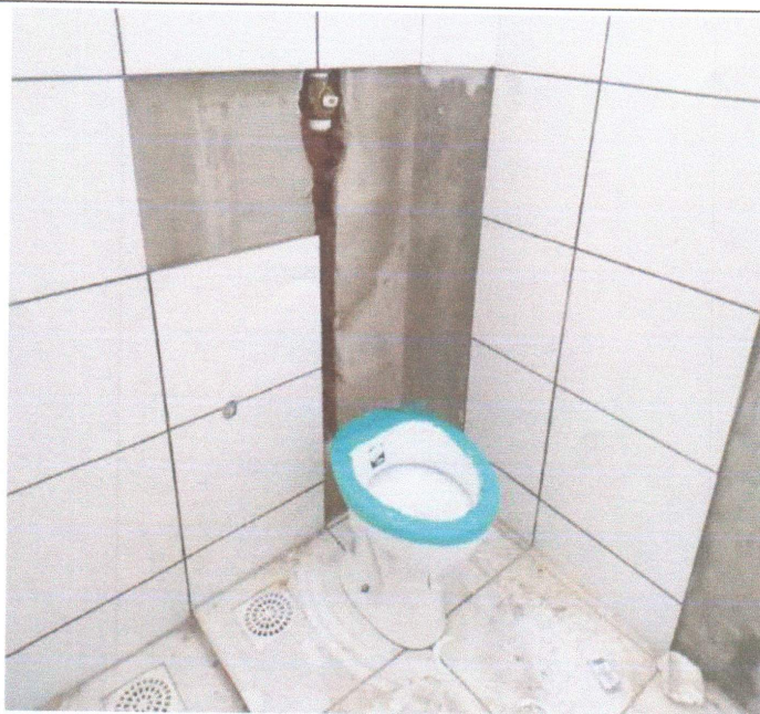
INSTALAÇÃO DE LOUÇAS E MATERIAS.
