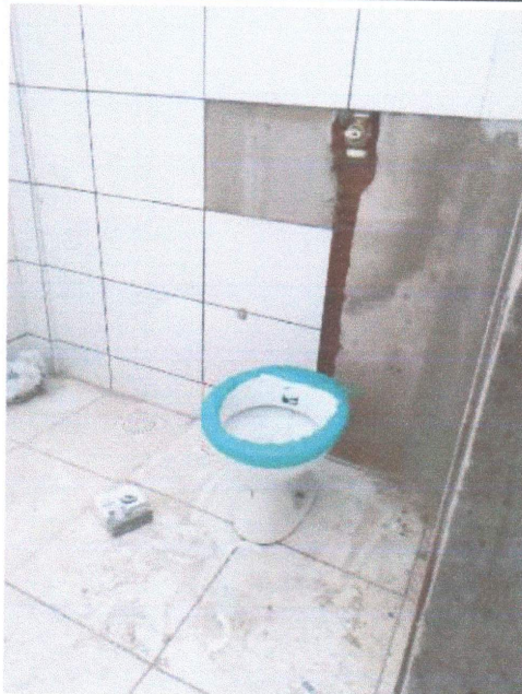
INSTALAÇÃO DE LOUÇAS E MATERIAS.
