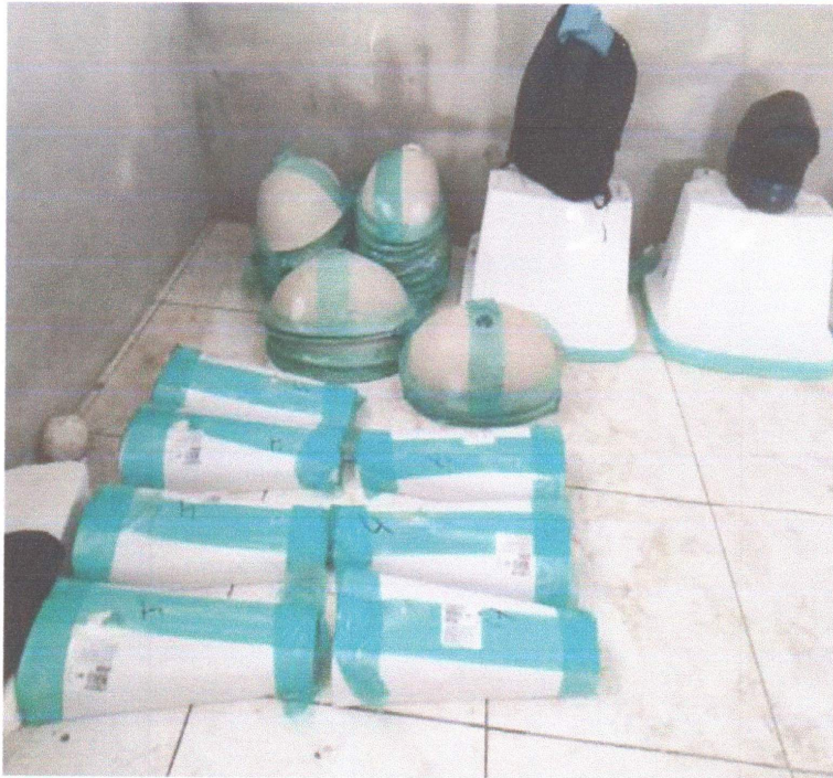
INSTALAÇÃO DE LOUÇAS E MATERIAS.
