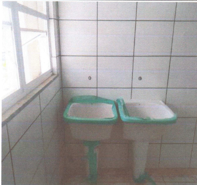
INSTALAÇÃO DE LOUÇAS E MATERIAS.
