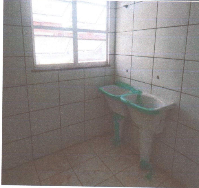
INSTALAÇÃO DE LOUÇAS E MATERIAS.
