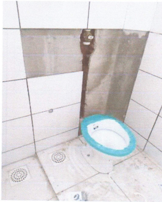
INSTALAÇÃO DE LOUÇAS E MATERIAS.
