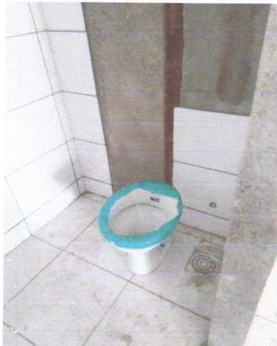
INSTALAÇÃO DE LOUÇAS E MATERIAS.
