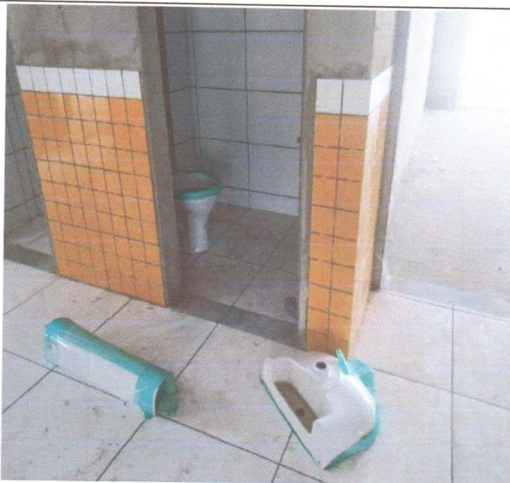
INSTALAÇÃO DE LOUÇAS E MATERIAS.
