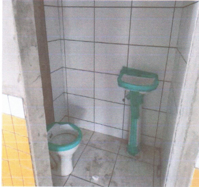
INSTALAÇÃO DE LOUÇAS E MATERIAS.
