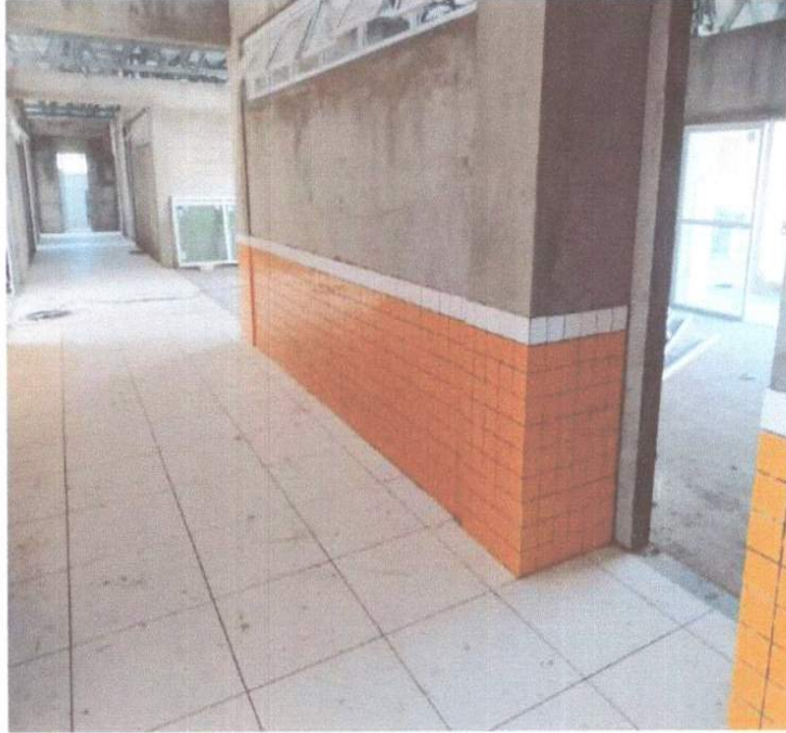
SERVIÇO DE EXECUÇÃO DE CERÂMICA.
