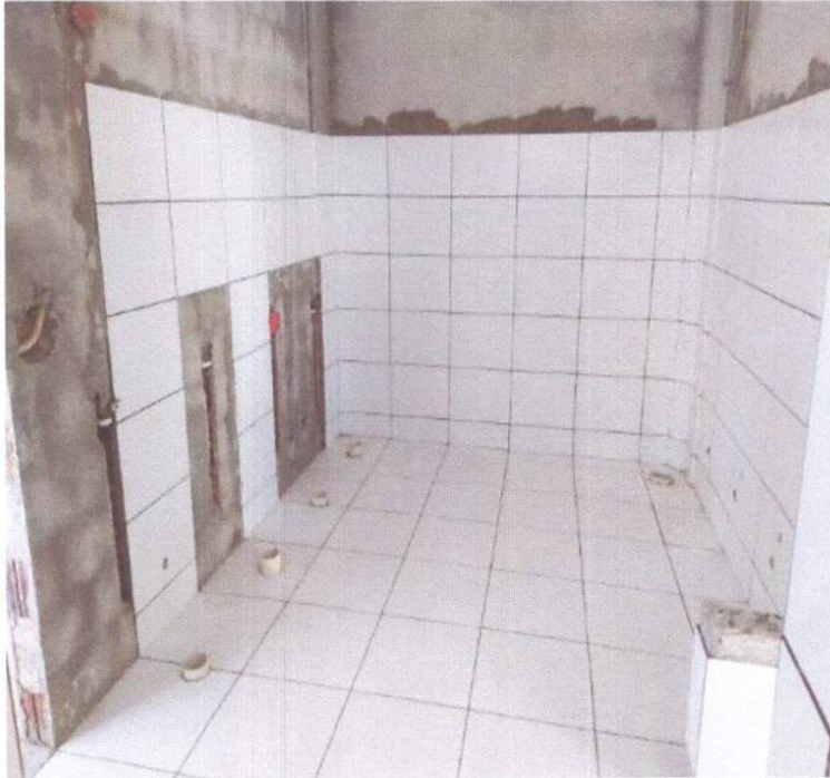
SERVIÇO DE EXECUÇÃO DE CERÂMICA.
