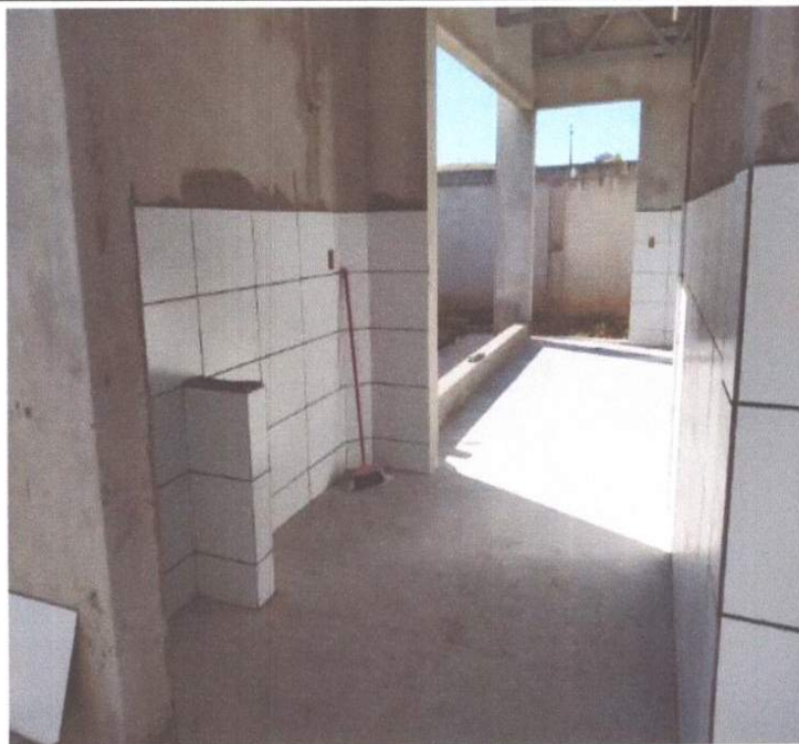
SERVIÇO DE EXECUÇÃO DE CERÂMICA.
