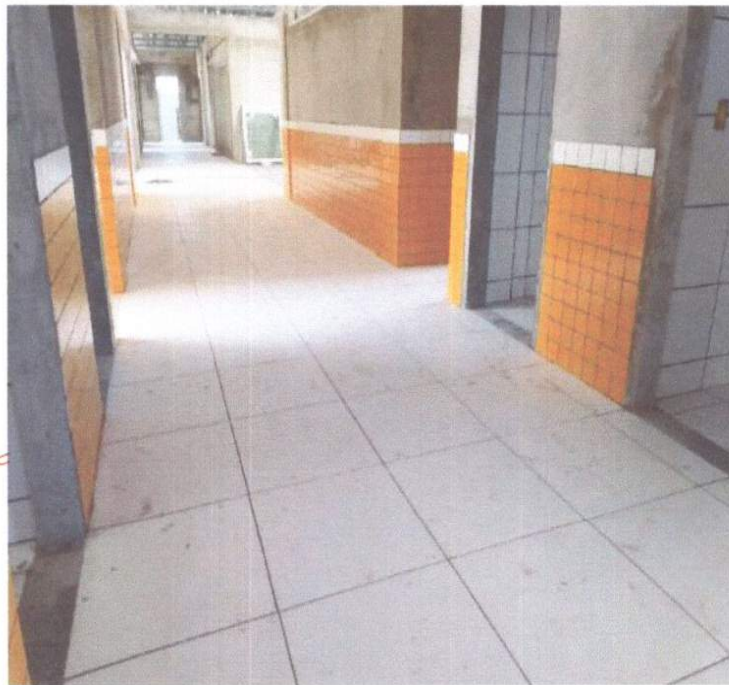
SERVIÇO DE EXECUÇÃO DE CERÂMICA.
