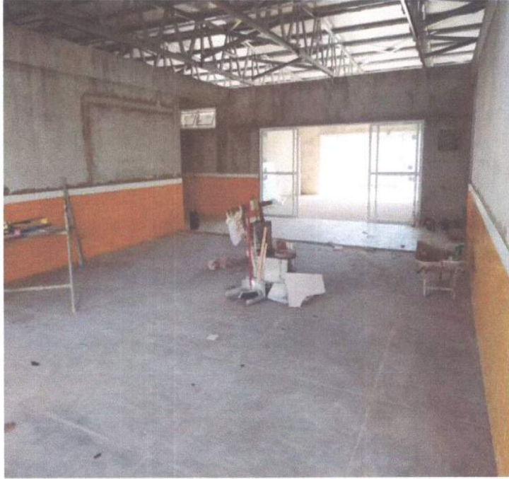
SERVIÇO DE EXECUÇÃO DE CERÂMICA.
