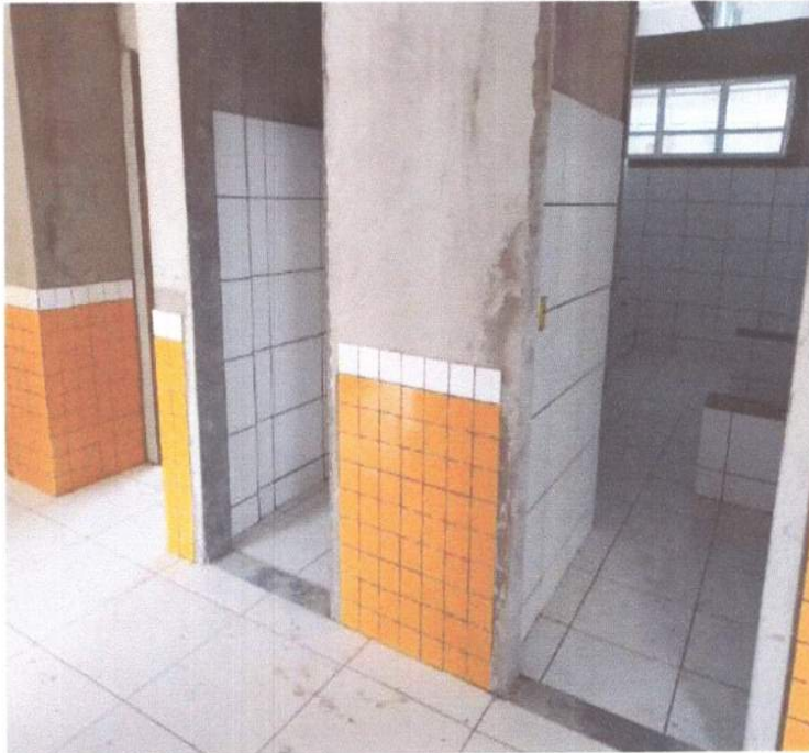
SERVIÇO DE EXECUÇÃO DE CERÂMICA.
