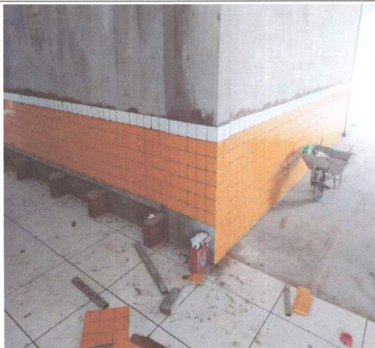
SERVIÇO DE EXECUÇÃO DE CERÂMICA.
