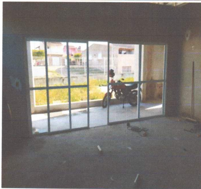
EXECUÇÃO DE ESQUADRIAS DE ALUMINIO.
