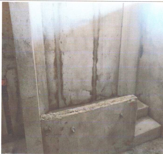
SERVIÇO DE EXECUÇÃO DE INSTALAÇÕES HIDRAULICAS – REGISTROS DE PRESSÃO.
