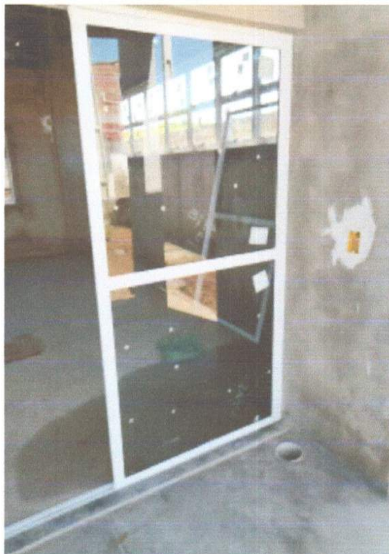
EXECUÇÃO DE ESQUADRIAS DE ALUMINIO.
