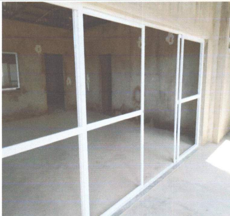
EXECUÇÃO DE ESQUADRIAS DE ALUMINIO.
