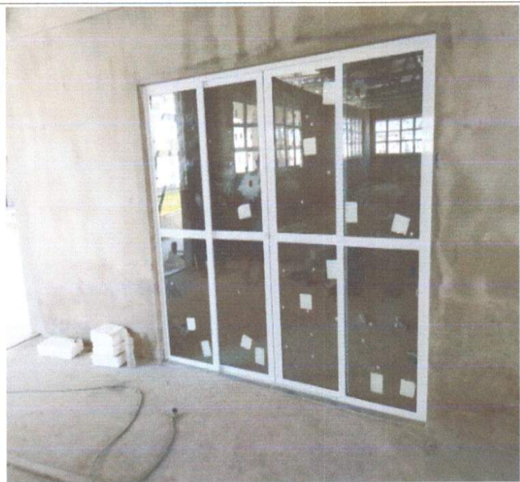
EXECUÇÃO DE ESQUADRIAS DE ALUMINIO.
