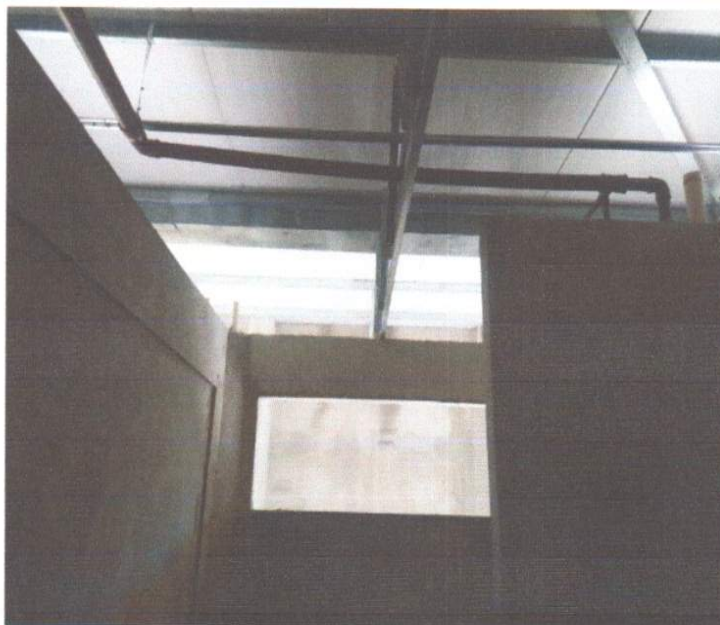
SERVIÇO DE EXECUÇÃO DE INSTALAÇÕES HIDRAULICAS – TUBOS E CONEXÕES.
