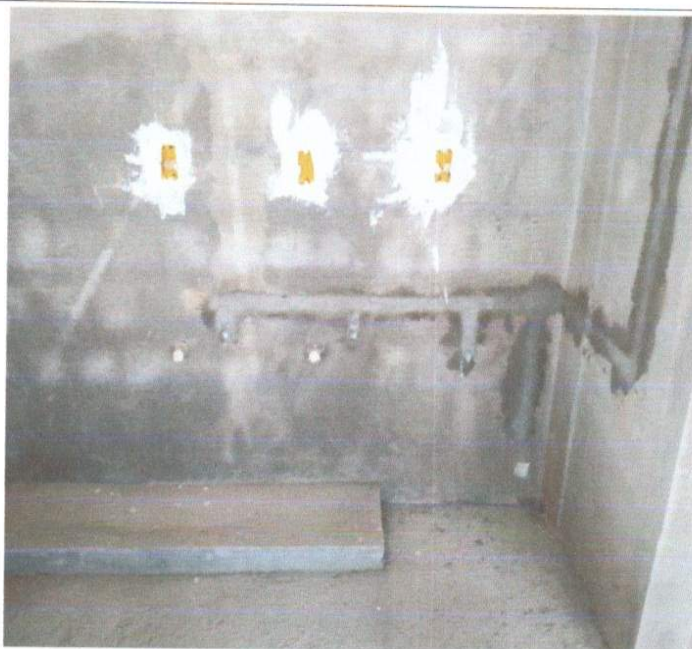
SERVIÇO DE EXECUÇÃO DE INSTALAÇÕES HIDRAULICAS – TUBOS E CONEXÕES.
