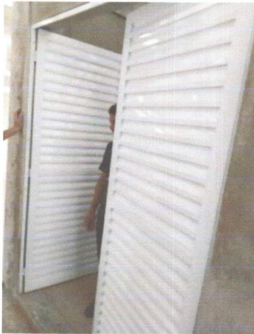
EXECUÇÃO DE ESQUADRIAS DE ALUMINIO.
