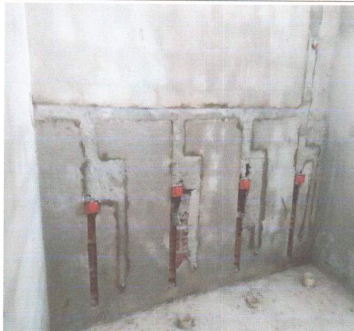
SERVIÇO DE EXECUÇÃO DE INSTALAÇÕES HIDRAULICAS – VÁLVULAS DE DESCARGA.
