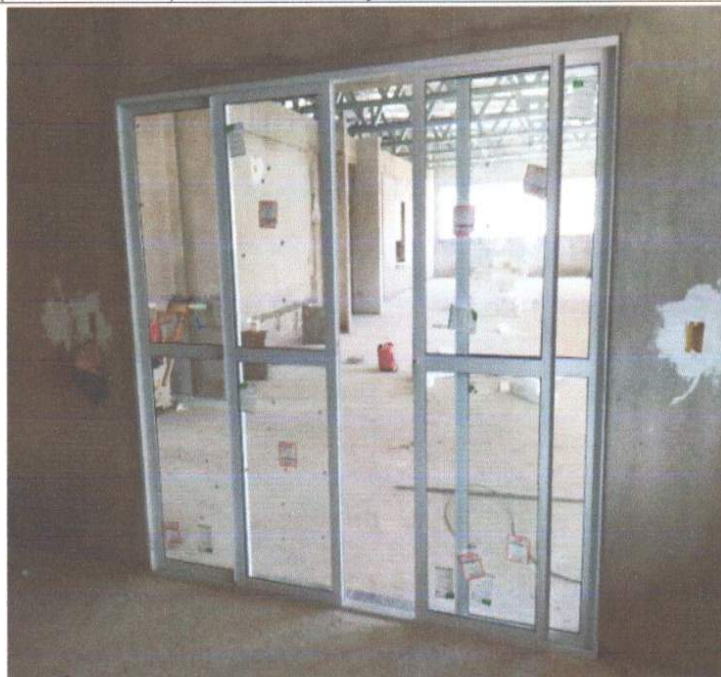
EXECUÇÃO DE ESQUADRIAS DE ALUMINIO.
