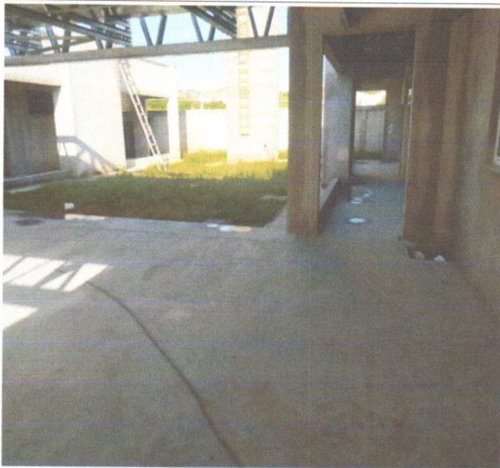
EXECUÇÃO DE PISO CIMENTADO DESEMPENADO.
