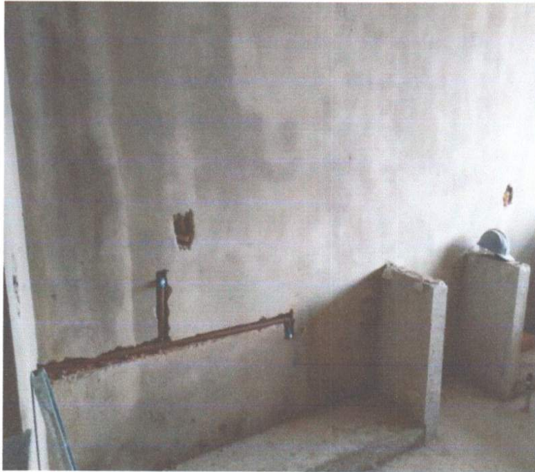
SERVIÇO DE EXECUÇÃO DE INSTALAÇÕES HIDRAULICAS – TUBOS E CONEXÕES.
