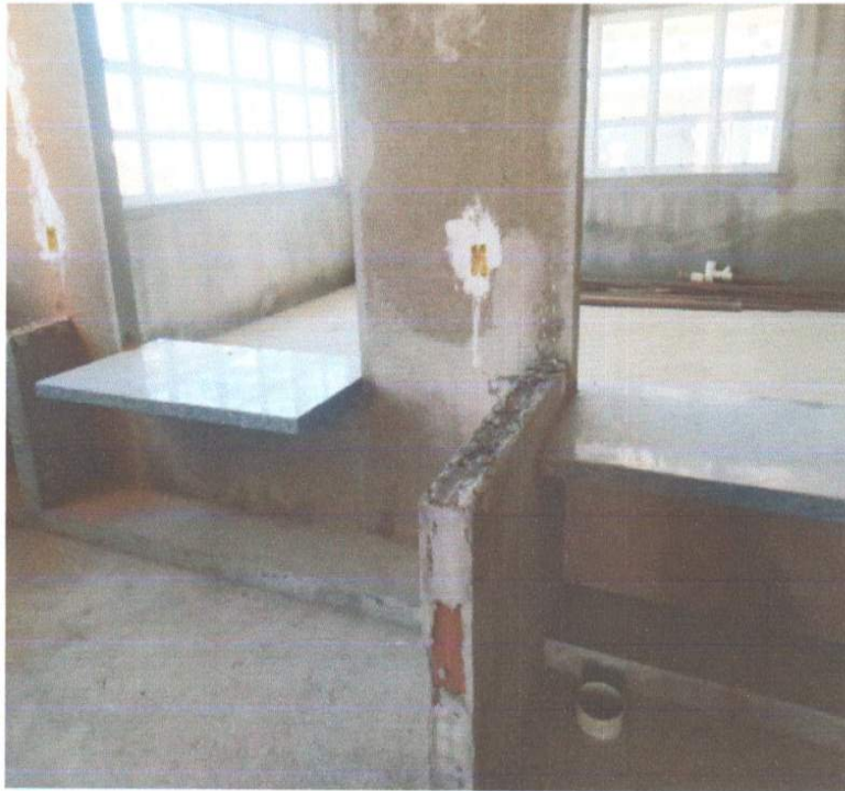
SERVIÇO DE EXECUÇÃO DE BANCADAS DE GRANITO.
