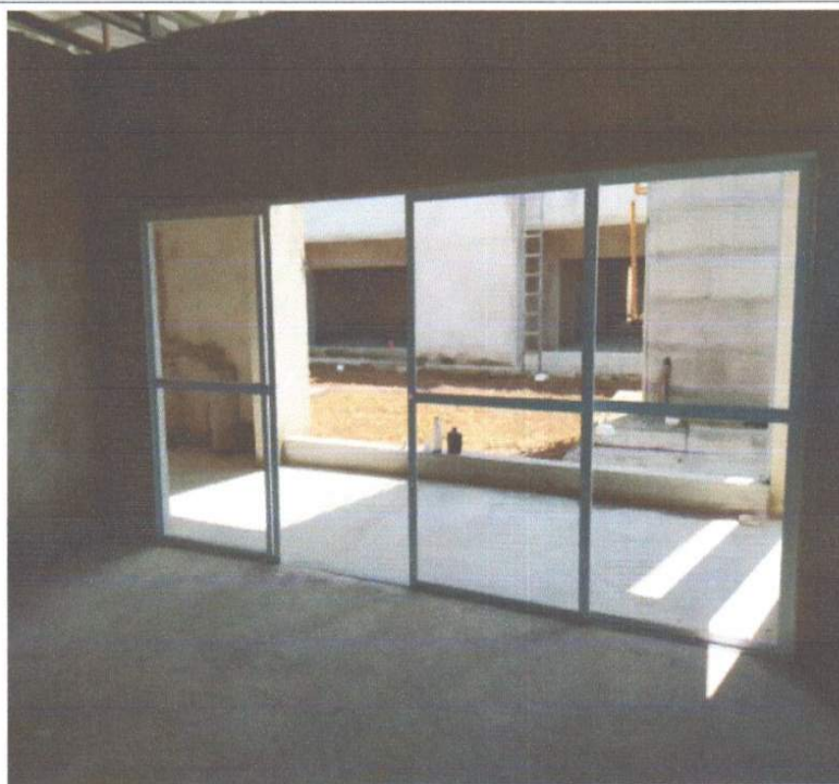
EXECUÇÃO DE ESQUADRIAS DE ALUMINIO.
