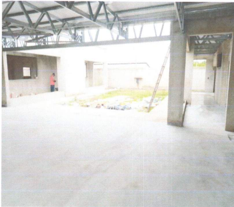
EXECUÇÃO DE PISO CIMENTADO DESEMPENADO.
