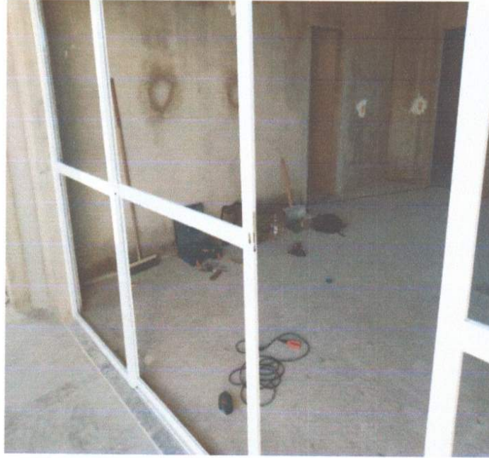
EXECUÇÃO DE ESQUADRIAS DE ALUMINIO.
