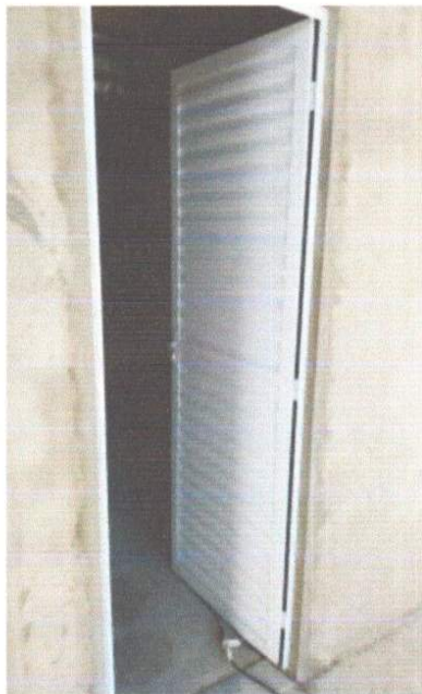
EXECUÇÃO DE ESQUADRIAS DE ALUMINIO.
