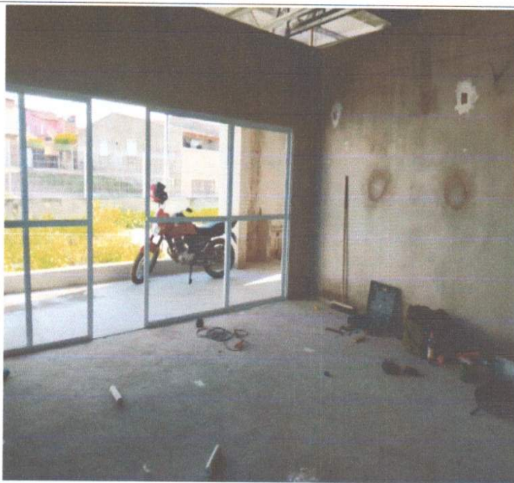
EXECUÇÃO DE ESQUADRIAS DE ALUMINIO.
