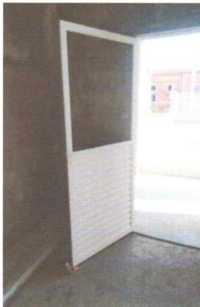
EXECUÇÃO DE ESQUADRIAS DE ALUMINIO.
