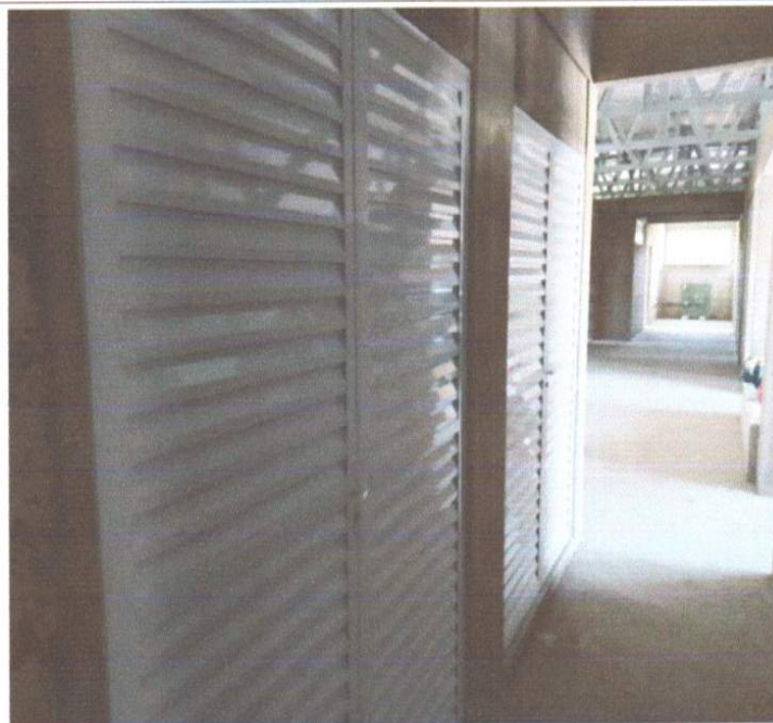
EXECUÇÃO DE ESQUADRIAS DE ALUMINIO.
