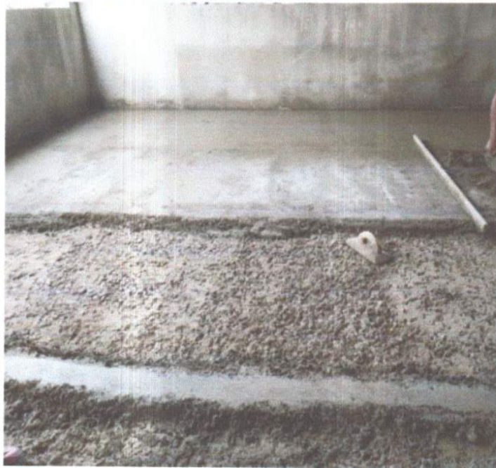
SERVIÇO DE EXECUÇÃO DE REGULARIZAÇÃO DE PISO.
