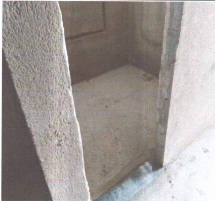
SERVIÇO DE EXECUÇÃO SOLEIRA DE GRANITO.
