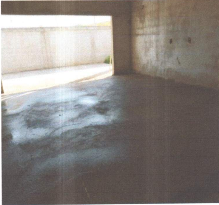
SERVIÇO DE EXECUÇÃO DE REGULARIZAÇÃO DE PISO.
