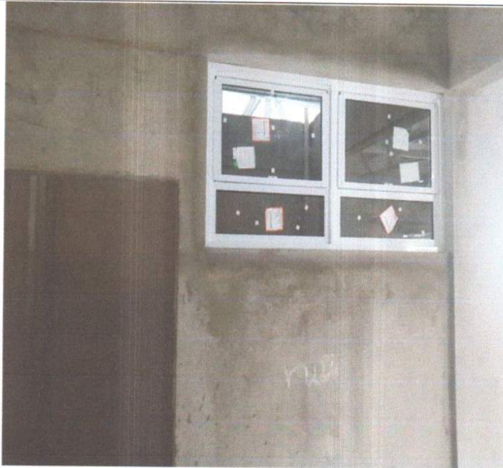
EXECUÇÃO DE ESQUADRIAS DE ALUMINIO.
