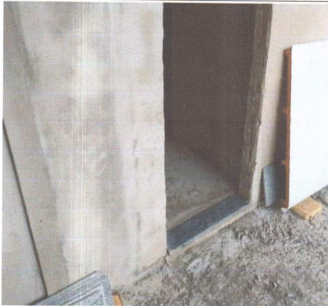
SERVIÇO DE EXECUÇÃO DE SOLEIRA DE GRANITO.
