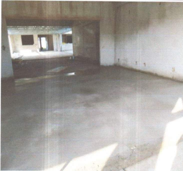
SERVIÇO DE EXECUÇÃO DE REGULARIZAÇÃO DE PISO.
