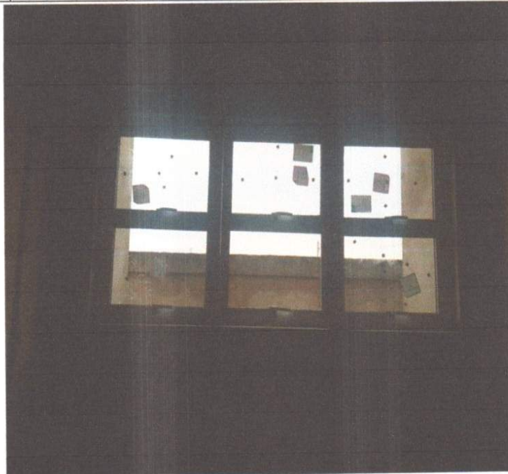
EXECUÇÃO DE ESQUADRIAS DE ALUMINIO.
