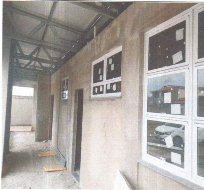
EXECUÇÃO DE ESQUADRIAS DE ALUMINIO.
