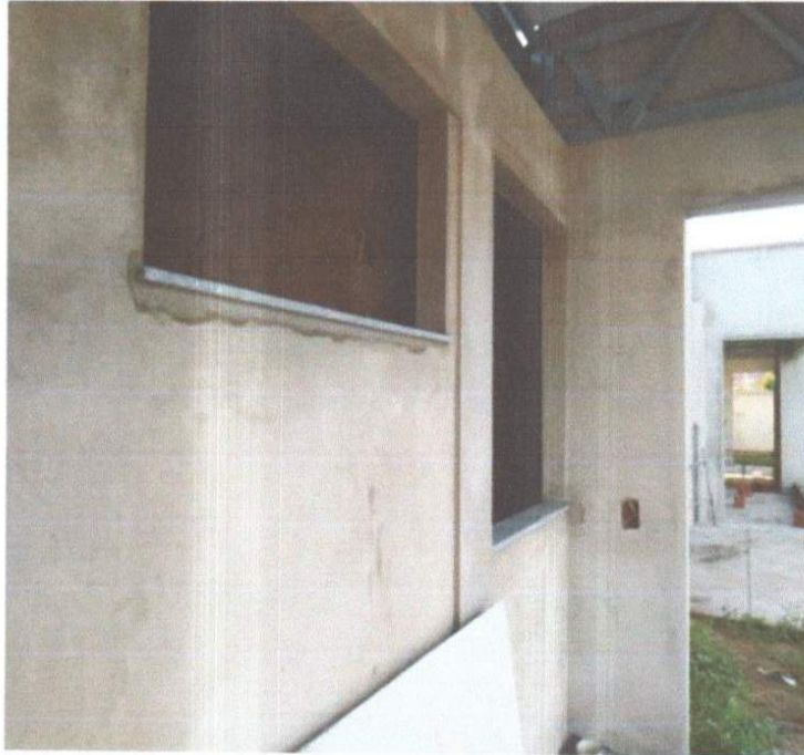
SERVIÇO DE EXECUÇÃO DE PEITORIL DE GRANITO.
