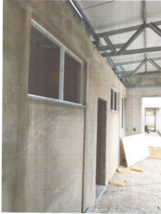
EXECUÇÃO DE ESQUADRIAS DE ALUMINIO.
