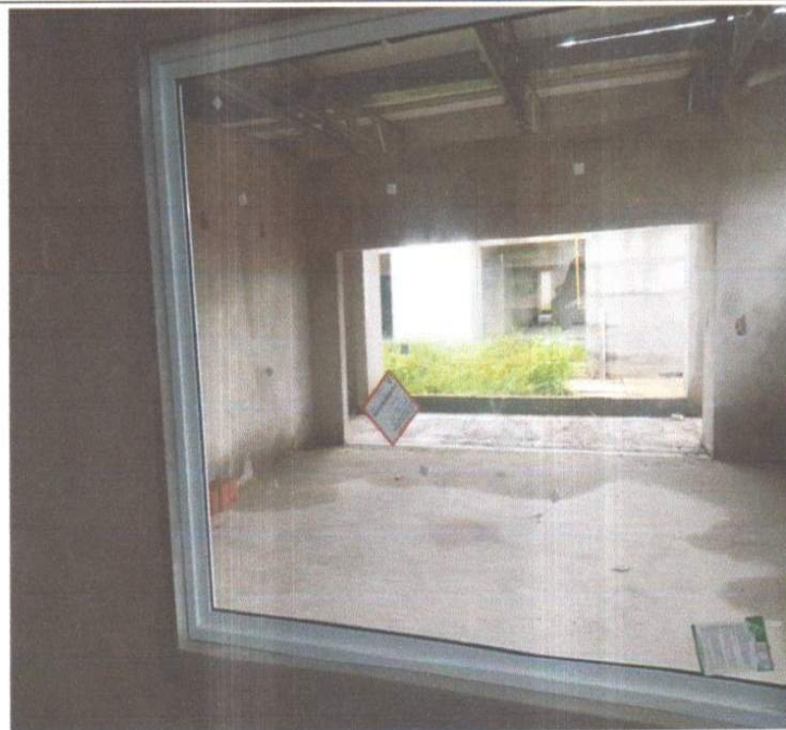
EXECUÇÃO DE ESQUADRIAS DE ALUMINIO.
