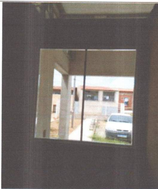
EXECUÇÃO DE ESQUADRIAS DE ALUMINIO.
