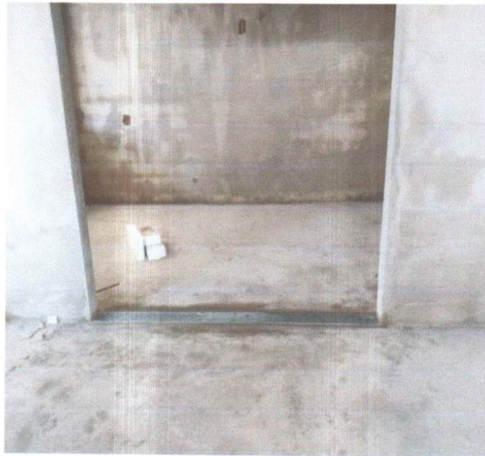
SERVIÇO DE EXECUÇÃO DE SOLEIRA DE GRANITO.
