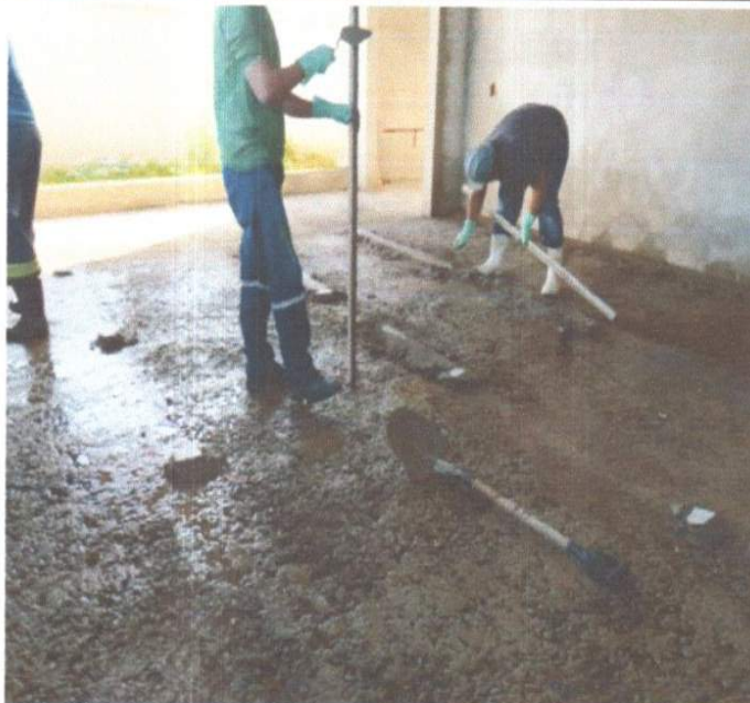
SERVIÇO DE EXECUÇÃO DE REGULARIZAÇÃO DE PISO.
