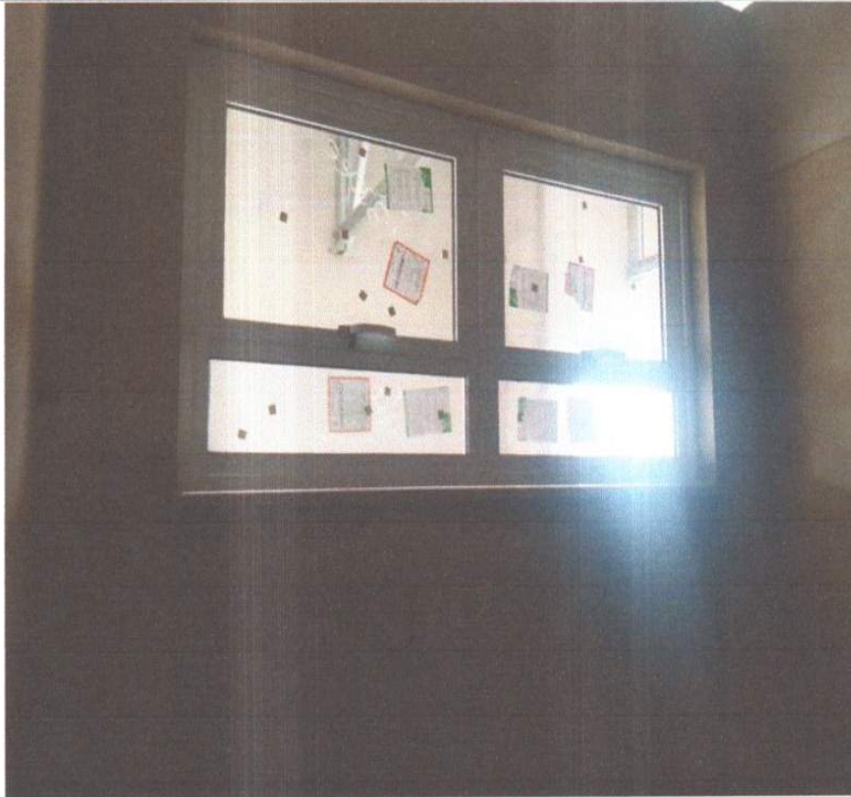
EXECUÇÃO DE ESQUADRIAS DE ALUMINIO.
