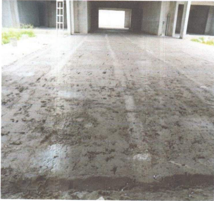
SERVIÇO DE EXECUÇÃO DO PISO DO PÁTIO.
