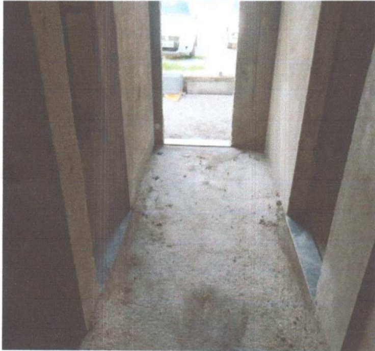
SERVIÇO DE EXECUÇÃO SOLEIRA DE GRANITO.
