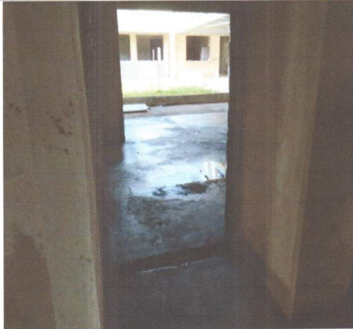
SERVIÇO DE EXECUÇÃO DE REGULARIZAÇÃO DE PISO.
