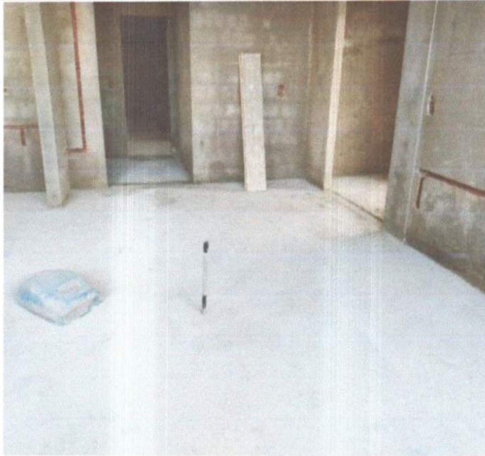
SERVIÇO DE EXECUÇÃO DE REGULARIZAÇÃO DE PISO.
