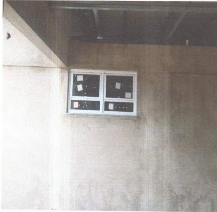
EXECUÇÃO DE ESQUADRIAS DE ALUMINIO.
