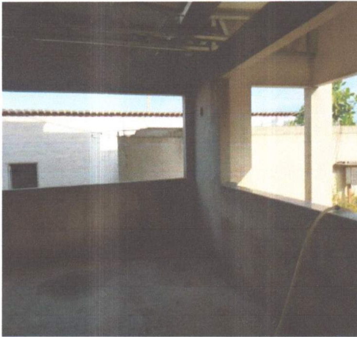
SERVIÇO DE EXECUÇÃO DE PEITORIL DE GRANITO.
