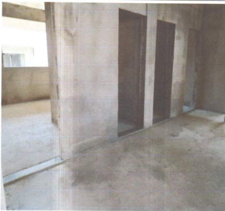
SERVIÇO DE EXECUÇÃO DE SOLEIRA DE GRANITO.
