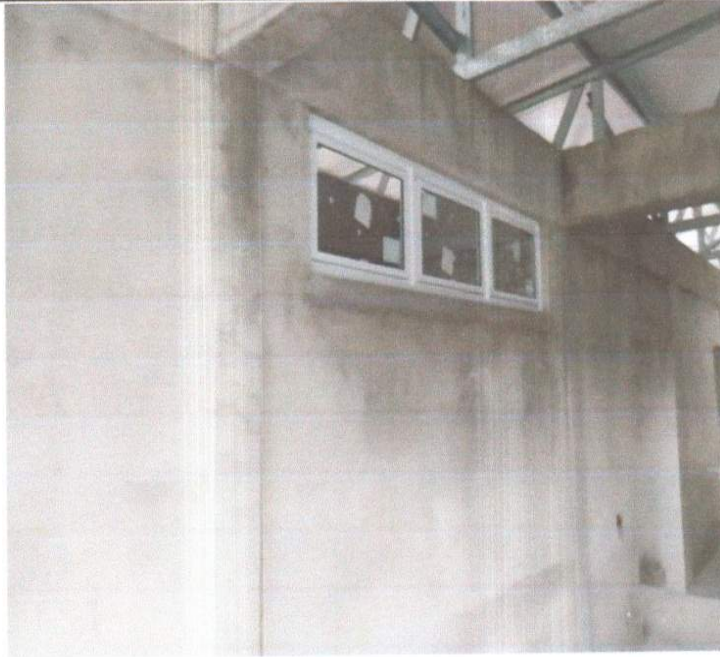
EXECUÇÃO DE ESQUADRIAS DE ALUMINIO.
