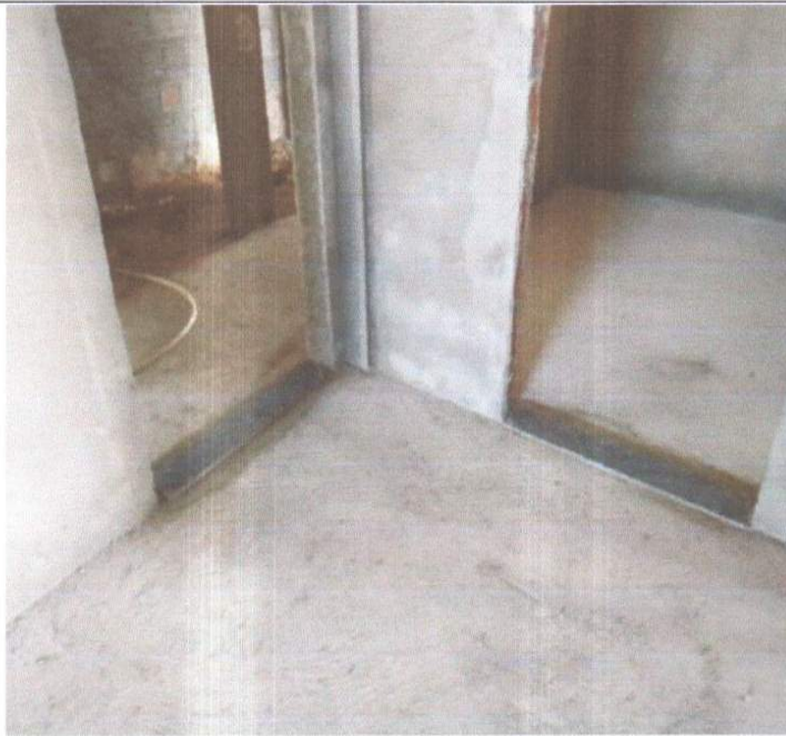
SERVIÇO DE EXECUÇÃO DE SOLEIRA DE GRANITO.
