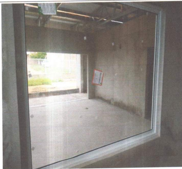
EXECUÇÃO DE ESQUADRIAS DE ALUMINIO.
