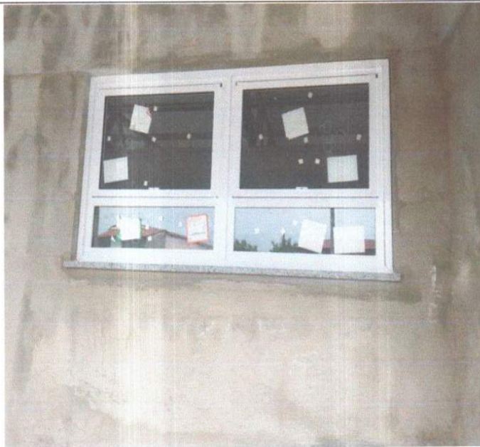
EXECUÇÃO DE ESQUADRIAS DE ALUMINIO.
