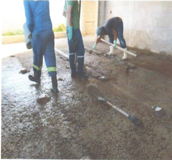
SERVIÇO DE EXECUÇÃO DE REGULARIZAÇÃO DE PISO.
