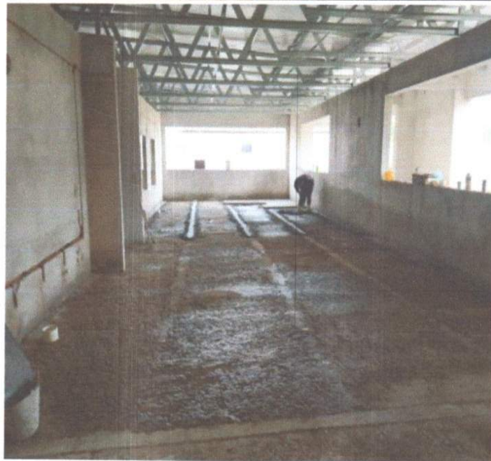
SERVIÇO DE EXECUÇÃO DE REGULARIZAÇÃO DE PISO.
