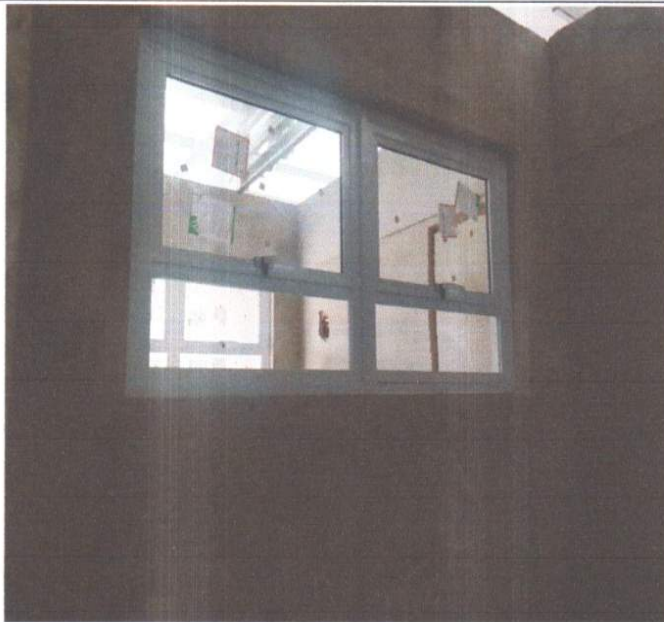
EXECUÇÃO DE ESQUADRIAS DE ALUMINIO.
