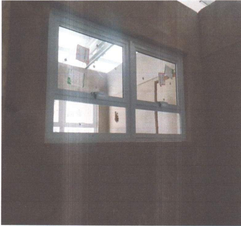
EXECUÇÃO DE ESQUADRIAS DE ALUMINIO.
