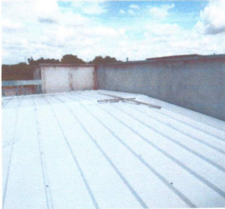
EXECUÇÃO DA MONTAGEM DE TELHAS SANDUICHE.
