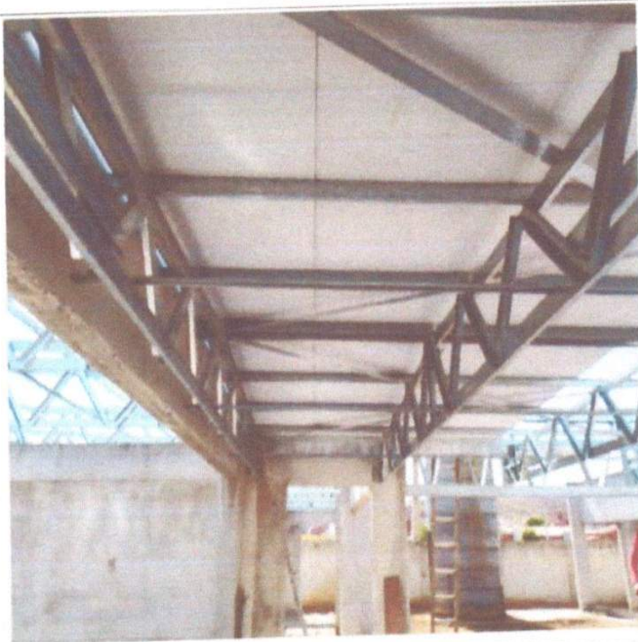
EXECUÇÃO DA MONTAGEM DE TELHAS SANDUICHE.
