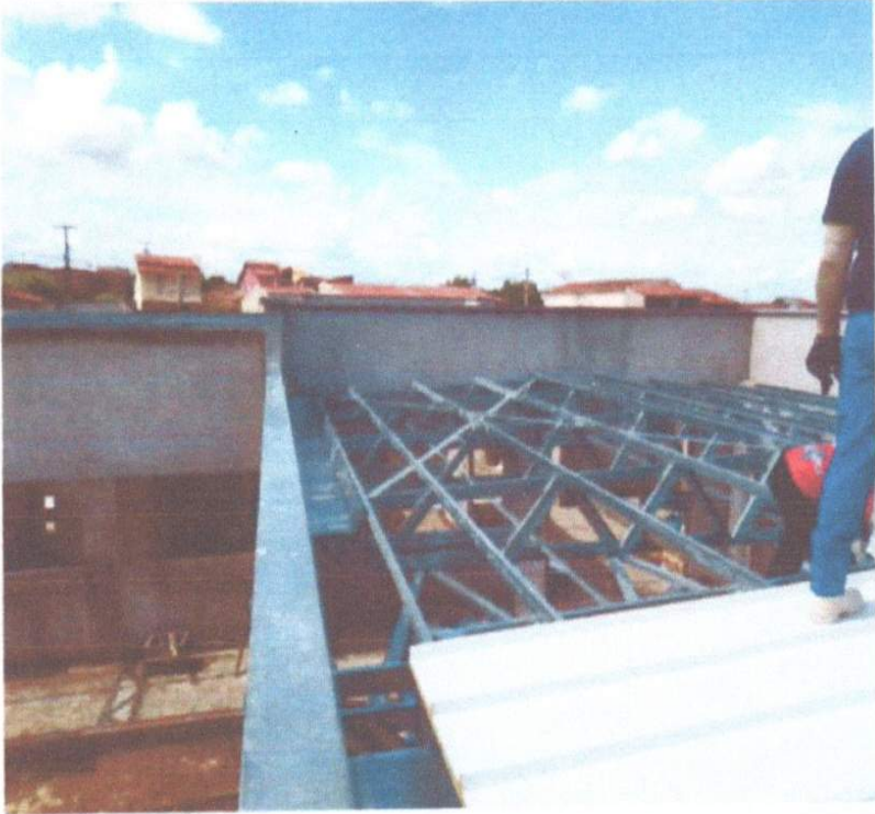
EXECUÇÃO DA MONTAGEM DE TELHAS SANDUICHE.
