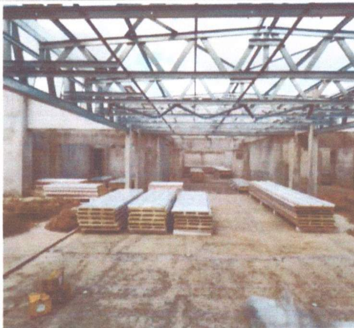
SERVIÇO DE EXECUÇÃO DE COBERTURA COM TELHA SANDUÍCHE – RECEBIMENTO DO MATERIAL.
