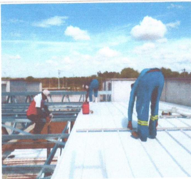
EXECUÇÃO DO SERVIÇO DE MONTAGEM DA COBERTURA COM TELHA SANDUICHE.
