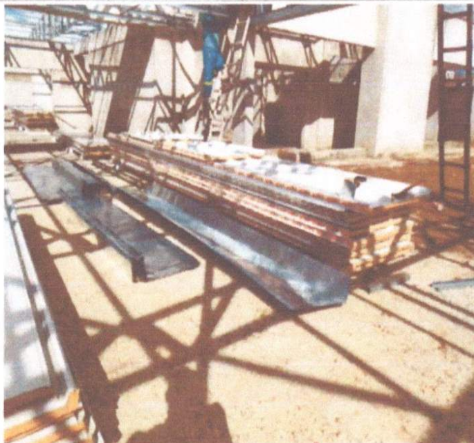
RECEBIMENTO DO MATERIAL PARA COBERTURA, RUFOS E TELHAS.
