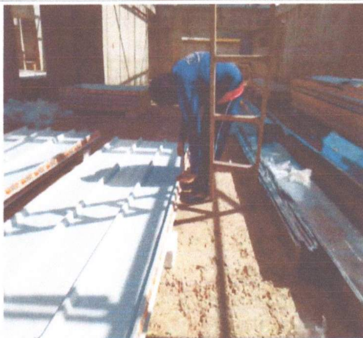
SERVIÇO DE PREPARAÇÃO DAS TELHAS PARA MONTAGEM – COLOCAÇÃO DA FITA TACKY TAPE.
