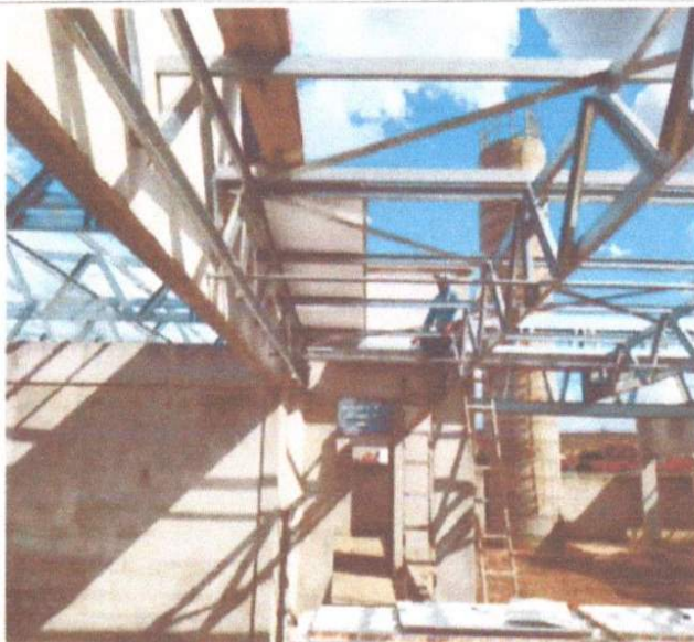
EXECUÇÃO DO SERVIÇOS DE MONTAGEM DA COBERTURA COM TELHA SANDUICHE.
