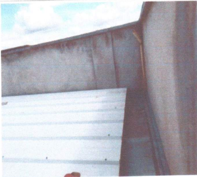
EXECUÇÃO DA MONTAGEM DE TELHAS SANDUICHE.
