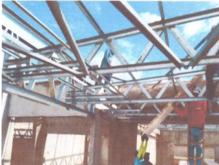
SERVIÇO DE PREPARAÇÃO DAS TELHAS PARA MONTAGEM – COLOCAÇÃO DA FITA TACKY TAPE.
