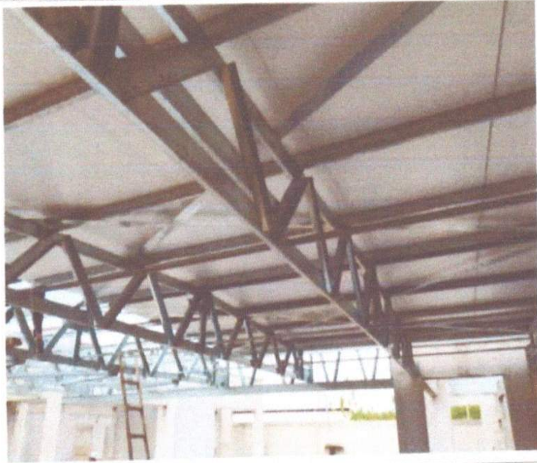
EXECUÇÃO DA MONTAGEM DE TELHAS SANDUICHE.
