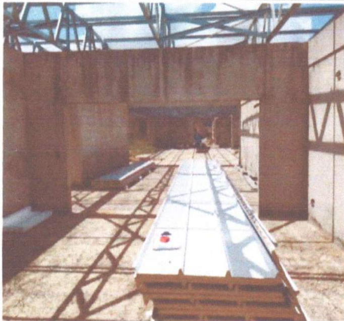
SERVIÇO DE EXECUÇÃO DE COBERTURA COM TELHA SANDUÍCHE – RECEBIMENTO DO MATERIAL.
