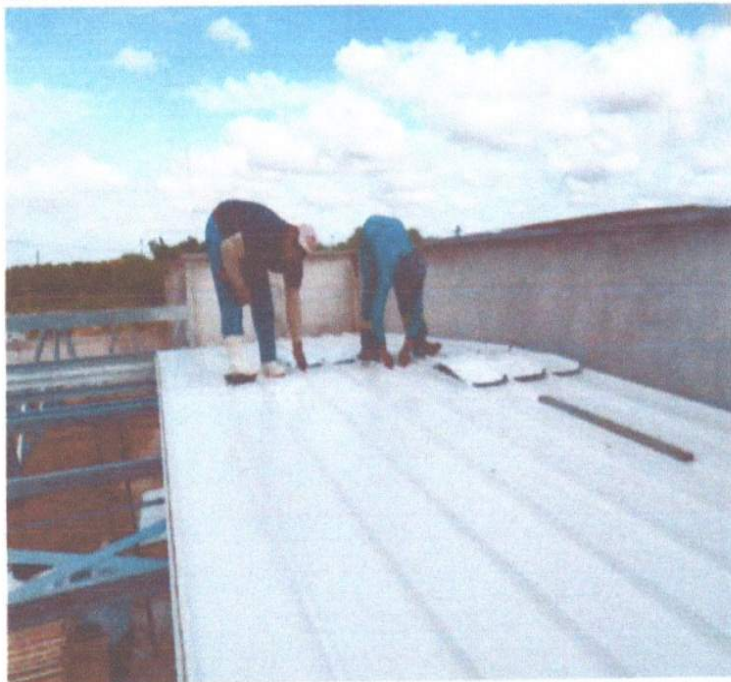
EXECUÇÃO DO SERVIÇO DE MONTAGEM DA COBERTURA COM TELHA SANDUICHE E CUMEEIRA.
