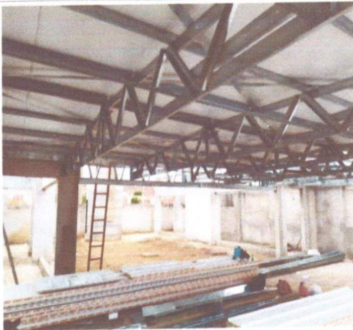
EXECUÇÃO DA MONTAGEM DE TELHAS SANDUICHE.
