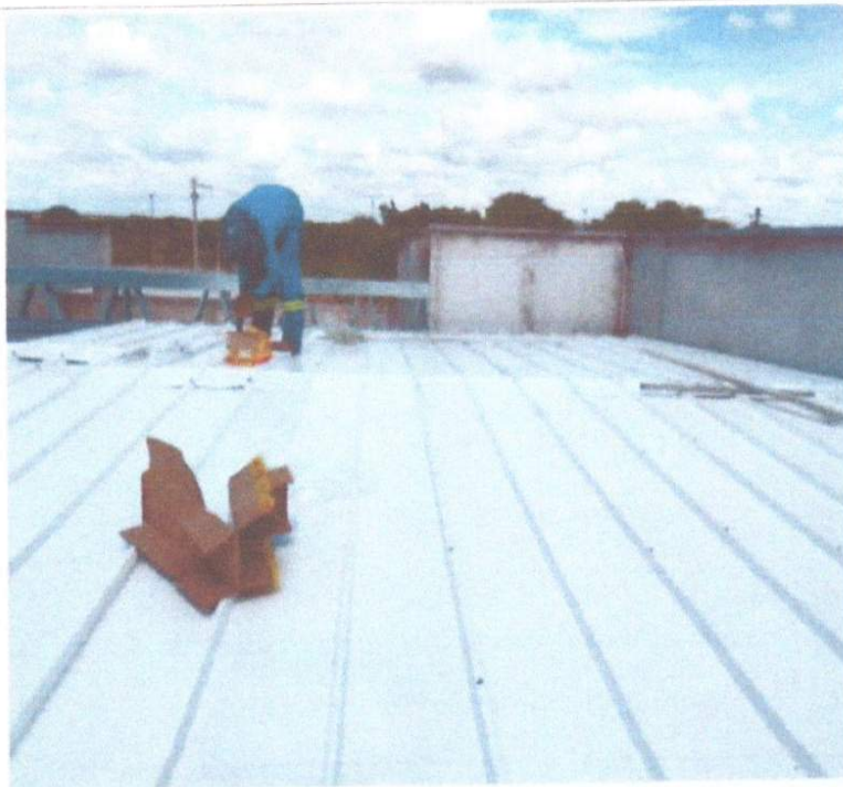
EXECUÇÃO DA MONTAGEM DE TELHAS SANDUICHE.
