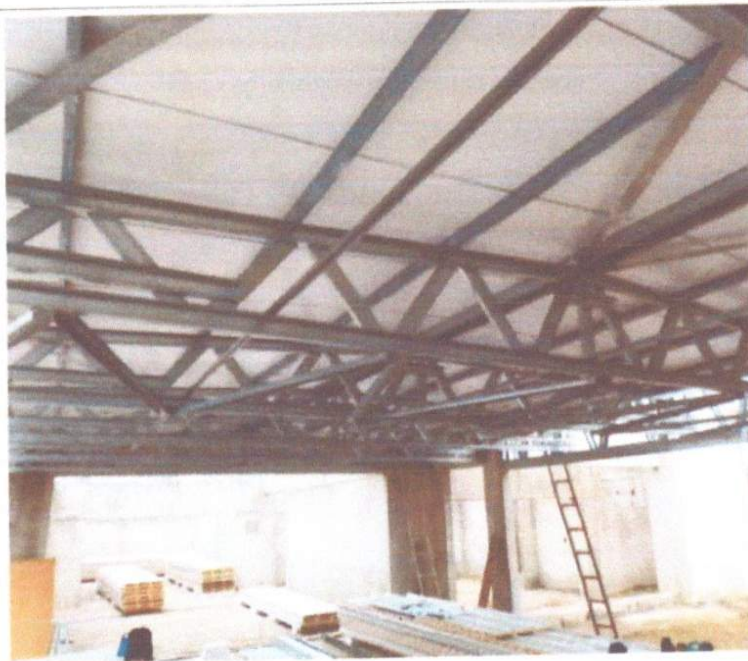
EXECUÇÃO DA MONTAGEM DE TELHAS SANDUICHE.
