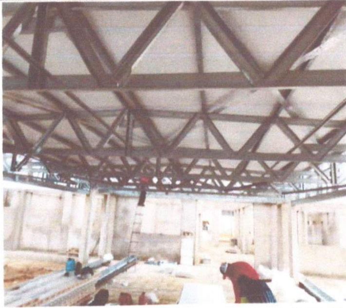
EXECUÇÃO DA MONTAGEM DE TELHAS SANDUICHE.
