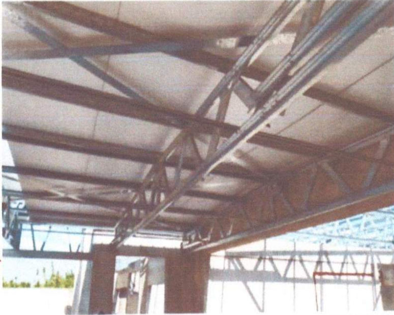
EXECUÇÃO DA MONTAGEM DE TELHAS SANDUICHE.
