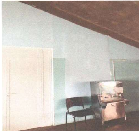
Fechamento das áreas de cobogós em gesso acartonado.
