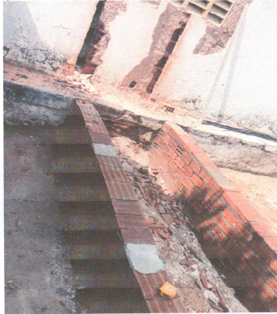
Construção de rampa de acessibilidade.
