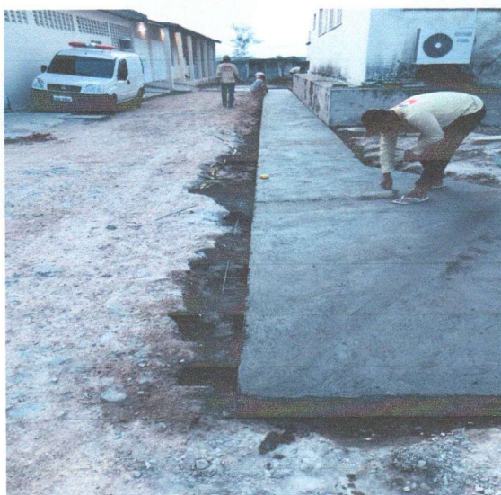
Construção do piso de concreto.
