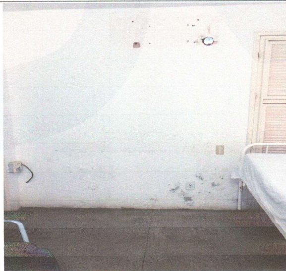
Paredes a receber pintura látex.
