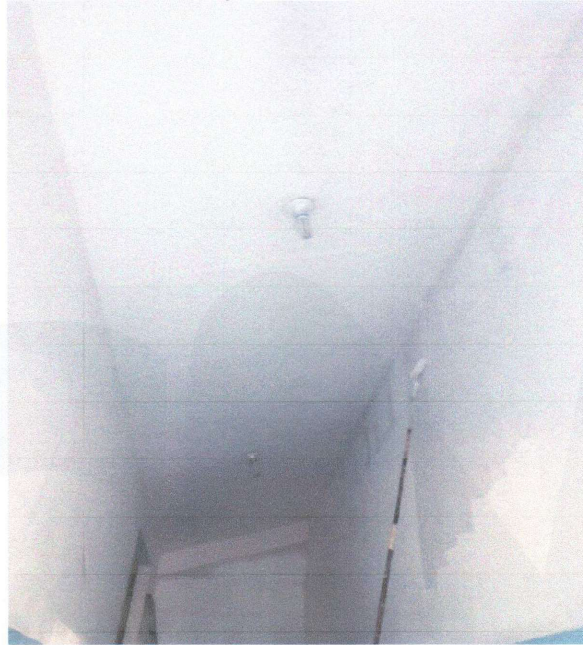
Pintura de parede e teto, tinta látex.
