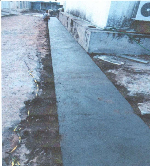
Construção do piso de concreto.
