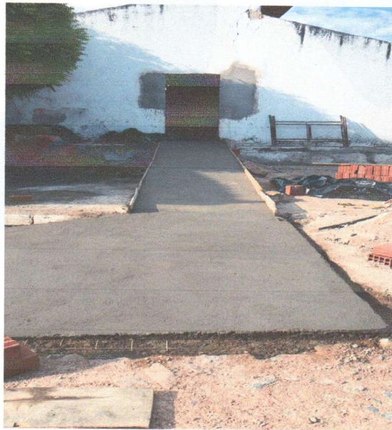
Construção de rampa de acessibilidade.
