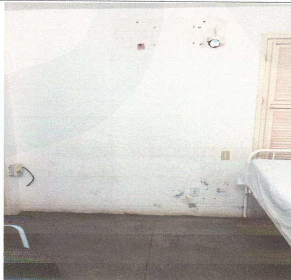
Paredes a receber pintura látex.
