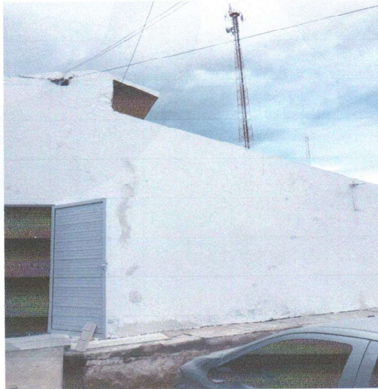
Porta de acesso a rampa (vista externa).
