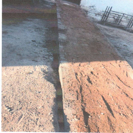
Construção de rampa de acessibilidade.
