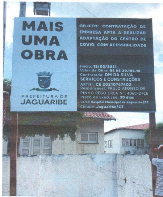
Placa de obra.
