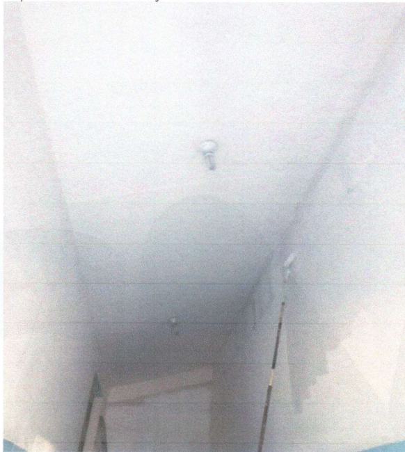
Pintura de parede e teto, tinta látex.
