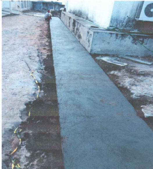
Construção do piso de concreto.
