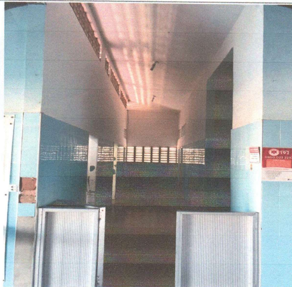
Porta a ser substituída.
