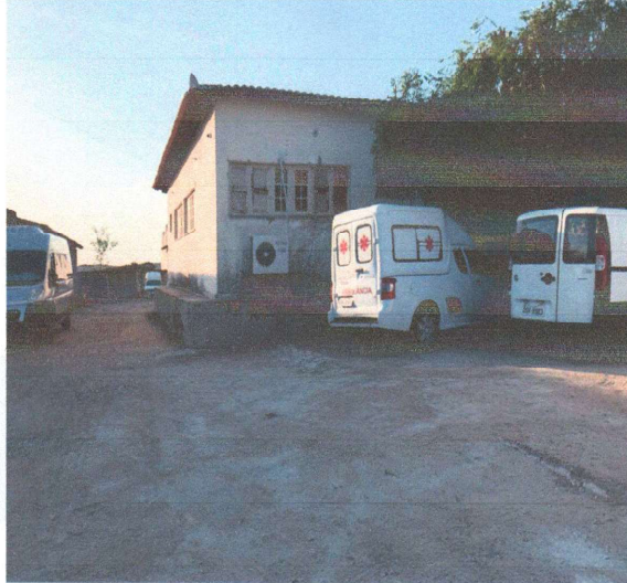
Local a ser construído piso de concreto dá acesso a ala COVID 19.
