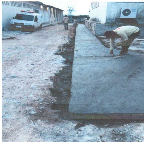
Construção do piso de concreto.
