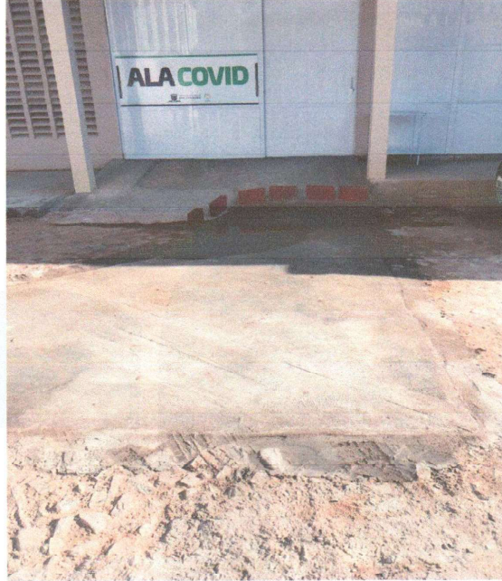
Piso de acessibilidade construído
