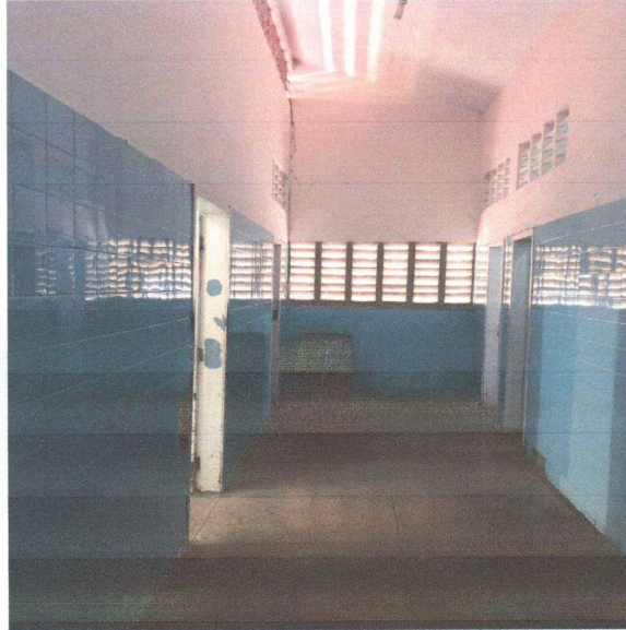
Parede a ser demolida.
