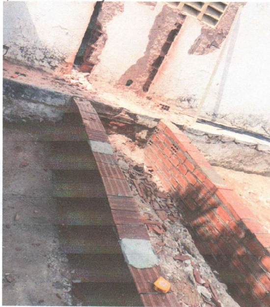
Construção de rampa de acessibilidade.
