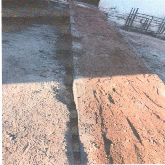
Construção de rampa de acessibilidade.
