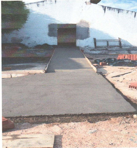
Construção de rampa de acessibilidade.
