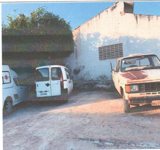
Local a ser construído a rampa de acessibilidade.
