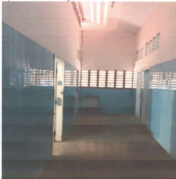
Parede a ser demolida.
