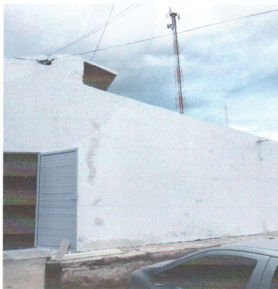
Porta de acesso a rampa (vista externa).
