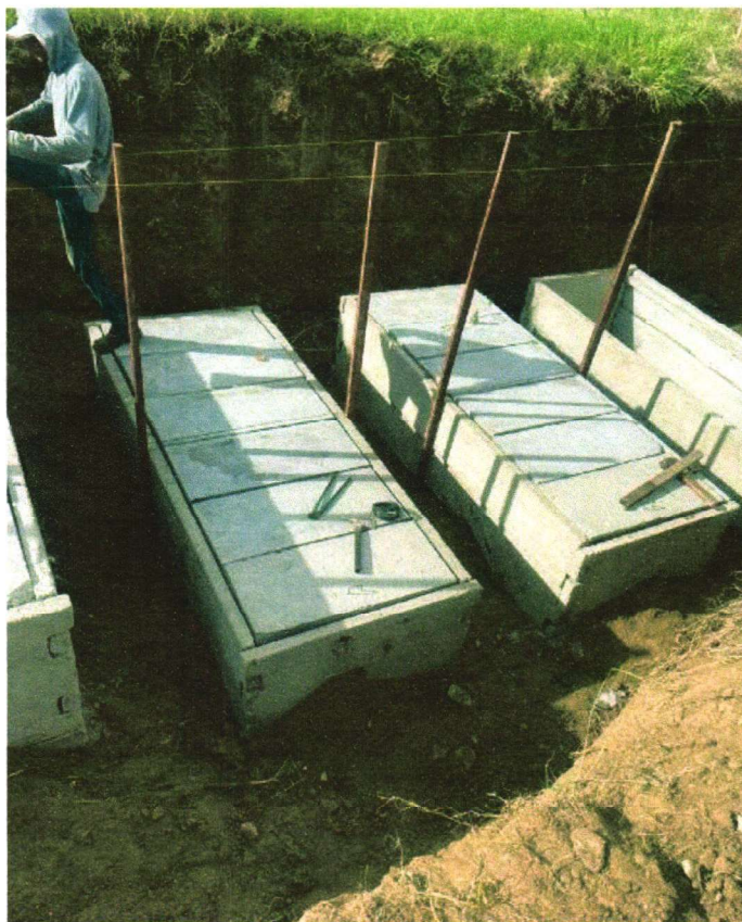
INSTALAÇÃO DO PRÉ-MOLDADO
