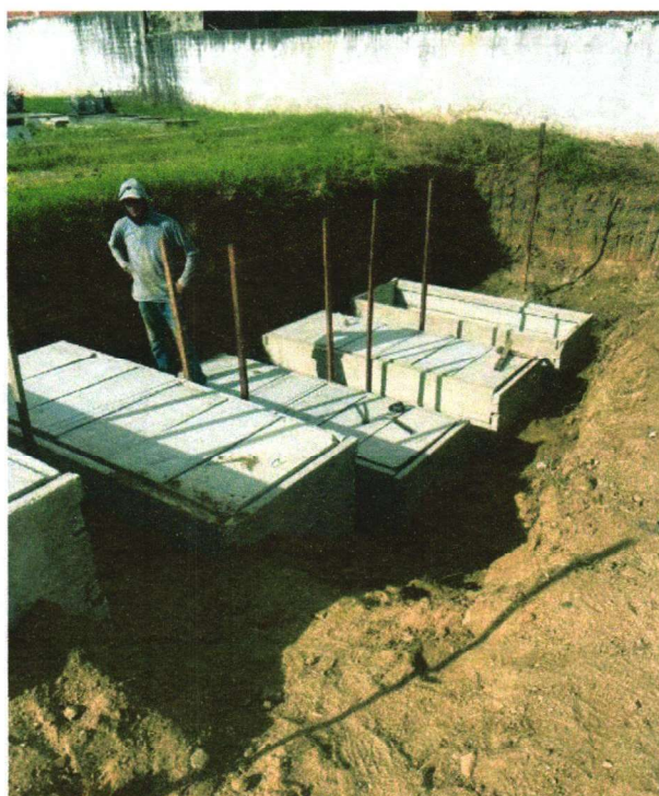
INSTALAÇÃO DO PRÉ-MOLDADO
