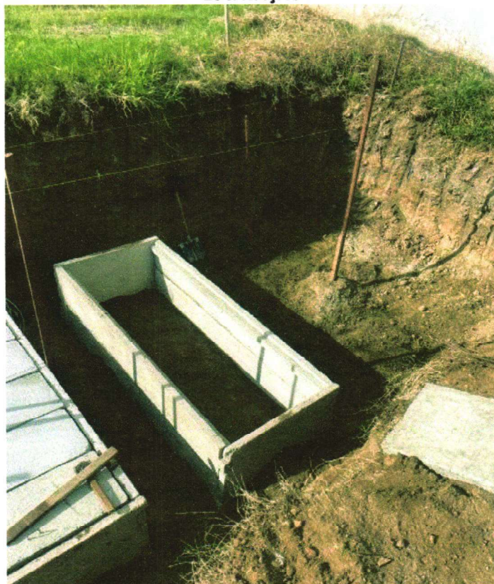
INSTALAÇÃO DO PRÉ-MOLDADO
