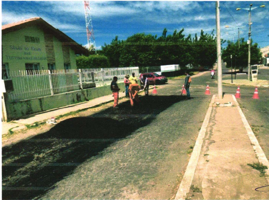
LANÇAMENTO DA MASSA ASFÁLTICA
