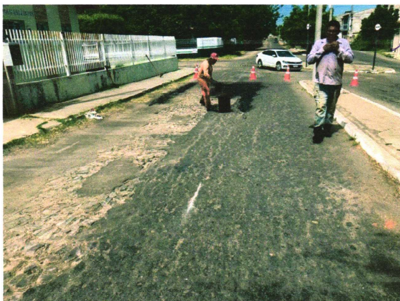
APLICAÇÃO DA EMULSÃO ASFÁLTICA
