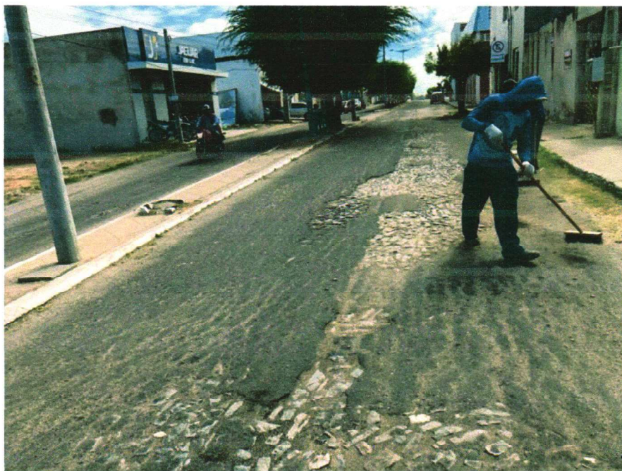
LIMPEZA DA ÁREA
