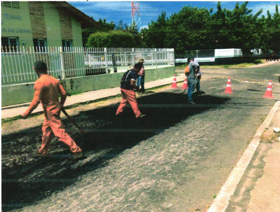
LANÇAMENTO DA MASSA ASFÁLTICA
