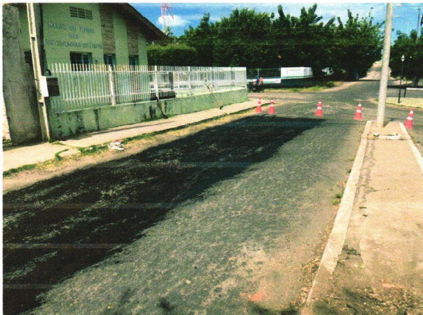
APLICAÇÃO DA EMULSÃO ASFÁLTICA
