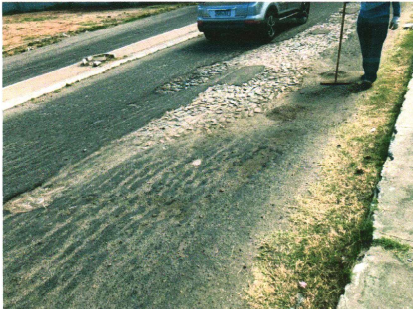
LIMPEZA DA ÁREA
