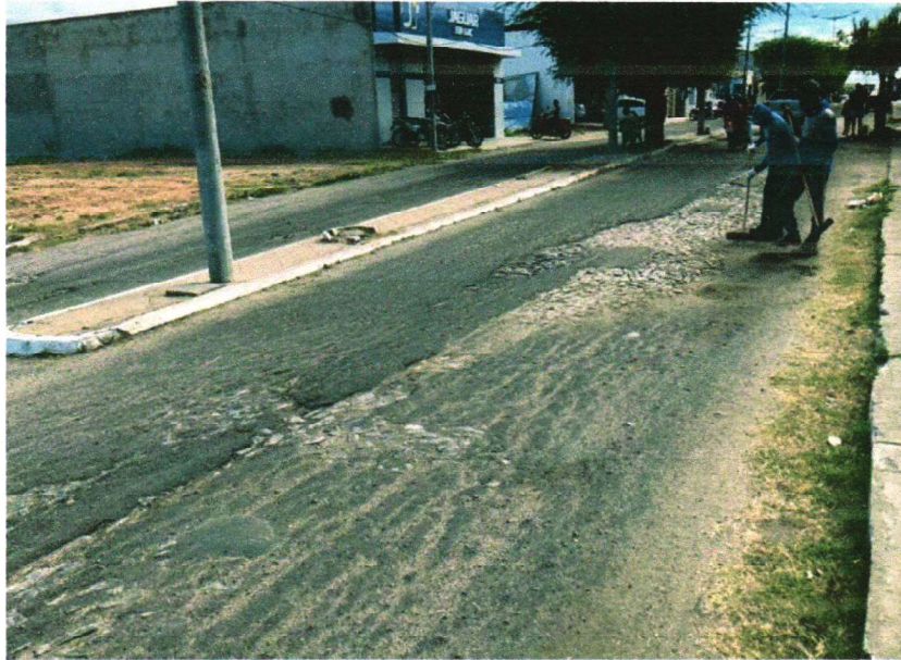
LIMPEZA DA ÁREA
