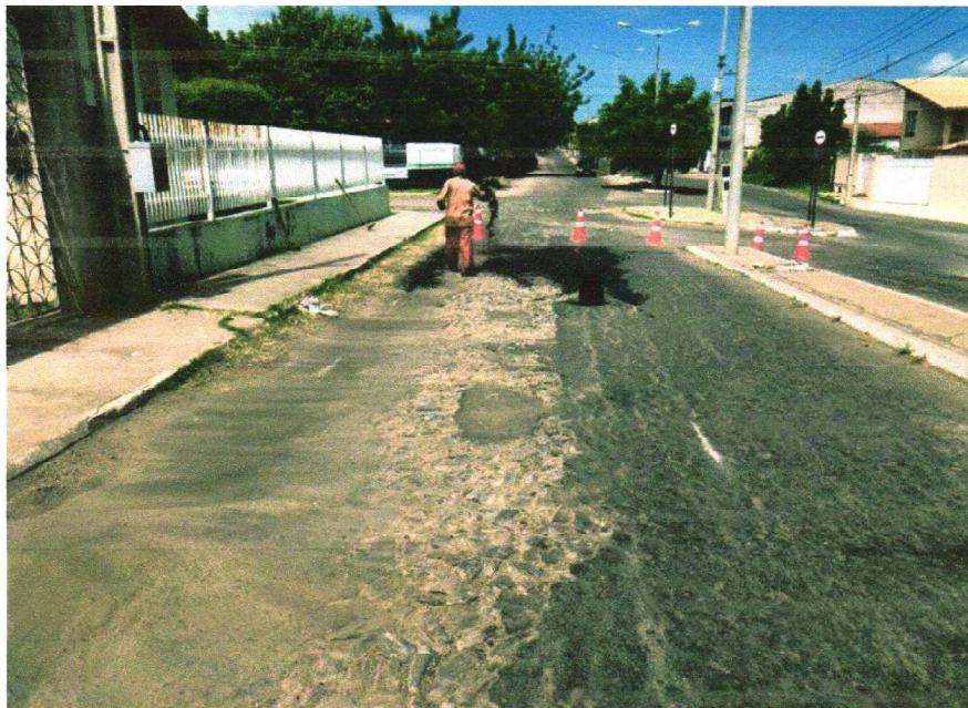
APLICAÇÃO DA EMULSÃO ASFÁLTICA
