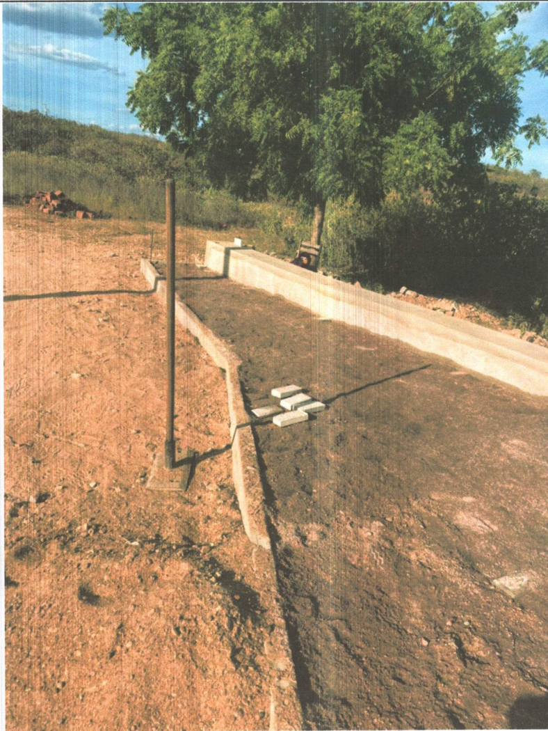
CONSTRUÇÃO DO MURO DE ARRIMO – 11/08/2022 a 19/08/2022
